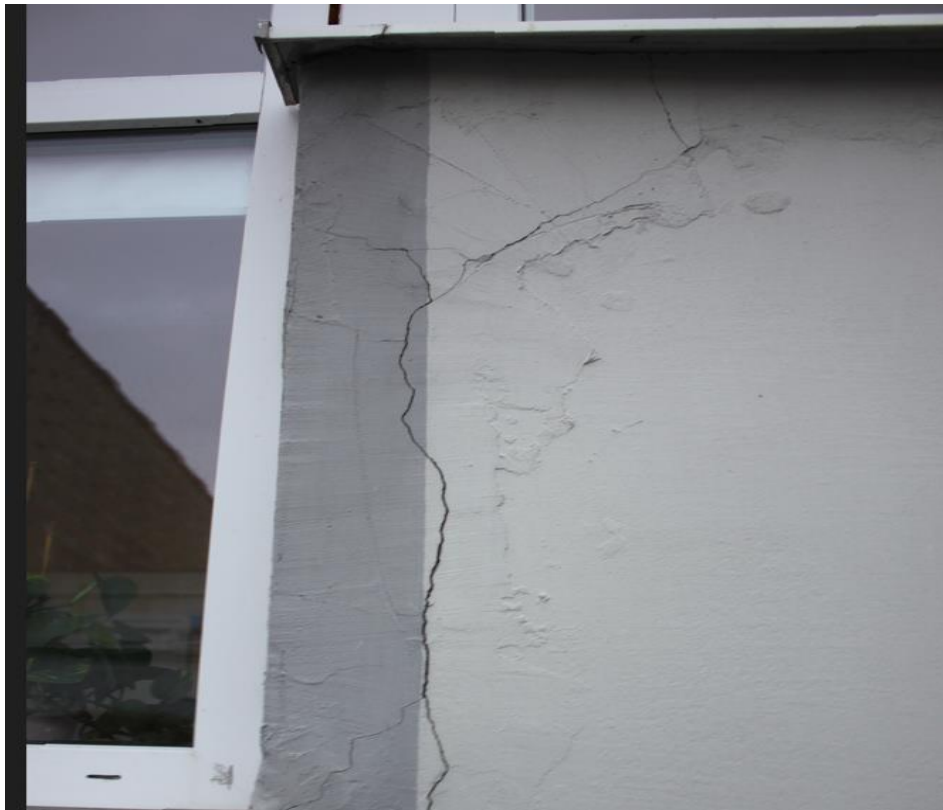
Fot. 7. – widoczne powtarzające się zarysowania tynków na ścianie zewnętrznej
