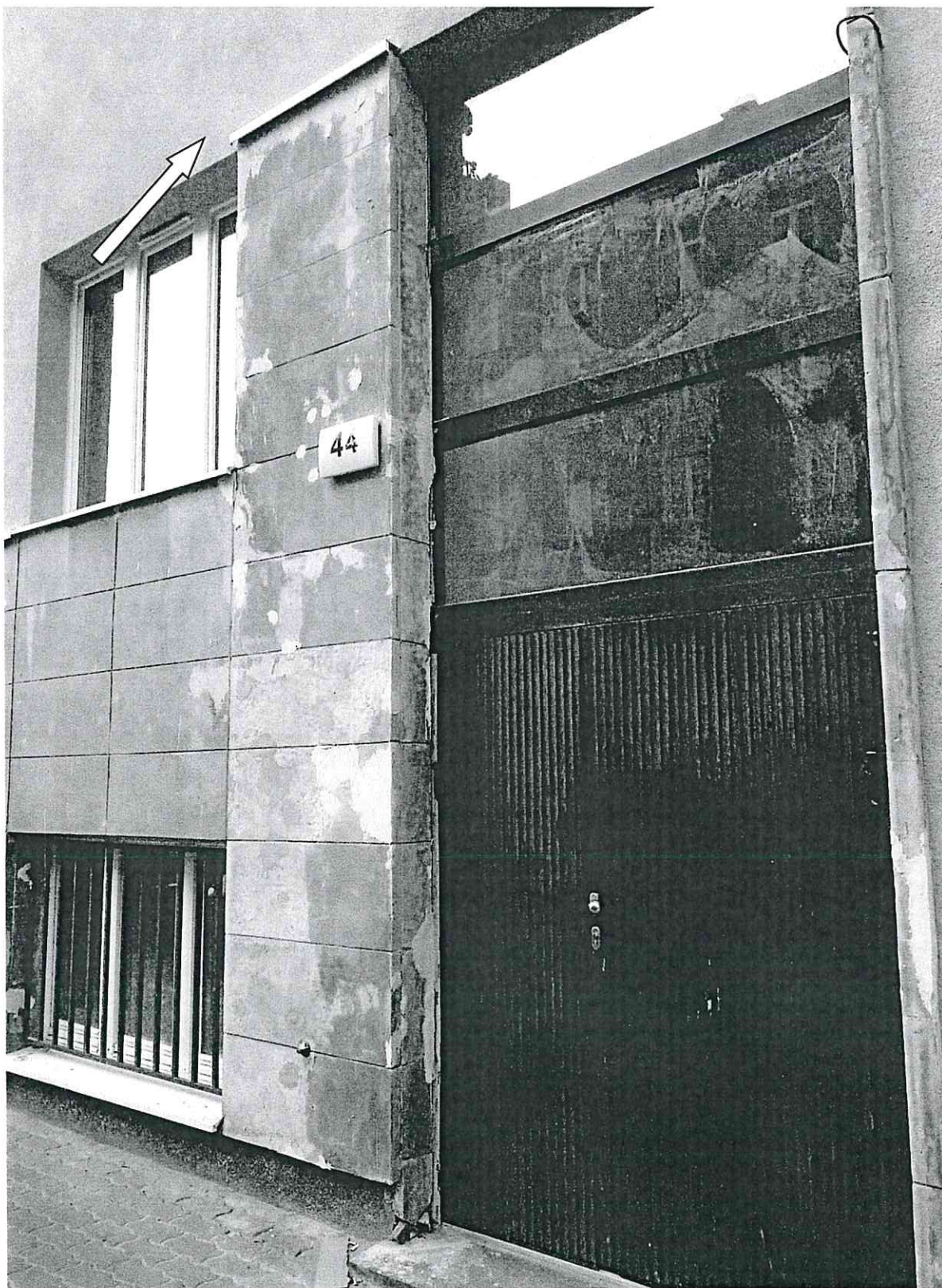
fot.16 Oznaczono wtórne, nieestetyczne opierzenia płyt z piaskowca
