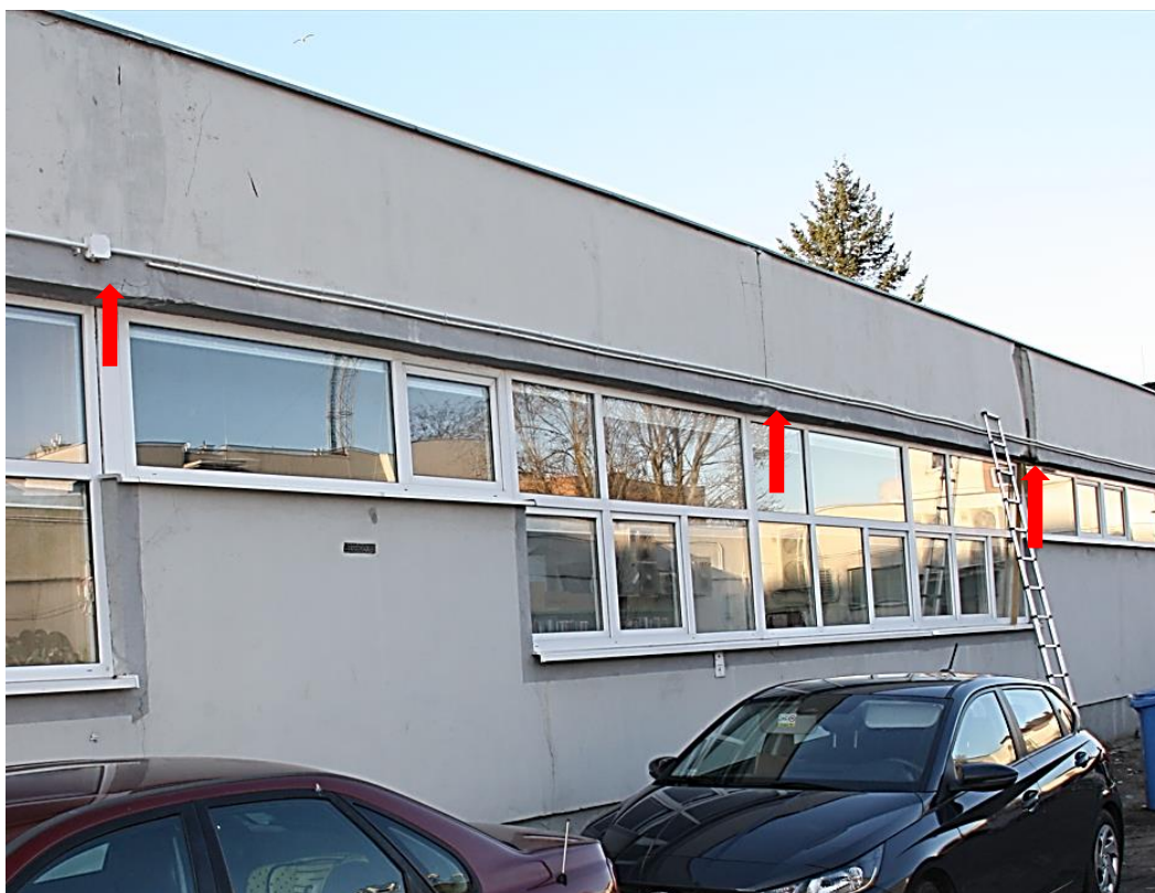
Fot. 4. – widoczne powtarzające się zarysowania tynków w miejscach łączenia ścian attyki (rygli)
