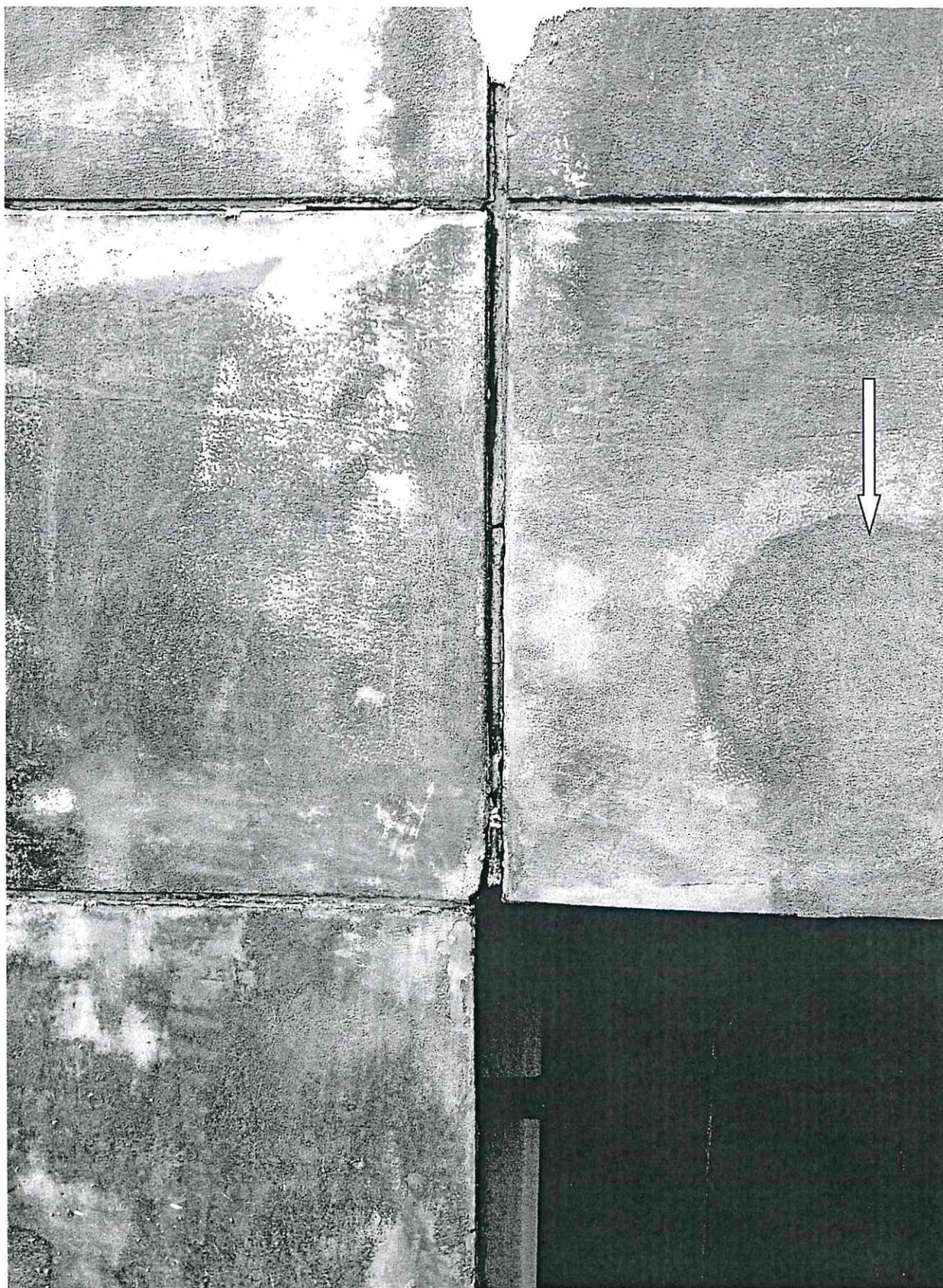
fot.14 Płyty po wstępnym oczyszczeniu, obok zabrudzeń w porach kamienia zachowały się trudne do usunięcia pozostałości mleczka cementowego.
