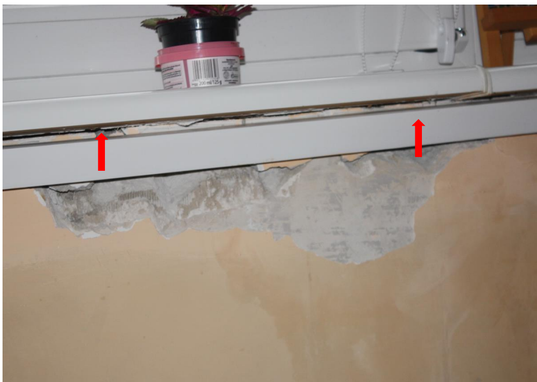
Fot. 16. – szpara pod podokiennikiem wewnętrznym
