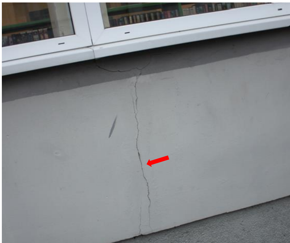
Fot. 8. – widoczne powtarzające się zarysowania tynków w strefie cokołowej w miejscach występowania konstrukcji nośnej;
