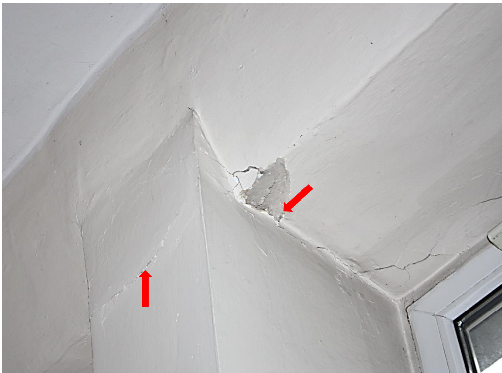
Fot. 13. – zarysowanie nienośnego słupa w pomieszczeniu korytarzyka;
