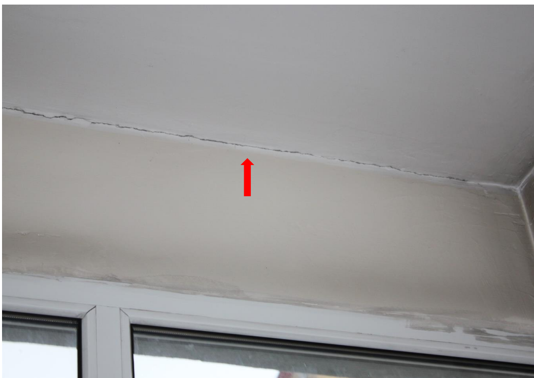
Fot. 10. – zarysowanie przy suficie w Sali zajęciowej powstałe wskutek braku izolacji termicznej ścian zewnętrznych i attyki.
