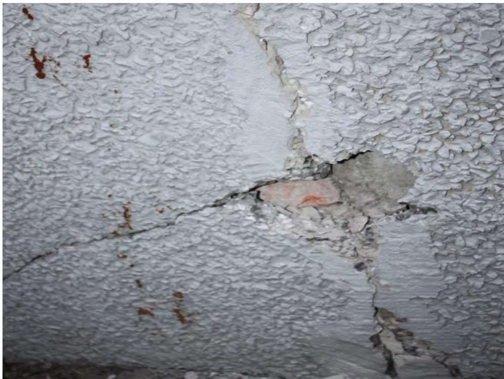
Fot. 6. – widoczne powtarzające się zarysowania tynków w strefie cokołowej w miejscach łączenia murowanego cokołu z żelbetowymi prefabrykowanymi słupami konstrukcji nośnej.
