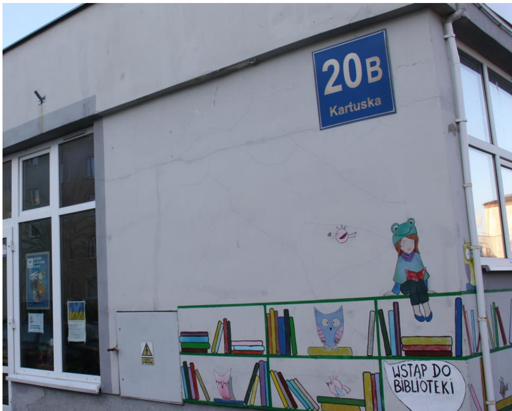
Fot. 9. – zarysowanie siatkowe na tynku ściany zewnętrznej (elewacja południowa)
