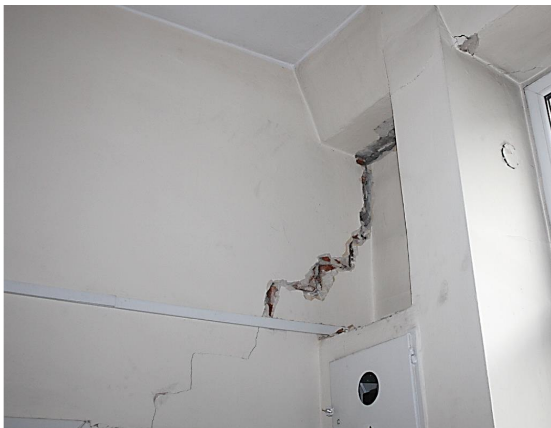
Fot. 14. – zarysowanie na ścianie działowej od strony korytarzyka w obrębie otworu drzwiowego;
