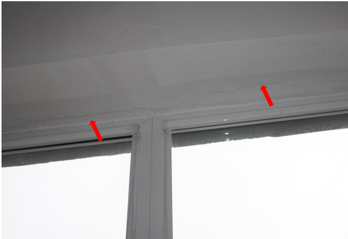
Fot. 11. – zarysowanie tynku w ościeżu okiennym wewnątrz budynku
