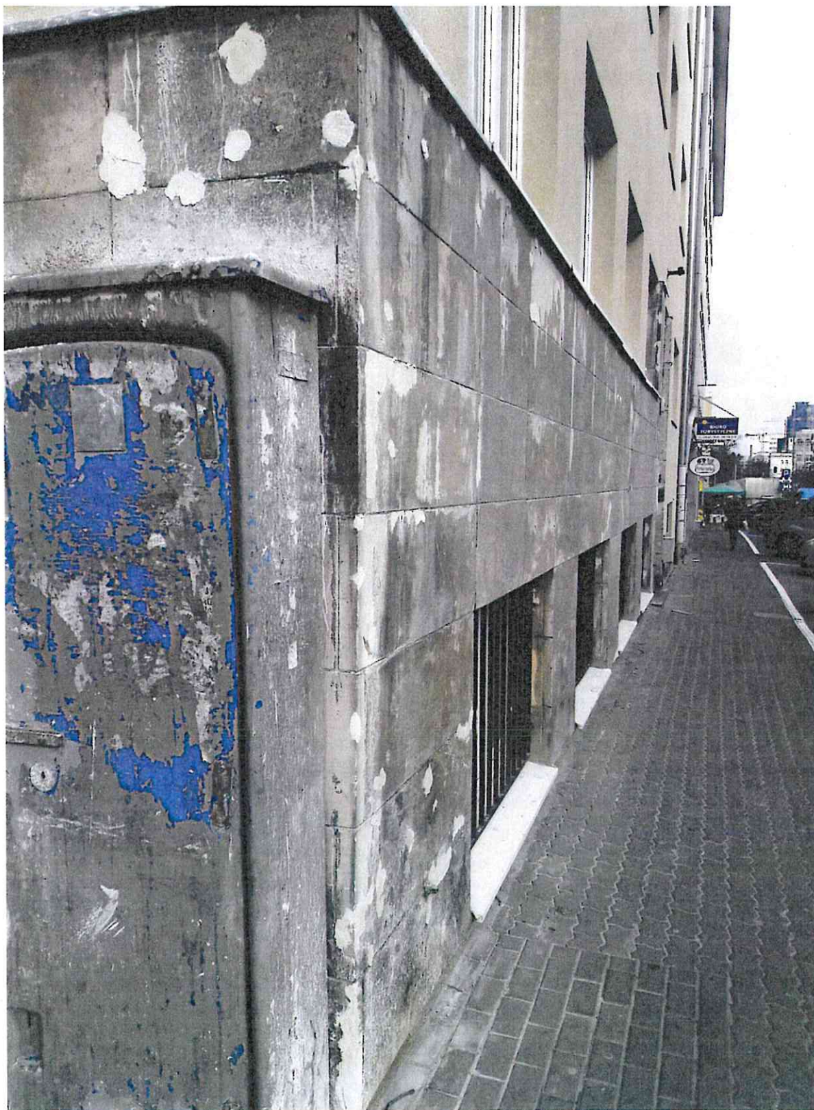
fot.7 Przyziemie elewacji ( widok od strony sądu) , widoczne ciemna powierzchnia kamiennej okładziny i jasne kity zabezpieczające.
