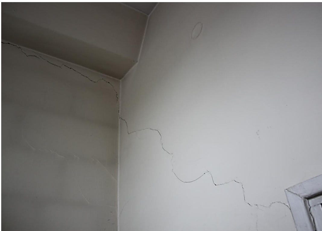
Fot. 15. – zarysowanie na ścianie działowej od strony magazynu w przenoszone w obrębie otworu drzwiowego; rysa przechodzi na tynk ściany zewnętrznej.
