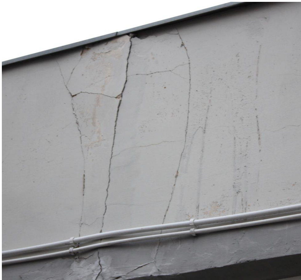
Fot. 5. – widoczne powtarzające się zarysowania tynków attyki w miejscach łączenia prefabrykatów
