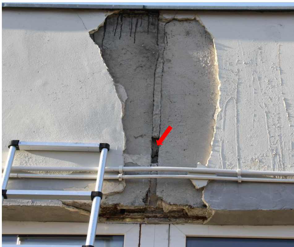
Fot. 1. – odkrywka – łączenie ścian attyki, brak wypełnienia między prefabrykatami attyki;
