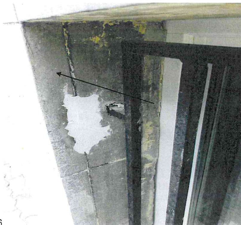
fot.25-26 Stan zachowania ościeży okien przyziemia. Widoczne mocowania krat okiennych w otwory wykonane przed montażem płyt okładzin świadczą o profesjonalizmie projektantów i wykonawców. Kraty stalowe w stanie dobrym. Widoczna grubość płyty.
