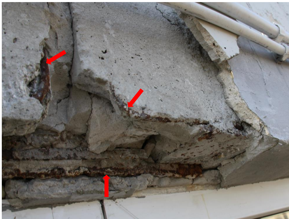
Fot. 3. – odkrywka – łączenie ścian attyki, widoczne ubytki otuliny konstrukcji ścian, korozja zbrojenia ścian oraz stalowej blachy słupa,
