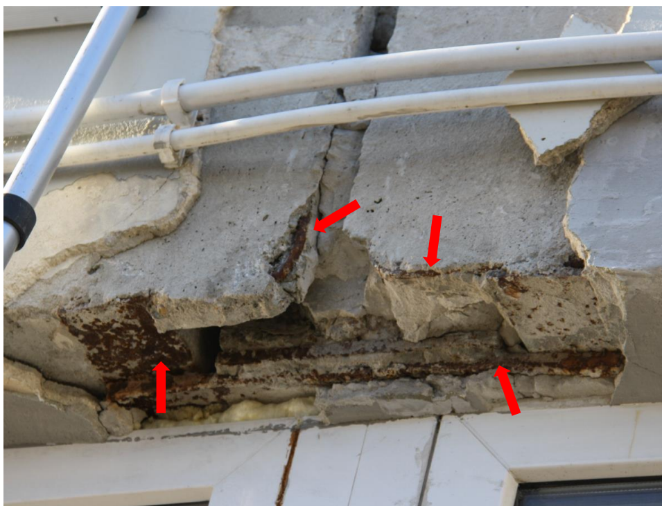
Fot. 2. – odkrywka – łączenie ścian attyki, widoczne ubytki otuliny prefabrykatów ścian, korozja zbrojenia oraz stalowych marek ścian i blachy słupa
