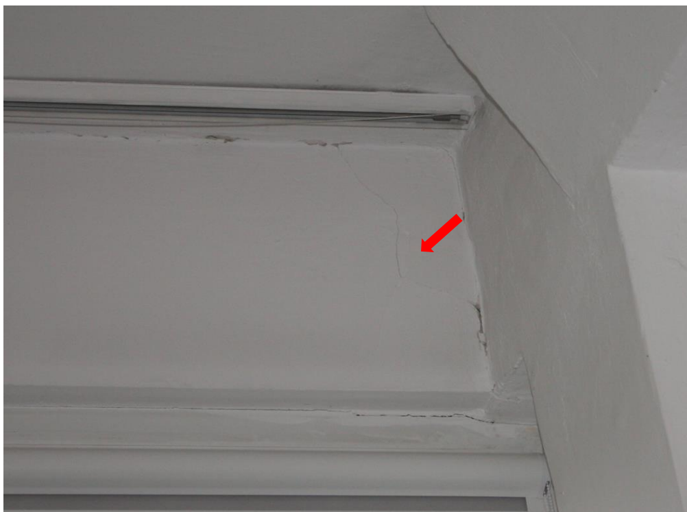
Fot. 12. – zarysowanie tynku na ryglu podłużnym
