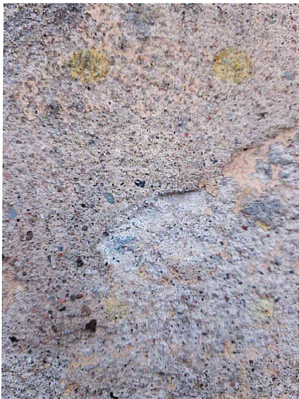
Zdj. 9-10 . Fragment zachowanych oryginalnych powłok malarskich na ścianie północnej. Widoczne porażenie biologiczne oraz cienkie zatarcia wtórnych tynków.
