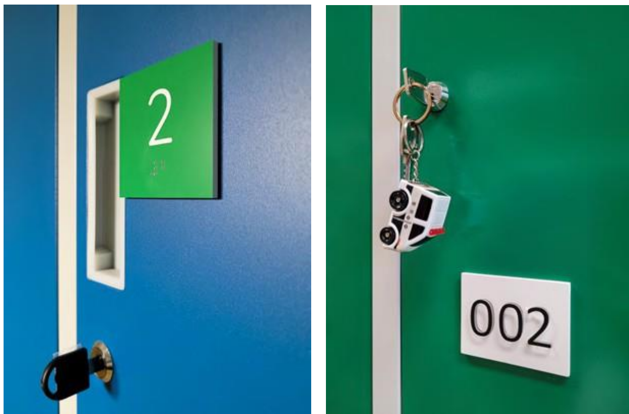
Ilustracja 71. Przykłady czytelnego wzrokowo oraz dotykowo oznakowania szafek (po lewej z zastosowaniem alfabetu Braille’a, po prawej cyfr wypukłych), fot. Katarzyna Guratowska
