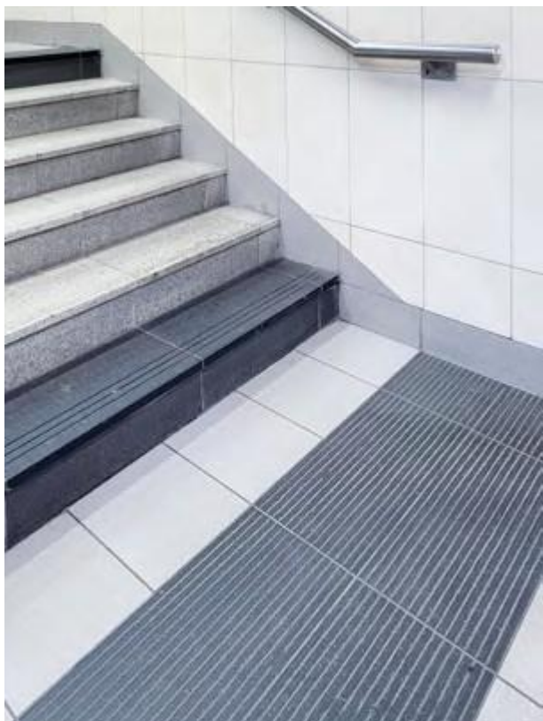
Ilustracja 66. Po lewej przykład zastosowania faktury informacyjnej przed biegiem schodowym oraz kolorystycznego wyróżnienia całego pierwszego i ostatniego stopnia w biegu. Po prawej przykład kolorystycznego wyróżnienia krawędzi pierwszego i ostatniego stopnia w biegu. fot. Katarzyna Guratowska
