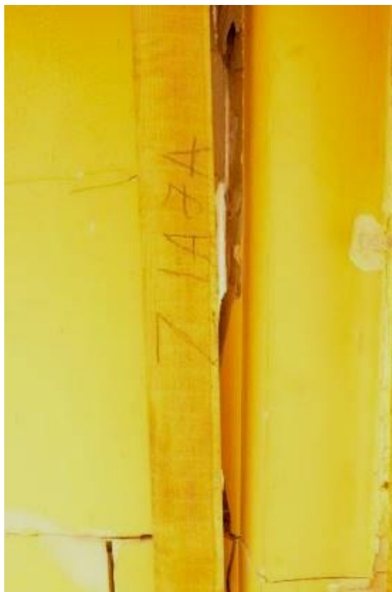
Fot. 21 - lokal nr 4 – rozerwane przewiązanie murarskie ściany zewnętrznej i ściany rozdzielającej lokale nr 3 i 4, widoczny prześwit,
