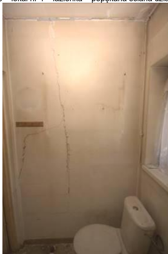
Fot. 16 – lokal nr 4 , łazienka – spękana ściana dzieląca łazienkę i komórkę lokatorską
