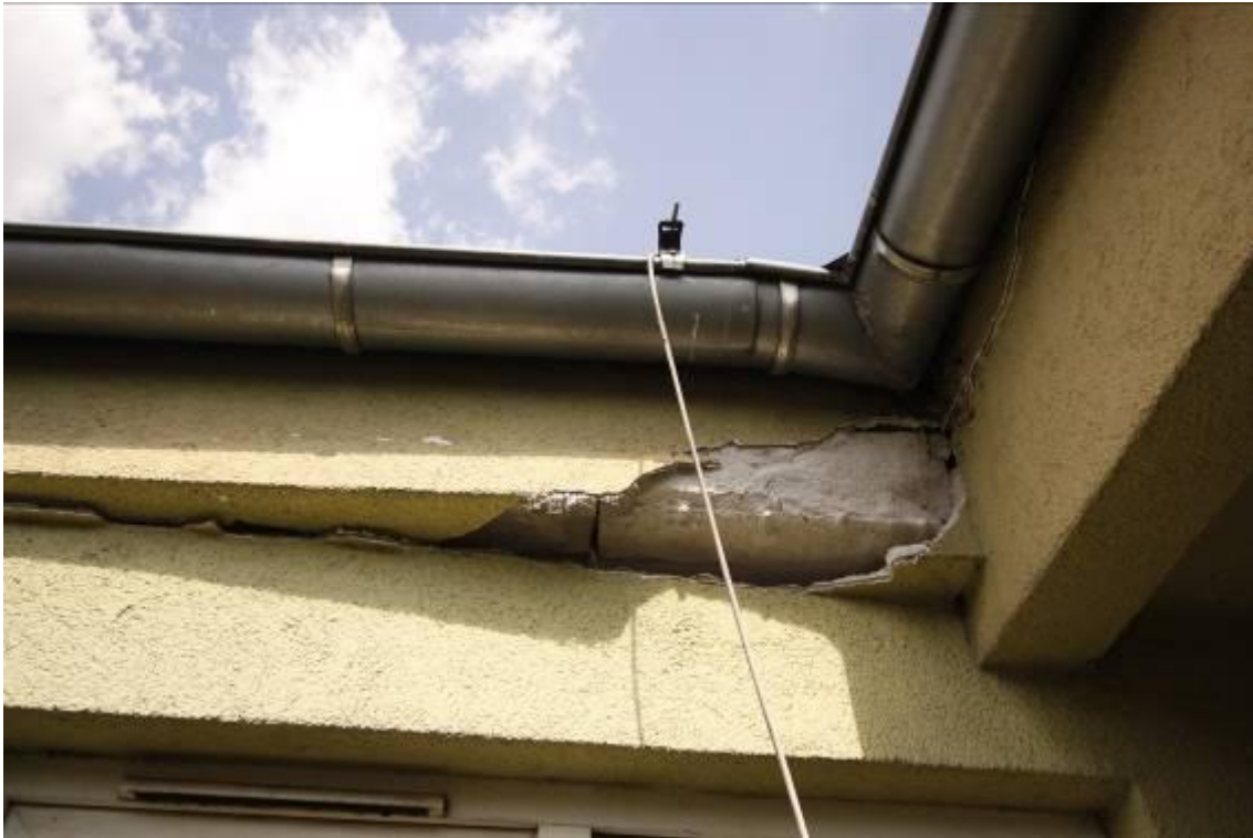
Fot. 25 - widok części wspornikowej płyty stropowej ze szczeliną pomiędzy murem a dolnym licem płyty; zdeformowana rynna
