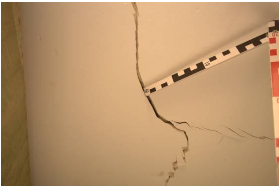
Fot. 7 – lokal nr 3 – pomiar szerokości pęknięcia ściany posa podokiennego
