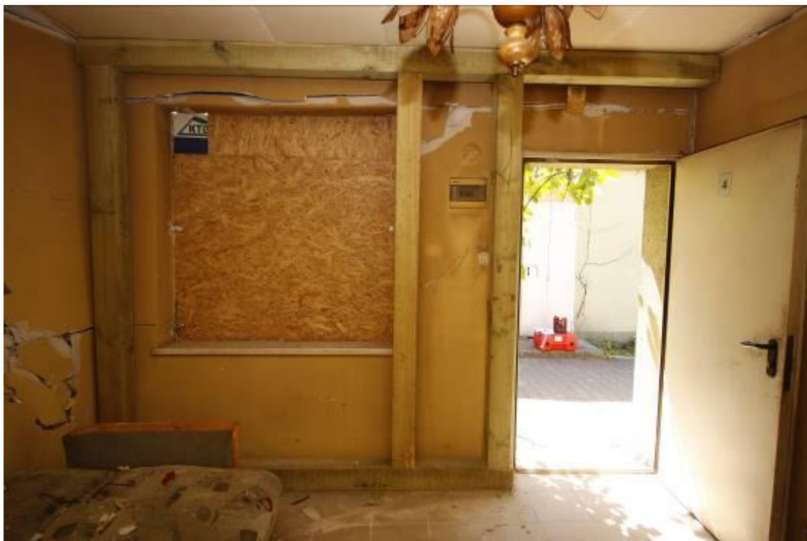
Fot. 13 – lokal nr 4 – widok na ścianę zewnętrzną i otwór po oknie zniszczony wybuchem; widoczna drewniana konstrukcja zabezpieczająca
