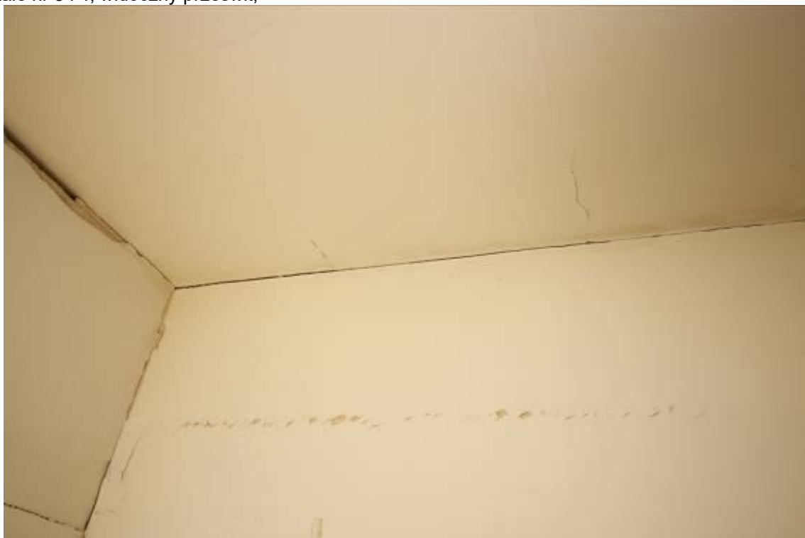
Fot. 22 – lokal nr 3 – zarysowanie oparcia płyt stropowych ze ścianą
