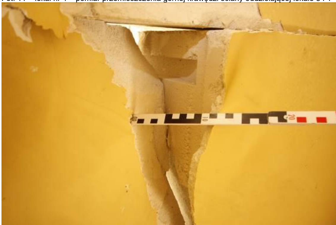
Fot. 12 – pomiar pęknięcia z przemieszczeniem ścian między lokalami 3 i 4
