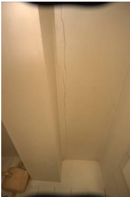
Fot.29 - lokal nr 3, łazienka – zarysowania na styku płyt stropowych obok belki na przedłużeniu ściany zewnętrznej
