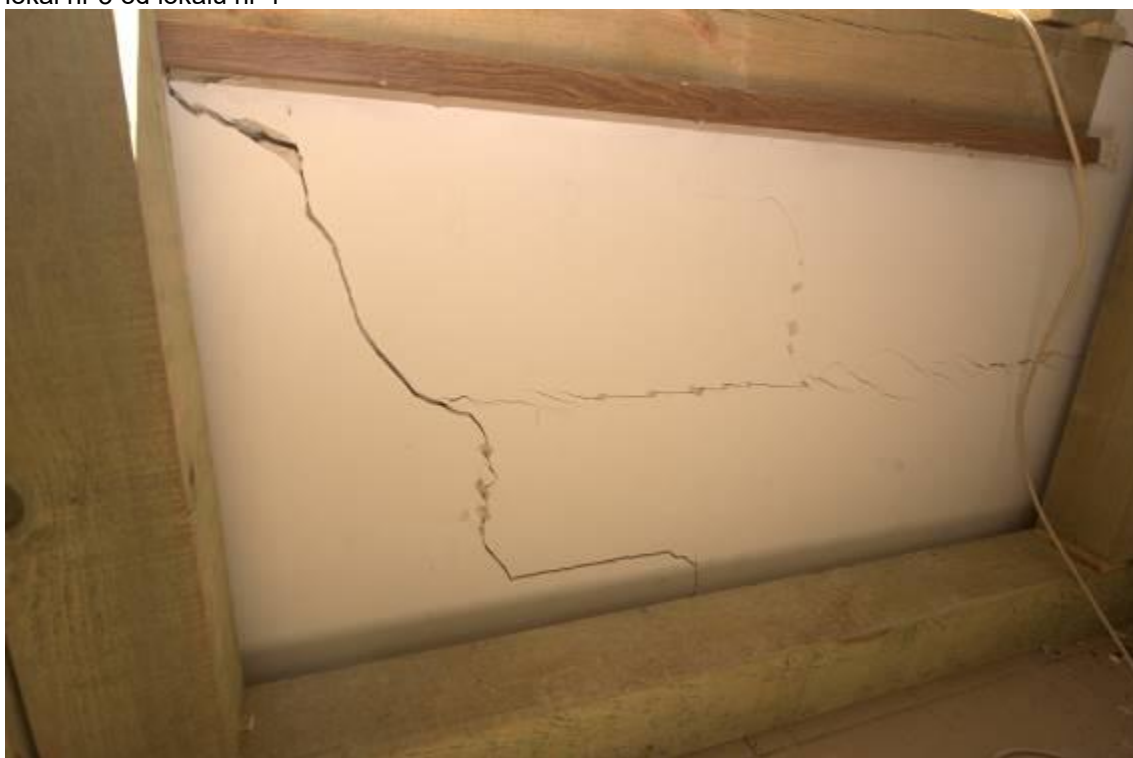
Fot. 6 – pas podokienny w lokalu nr 3 z pęknięciami i tymczasowym zabezpieczeniem konstrukcją drewnianą
