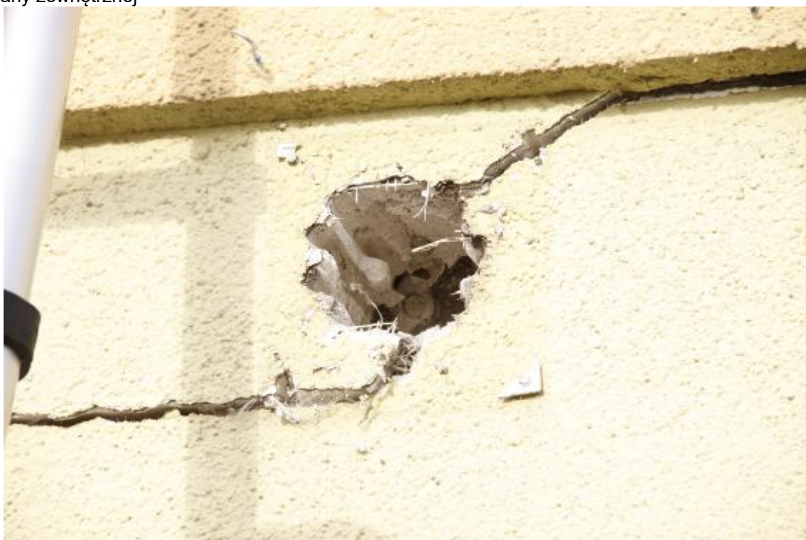
Fot. 30 – ściana zewnętrzna szczytowa lokalu nr 4; widoczne przemieszczenia po wybuchu
