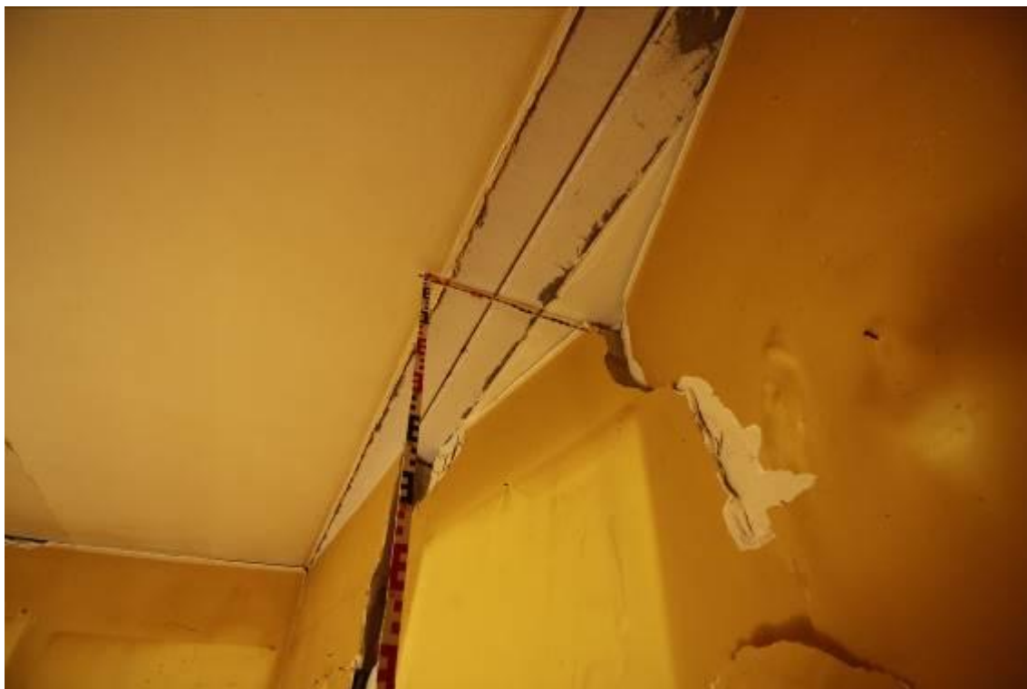
Fot. 11 – lokal nr 4 – pomiar przemieszczenia górnej krawędzi ściany oddzielającej lokale 3 i 4
