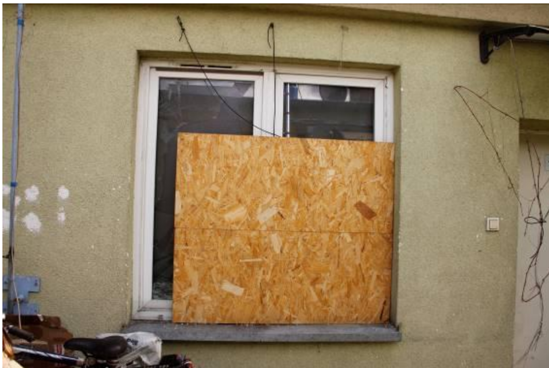
Fot. 1 – zabezpieczenie okna z wybitą szybą w lokalu nr 1
