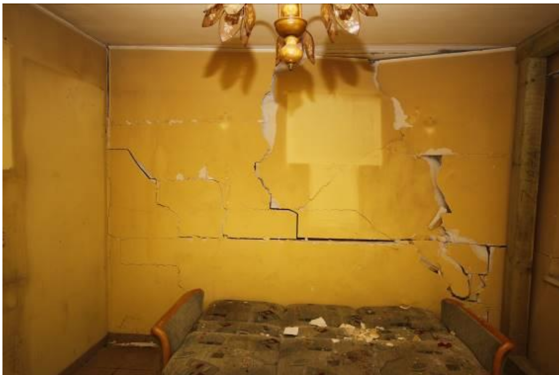
Fot. 9 – lokal nr 4 – zniszczona wybuchem ściana oddzielająca lokal nr 4 od lokalu nr 3
