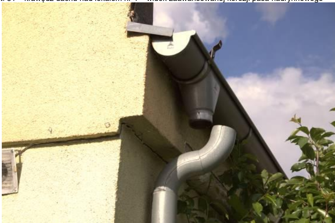
Fot. 32 – narożnik ściany frontowej i szczytowej z przemieszczeniami rury spustowej w stosunku do leja spustowego
