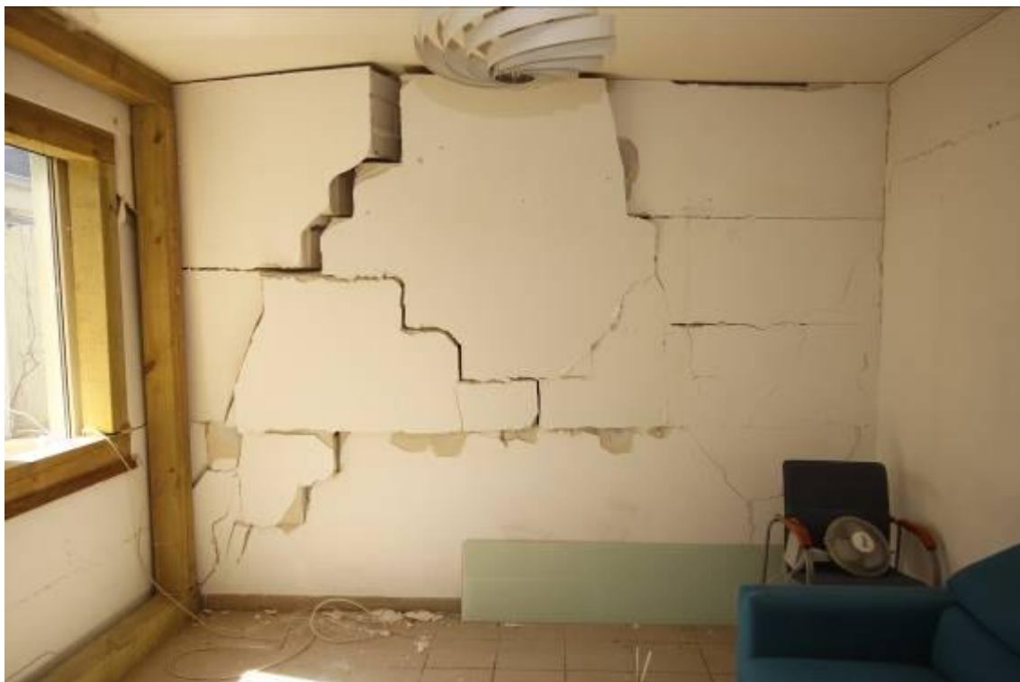
Fot. 5 – lokal nr 3 – „wybrzuszona” (wypchnięta ) parciem wybuchającego gazów ściana oddzielająca lokal nr 3 od lokalu nr 4
