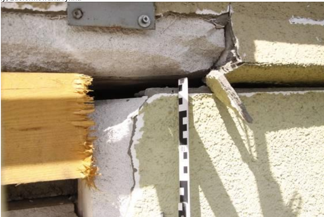
Fot. 26 – ujęcie tuż poza krawędzią okna lokalu nr 4 - pomiar szczeliny pomiędzy górną płaszczyzną zewnętrznej ściany nośnej a dolną płaszczyzną płyty stropowej
