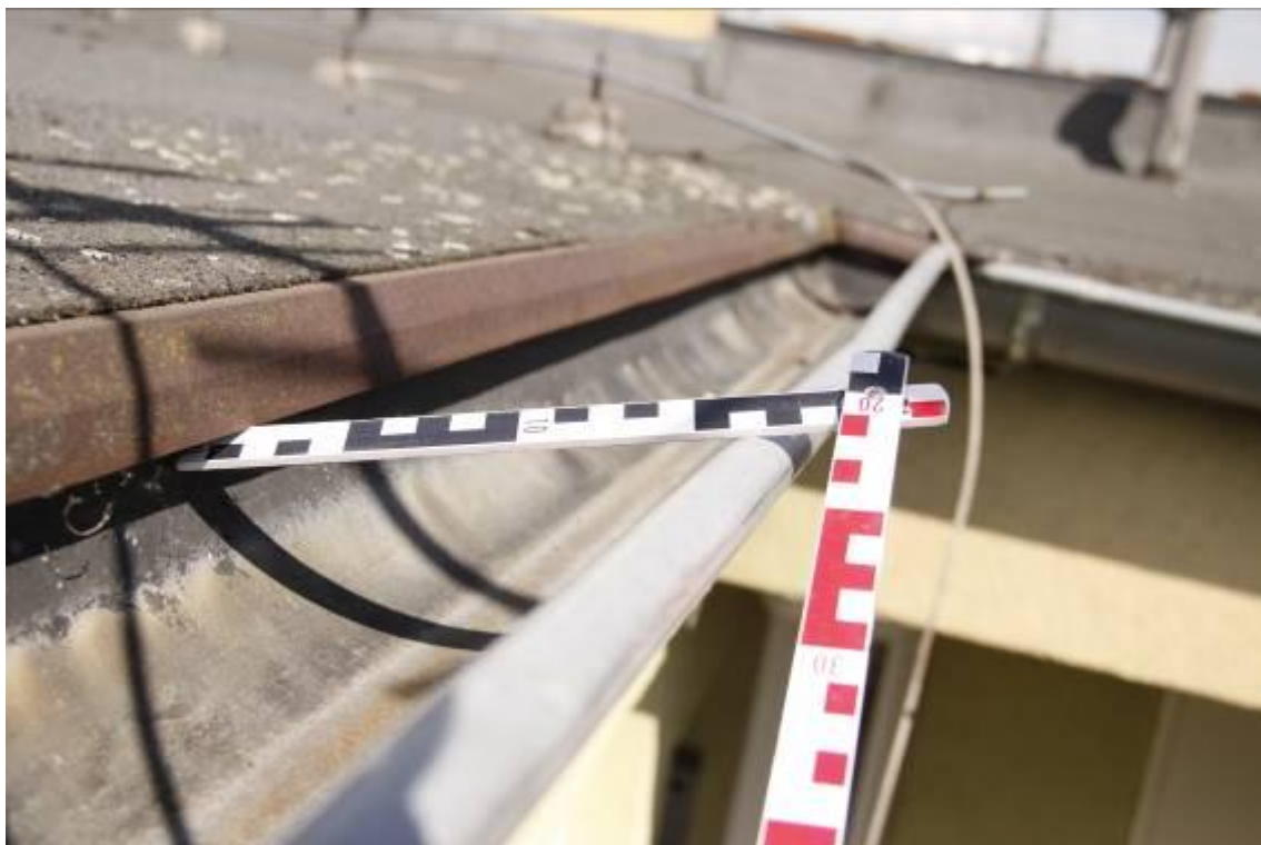
Fot. 31 – krawędź dachu nad lokalem nr 4 – widok zaawansowanej korozji pasa nadrynnowego
