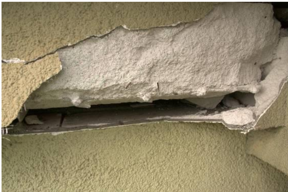
Fot.27 - nad oknem kłokalu nr 3 - część wspornikowa płyty stropowej z widocznym zbrojeniem i wykruszoną otuliną zbrojenia
