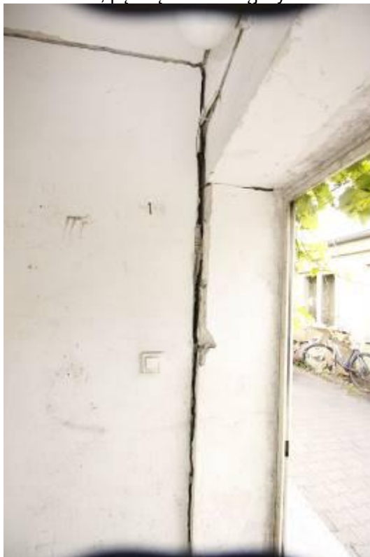
Fot.20 - lokal nr 4 – komórka lokatorska; rozerwane przewiązanie murarskie ściany zewnętrznej z wewnętrzną
