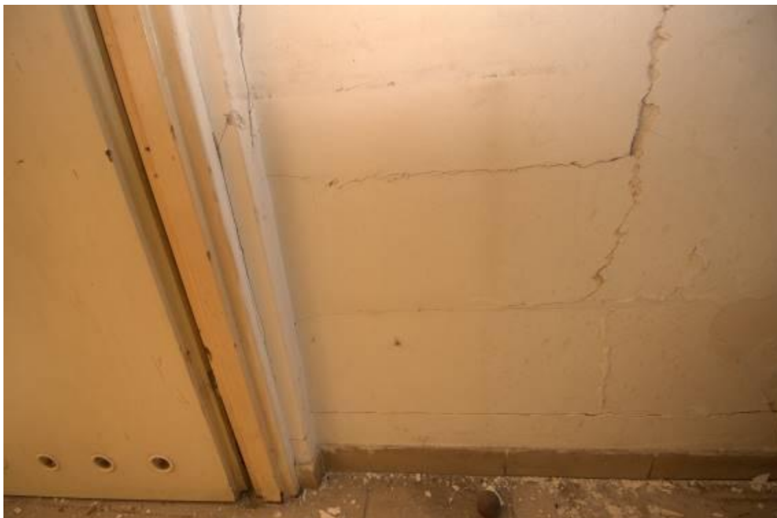
Fot. 17 – lokal nr 4 , łazienka - spękana ściana dzieląca łazienkę i komórkę lokatorską
