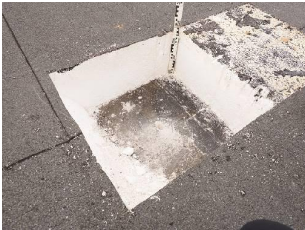
Fot. 35 – odkrywka na dachu nad miejscem z widocznym zarysowaniem na dolnej płaszczyźnie płyty,
