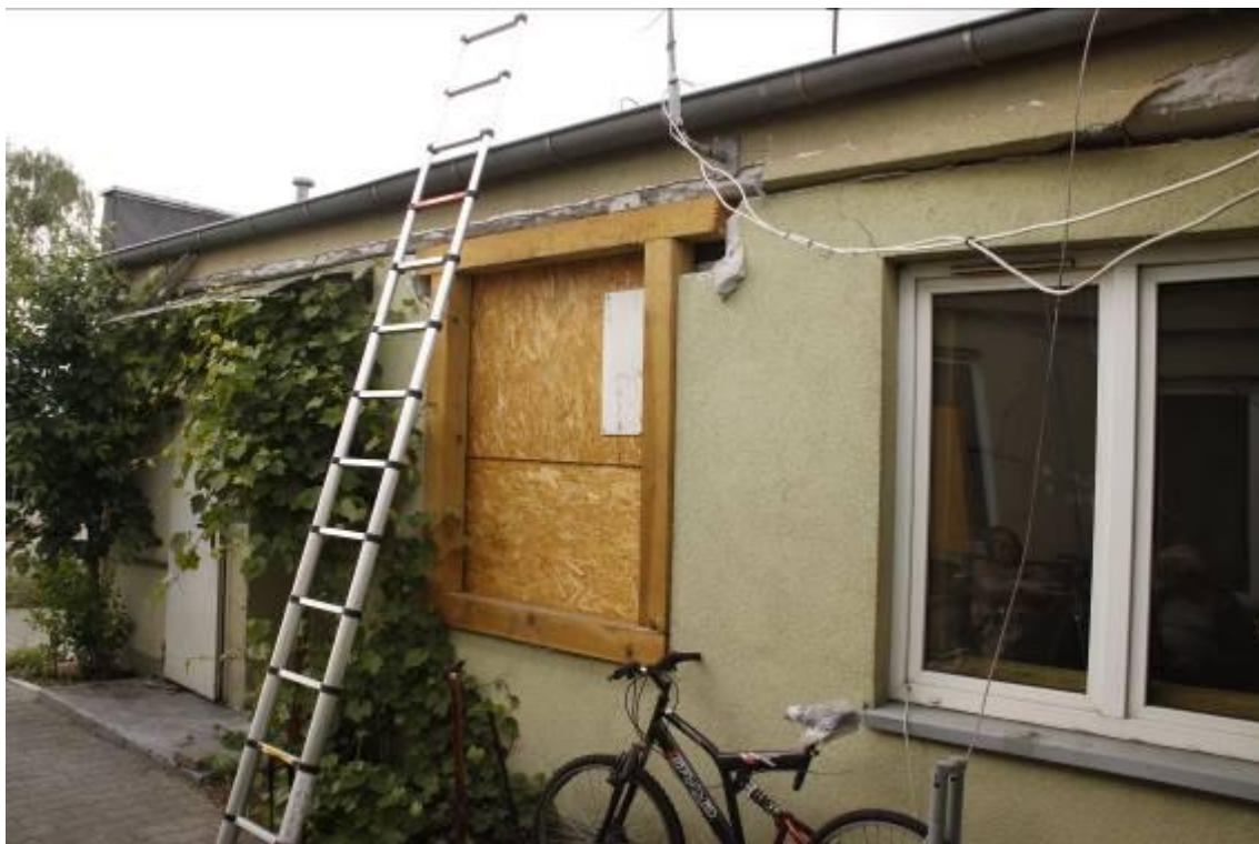
Fot. 3 – okna lokali nr 3 i 4 – okno lokalu nr 4 wypchnięte wybuchem ( zabezpieczone ), stolarka zdemontowana, otwór okienny wypełniony płytą OSB
