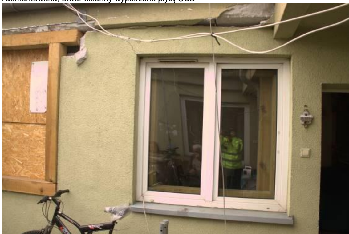
Fot. 4 – okno lokalu nr 3 z widoczną szczeliną pomiędzy ścianą a płytami stropodachu
