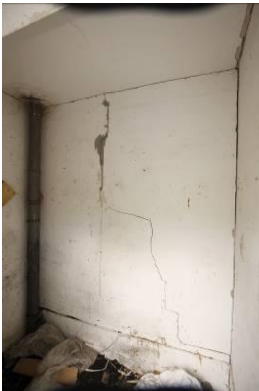
Fot.19 - lokal nr 4 – komórka lokatorska, pęknięcie na całej wysokości ściany działowej
