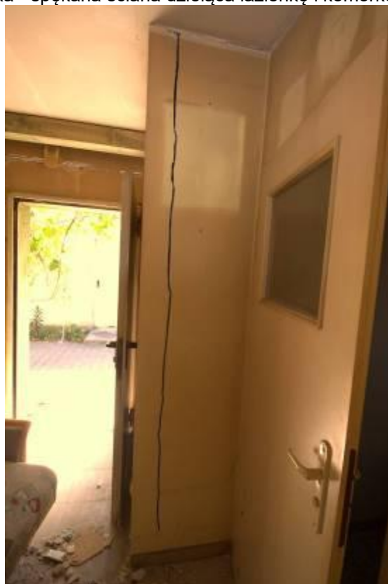
Fot. 18 – lokal nr 4 – rozerwane przewiązanie ściany działowej obudowy komórki lokatorskiej
