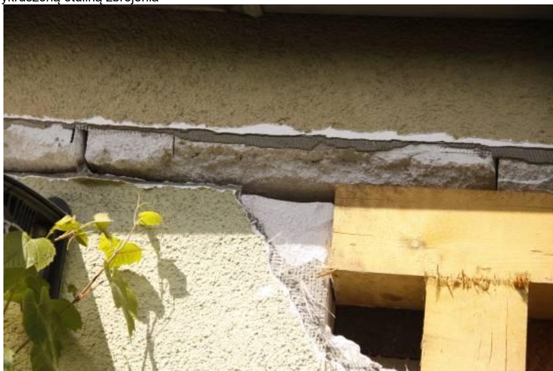
Fot. 28 – fragment elewacji z oknem lok. 4 – widoczna szczelina między płytami stropowymi a ścianą zewnętrzną
