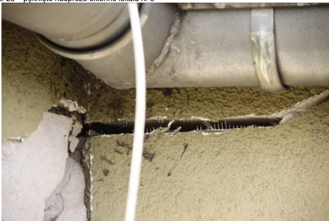
Fot. 24 – belka nad wejściem do lokalu nr 3 - szczelina 25 mm
