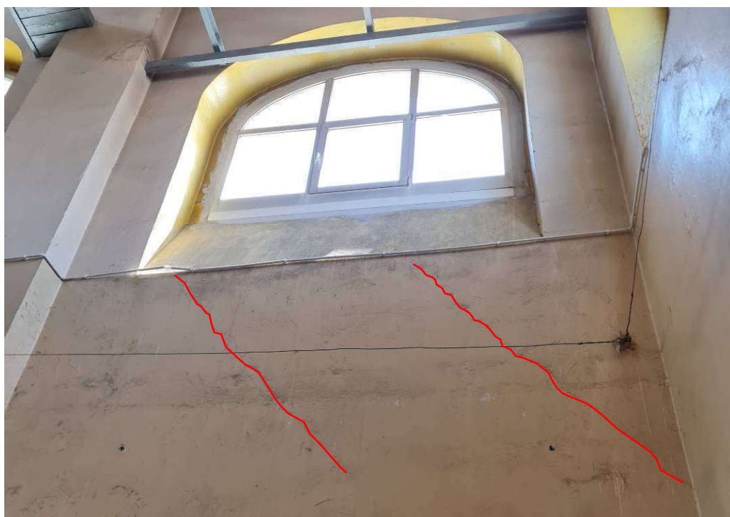
Fot. Pęknięcie, przykład uszkodzenia, Budynek Szkolny, część pierwotna, ściana południowo-wschodnia Auli. (uszkodzenie oznaczono kolorem czerwonym)
