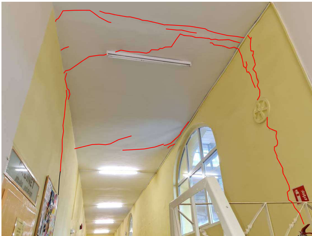
Fot. Znaczne pęknięcia propagujące na skroś budynku, Budynek Szkolny, część pierwotna, korytarz główny 1. piętra. (uszkodzenie oznaczono kolorem czerwonym)
