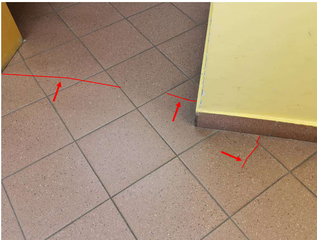
Fot. Budynek Sali Gimnastycznej, zaplecze szatniowo-sanitarne, zarysowanie płytek ceramicznych. (przykład uszkodzenia oznaczono kolorem czerwonym)
