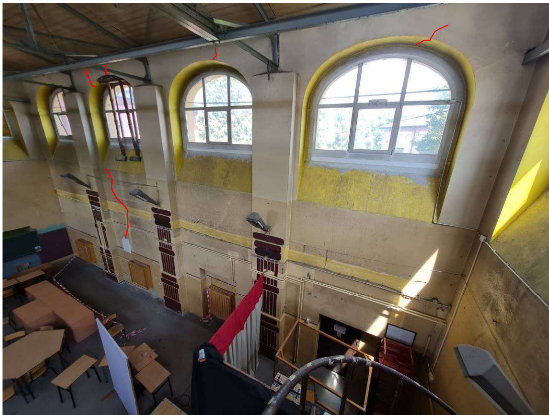
Fot. Ściana północno-wschodnia Auli, Budynek Szkolny, część pierwotna. (uszkodzenie oznaczono kolorem czerwonym)
