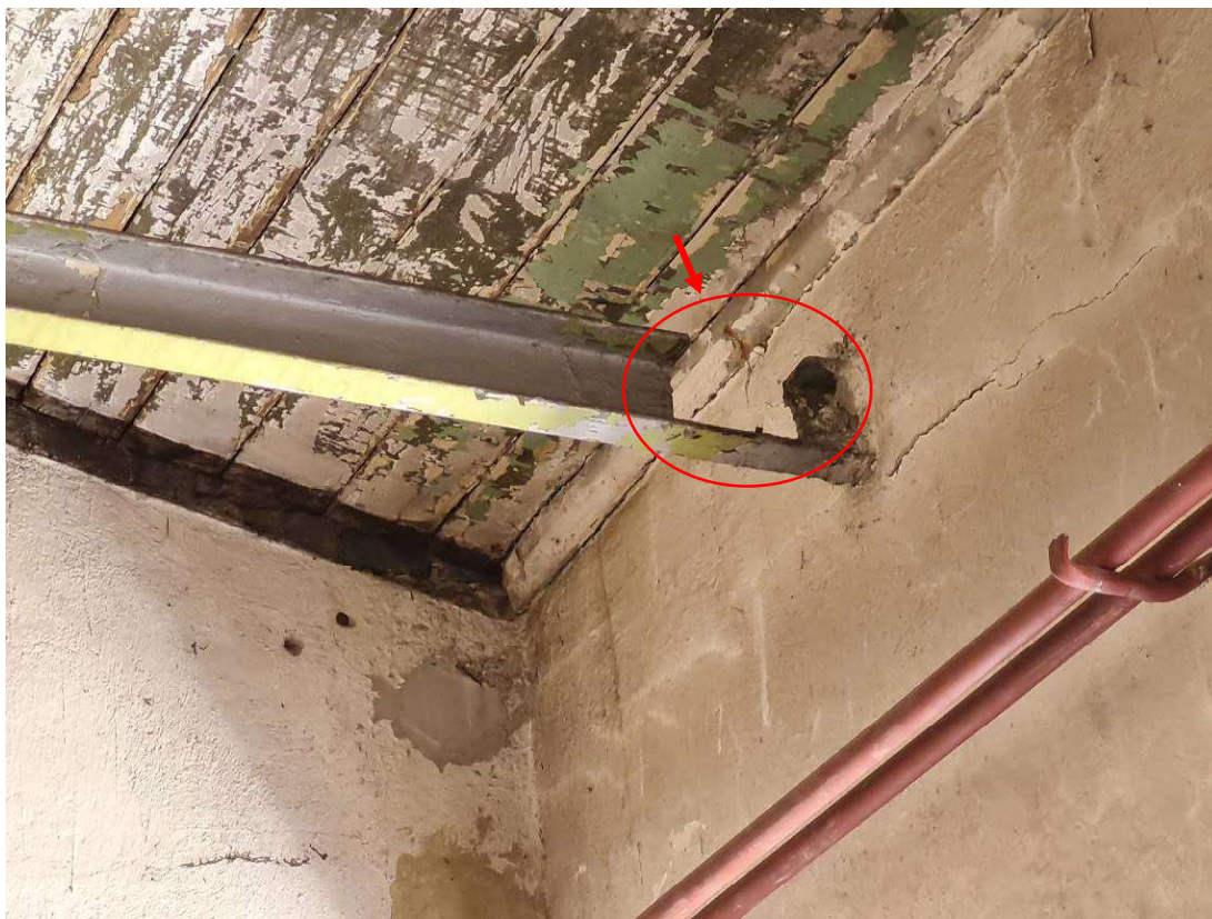
Fot. Uszkodzenie ściagu, Budynek Szkolny, część pierwotna, pomieszczenie techniczne zaplecza Auli. (uszkodzenie oznaczono kolorem czerwonym)
