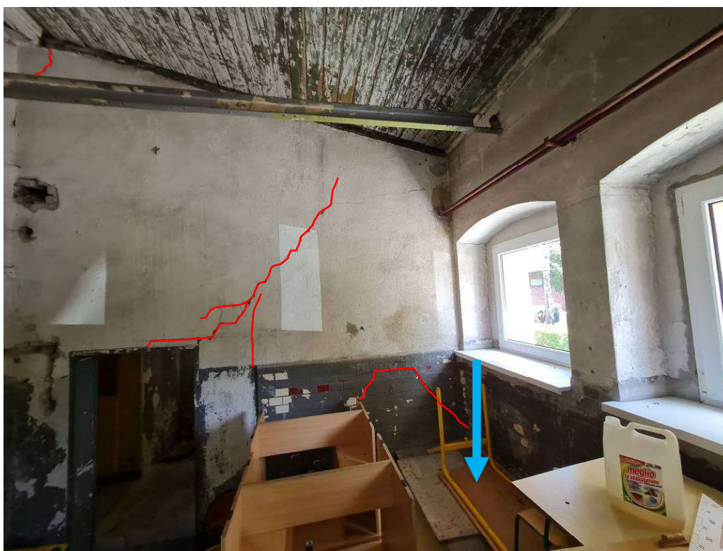
Fot. Pęknięcie, przykład uszkodzenia, Budynek Szkolny, część pierwotna, pomieszczenie techniczne zaplecza Auli. (pęknięcia ścian oznaczono kolorem czerwonym) (lokalizację zapadniętej posadzki oznaczono kolorem niebieskim)
