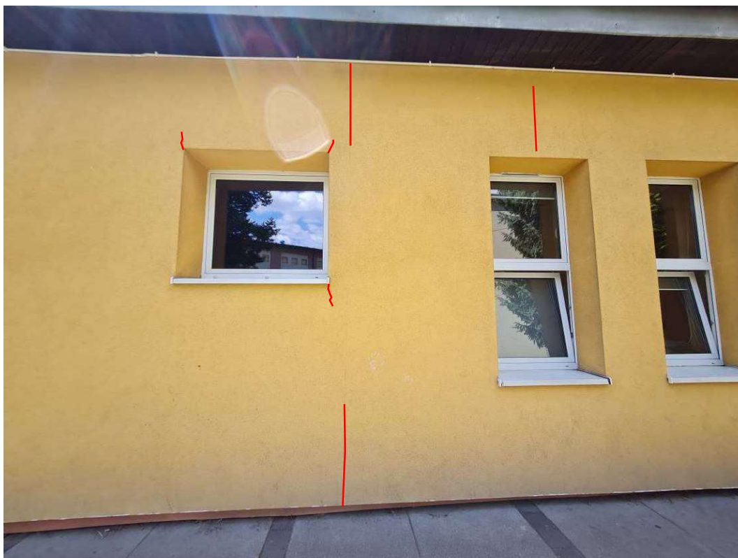
Fot. Zarysowania tynku elewacji, Budynek Szkolny, część pierwotna, elewacja północno-wschodnia. (uszkodzenia oznaczono kolorem czerwonym)
