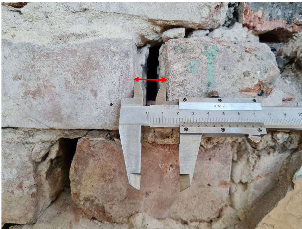
Fot. Pomiar szerokości pęknięcia, Budynek Szkolny, część pierwotna, ściana północna-wschodnia Auli.
