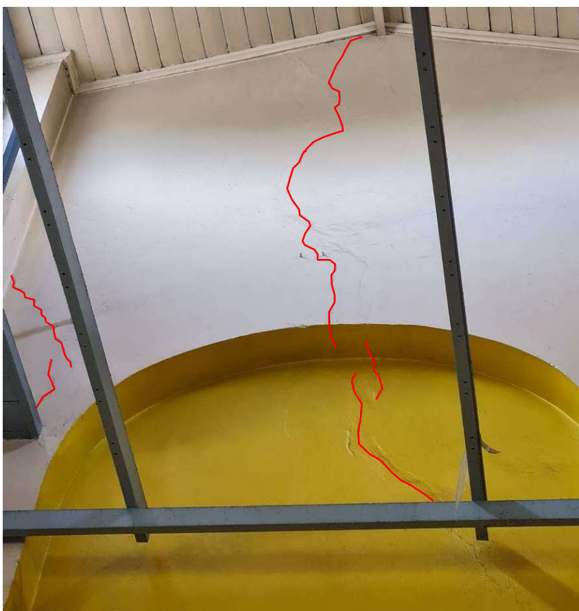
Fot. Pęknięcie, przykład uszkodzenia, Budynek Szkolny, część pierwotna, ściana północna-zachodnia Auli. (uszkodzenie oznaczono kolorem czerwonym)
