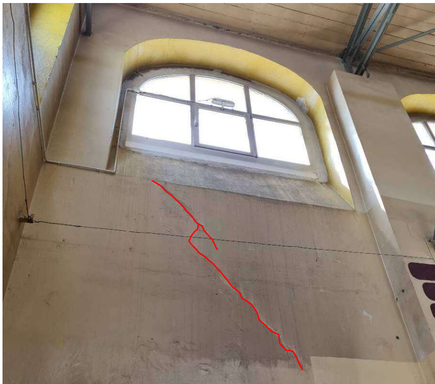
Fot. Pęknięcie, przykład uszkodzenia, Budynek Szkolny, część pierwotna, ściana południowo-zachodnia Auli. (uszkodzenie oznaczono kolorem czerwonym)
