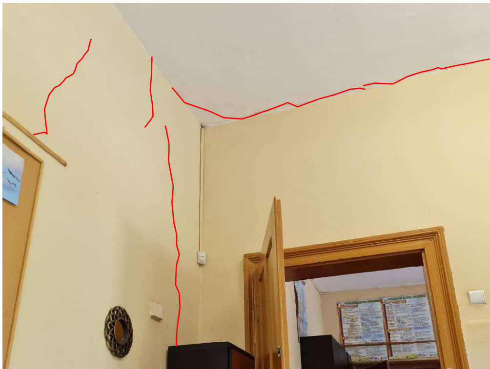
Fot. Pęknięcie, przykład uszkodzenia, Budynek Szkolny, część pierwotna, sala lekcyjna na parterze. (uszkodzenie oznaczono kolorem czerwonym)
