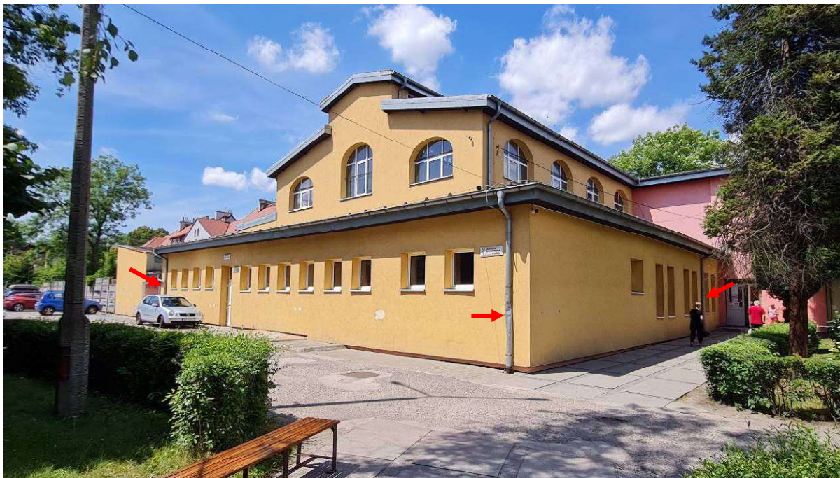
Fot. Budynek Szkolny, część pierwotna, narożnik wschodni. (uszkodzone rury spustowe oznaczono kolorem czerwonym)
