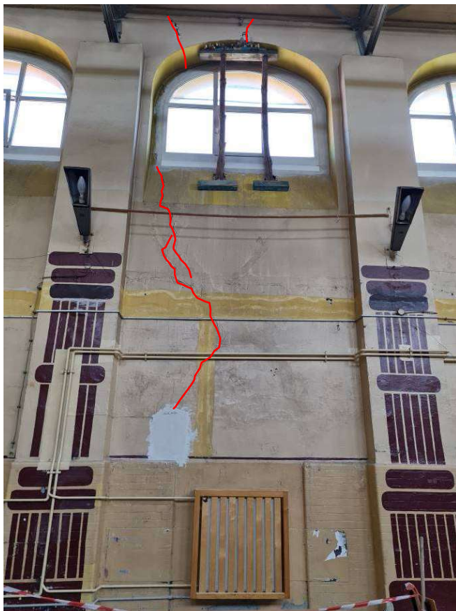
Fot. Pęknięcie, przykład uszkodzenia, Budynek Szkolny, część pierwotna, ściana północna-wschodnia Auli. (uszkodzenie oznaczono kolorem czerwonym)
