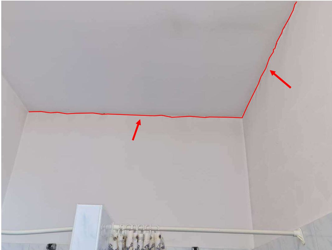
Fot. Budynek Sali Gimnastycznej, zaplecze szatniowo-sanitarne, zarysowanie ścian. (przykład uszkodzenia oznaczono kolorem czerwonym)
