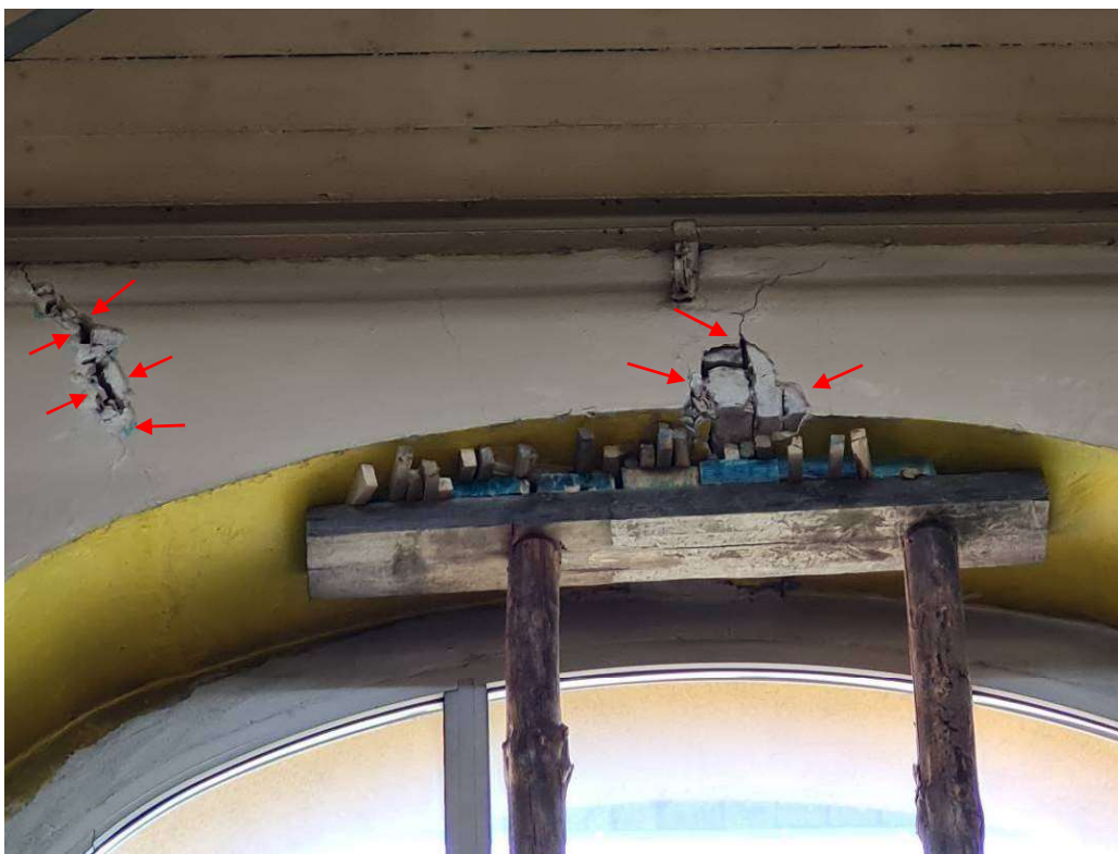
Fot. Zabezpieczenie uszkodzonego nadproża poprzez podstemplowanie, Budynek Szkolny, część pierwotna, ściana północno-wschodnia Auli. (uszkodzenie oznaczono kolorem czerwonym)
