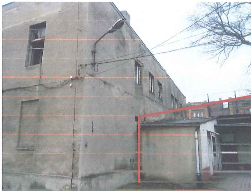
WIDOK NA BUDYNKI W GRANICY DZIAŁEK NR 4984/157 I 5048/31 PRZEZNACZONE DO ROZBIÓRKI (NA CZERWONO OZNACZONO WSPÓLNĄ ŚCIANĘ KONSTRUKCYJNĄ)
