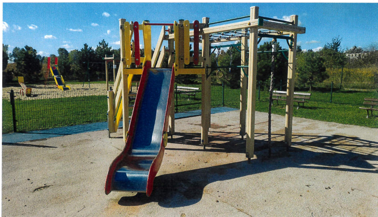
C: Ślizg zjeżdżalni do wymiany
