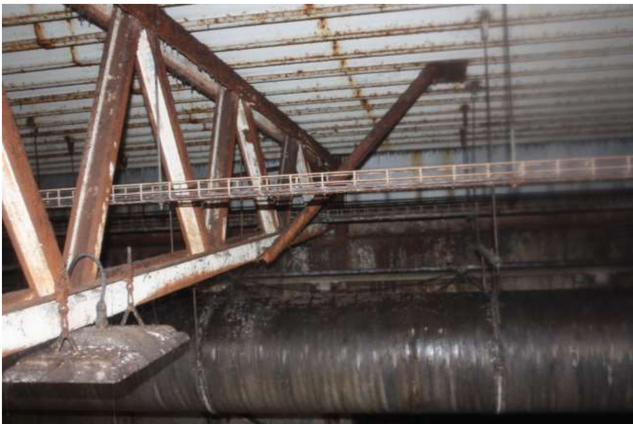
Fot. 10. Hala –łącznik operacyjny: 409B (PL4743) –Dźwigar dachowy wraz z elementem stabilizującym jego pas dolny, mocowany do blachy trapezowej. Na zdjęciu widoczna korozja konstrukcji stalowej oraz blachy trapezowej.
