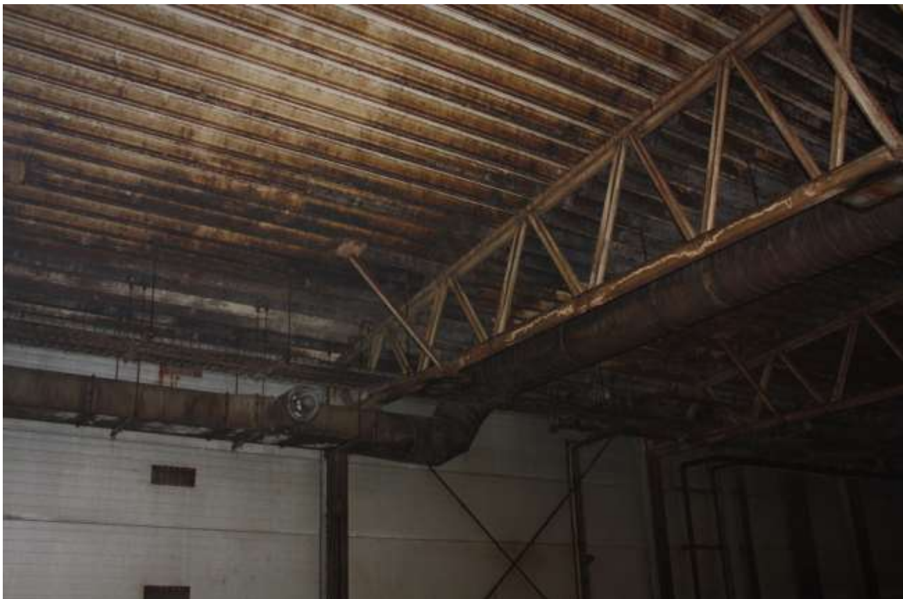
Fot. 1. Hala przyjęcia odpadów: 409A (PL4738) –Stan zachowania dźwigara stalowego i blachy trapezowej.
