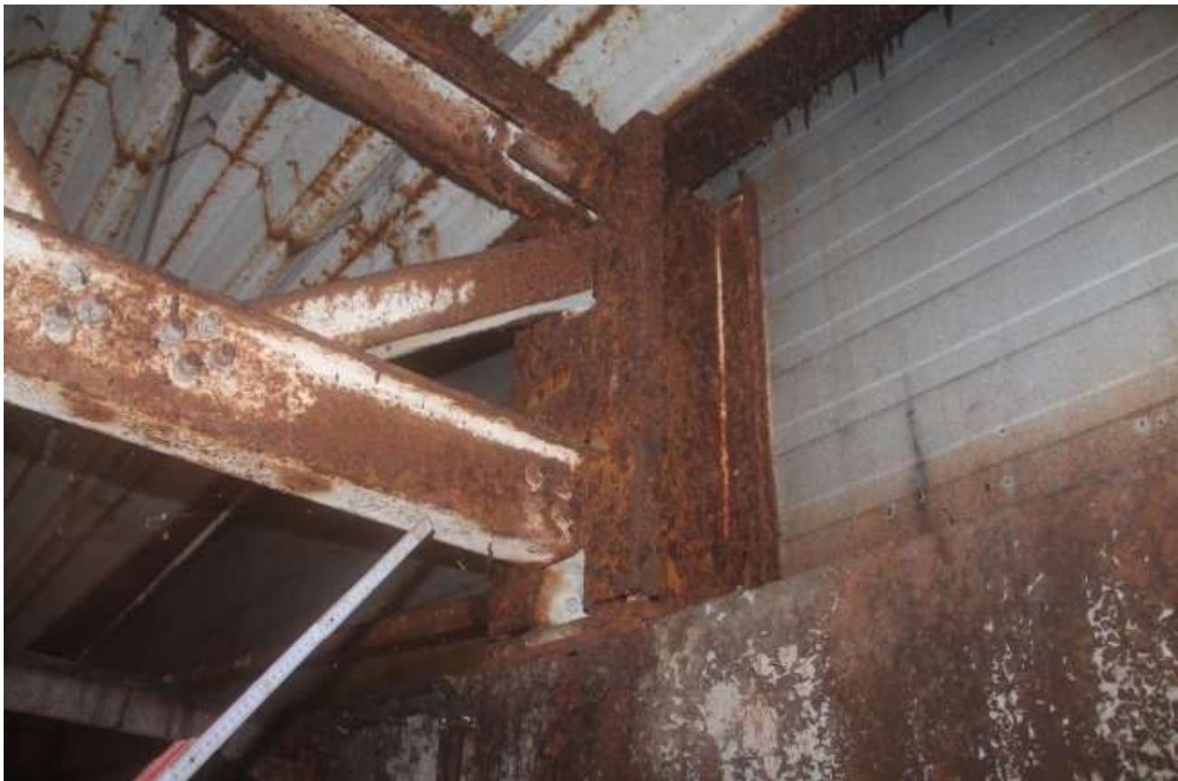
Fot. 9. Hala –łącznik operacyjny: 409B (PL4743) –Głowica podporowa, do której mocowany jest dźwigar dachowy. Element pozbawiony powłok antykorozyjnych, pozostający w stanie korozji powierzchniowej.
