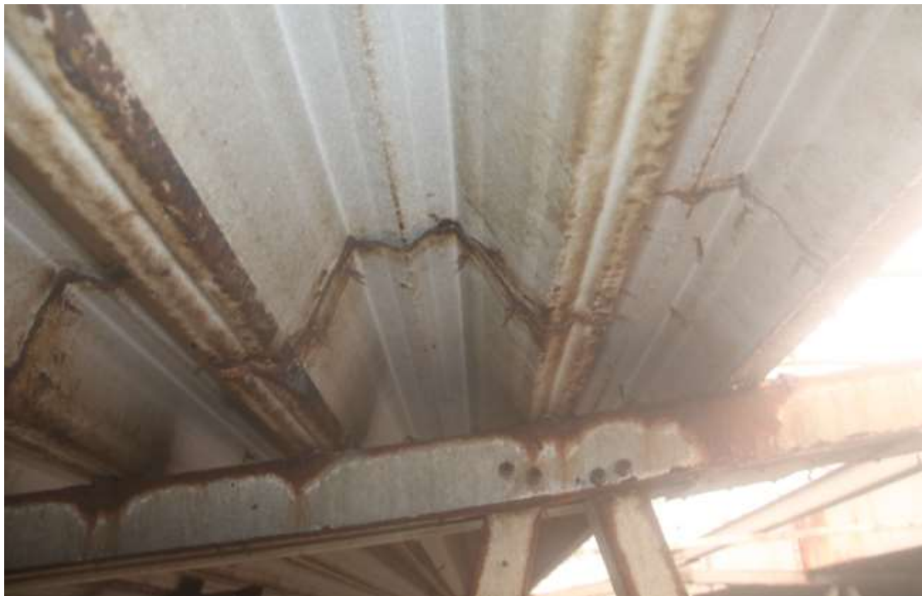
Fot. 4. Hala przyjęcia odpadów: 409A (PL4738) –Stan zachowania blachy trapezowej, pasa górnego dźwigara kratowego oraz jego wykratowania.
