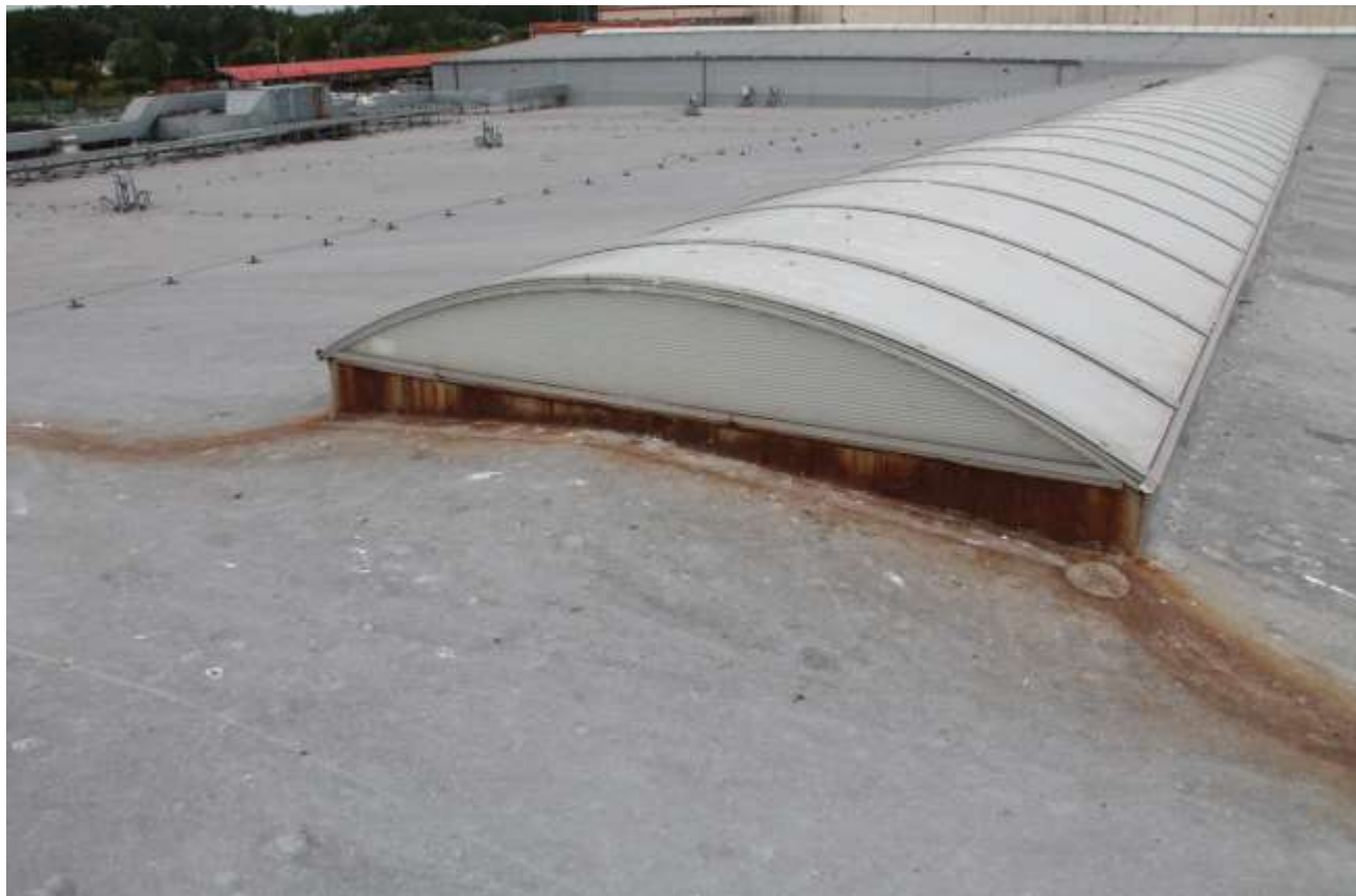
Fot. 15. Hala –łącznik operacyjny: 409B (PL4743) –Wykropliny zanieczyszczeń i rdzy, które po wewnętrznej stronie ściany szczytowej pasma świetlnego, wydostają się na zewnątrz dachu. Zanieczyszczenie w obrębie szczytu świetlika i połaci dachowej (lokalnie).
