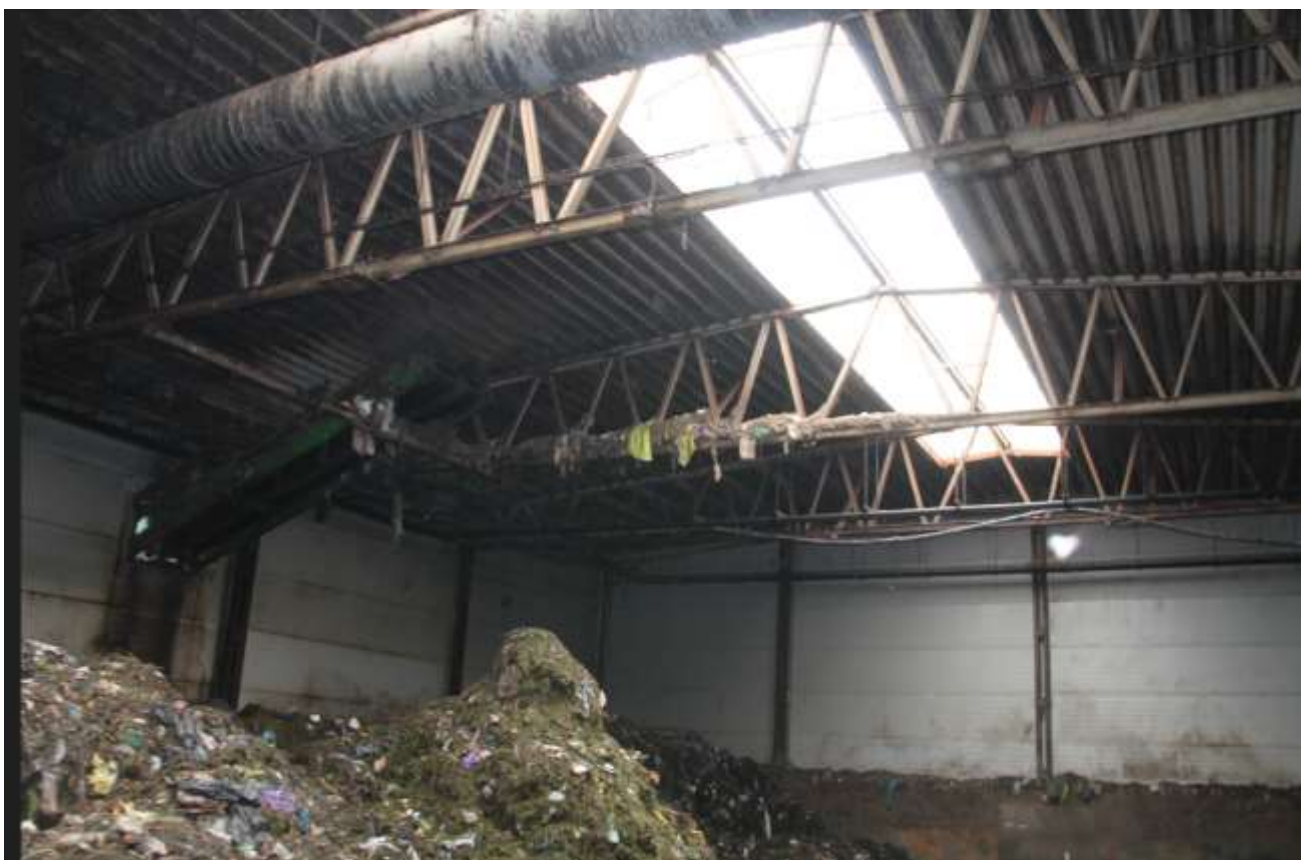
Fot. 2. Hala przyjęcia odpadów: 409A (PL4738) –Zanieczyszczona konstrukcja stalowa materiałem organicznym, z widocznego na zdjęciu, przenośnika taśmowego (zlokalizowanego w ścianie hali).
