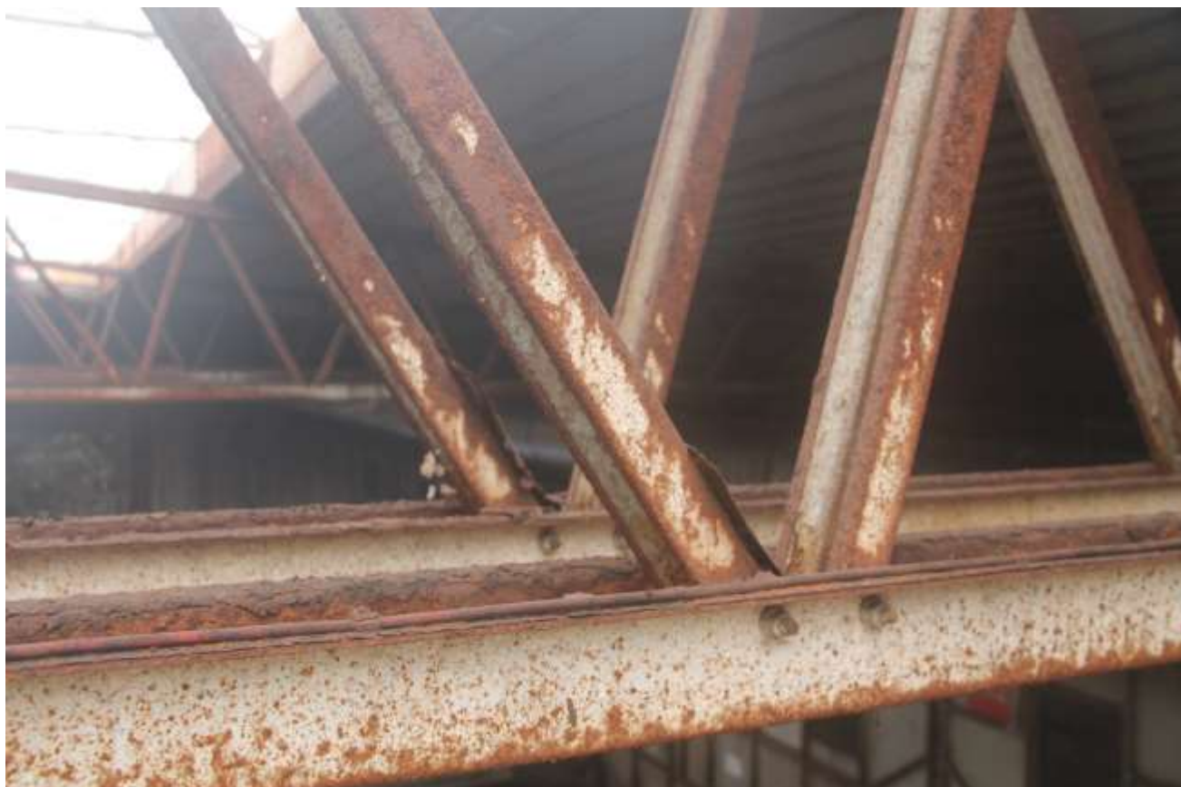
Fot. 11. Hala –łącznik operacyjny: 409B (PL4743) -Połączenie krzyżulców z pasem dolnym dźwigara stalowego. Na zdjęciu widoczne skorodowane powłoki antykorozyjne i elementy stalowe konstrukcji. Układ profili stalowych dźwigara sprzyja gromadzeniu się zanieczyszczeń.
