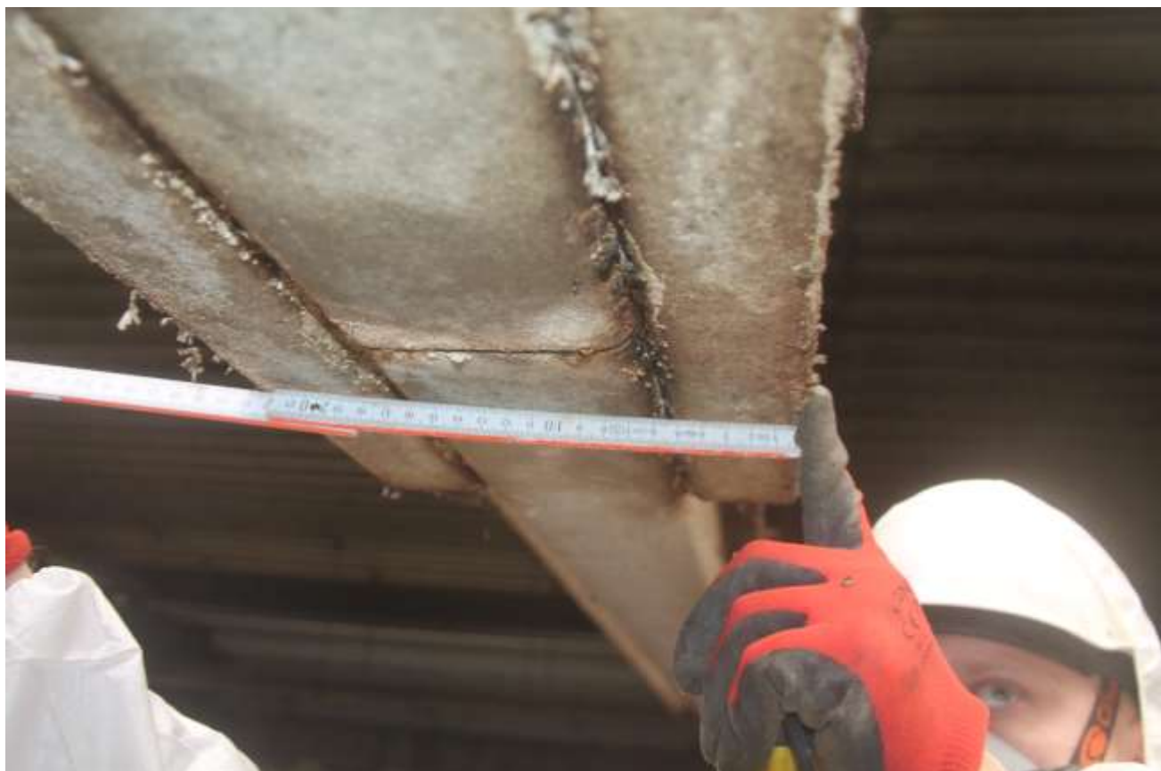
Fot. 5. Hala przyjęcia odpadów: 409A (PL4738) –Stan zachowania połączenia pasa dolnego dźwigara kratowego, w środku jego rozpiętości.
