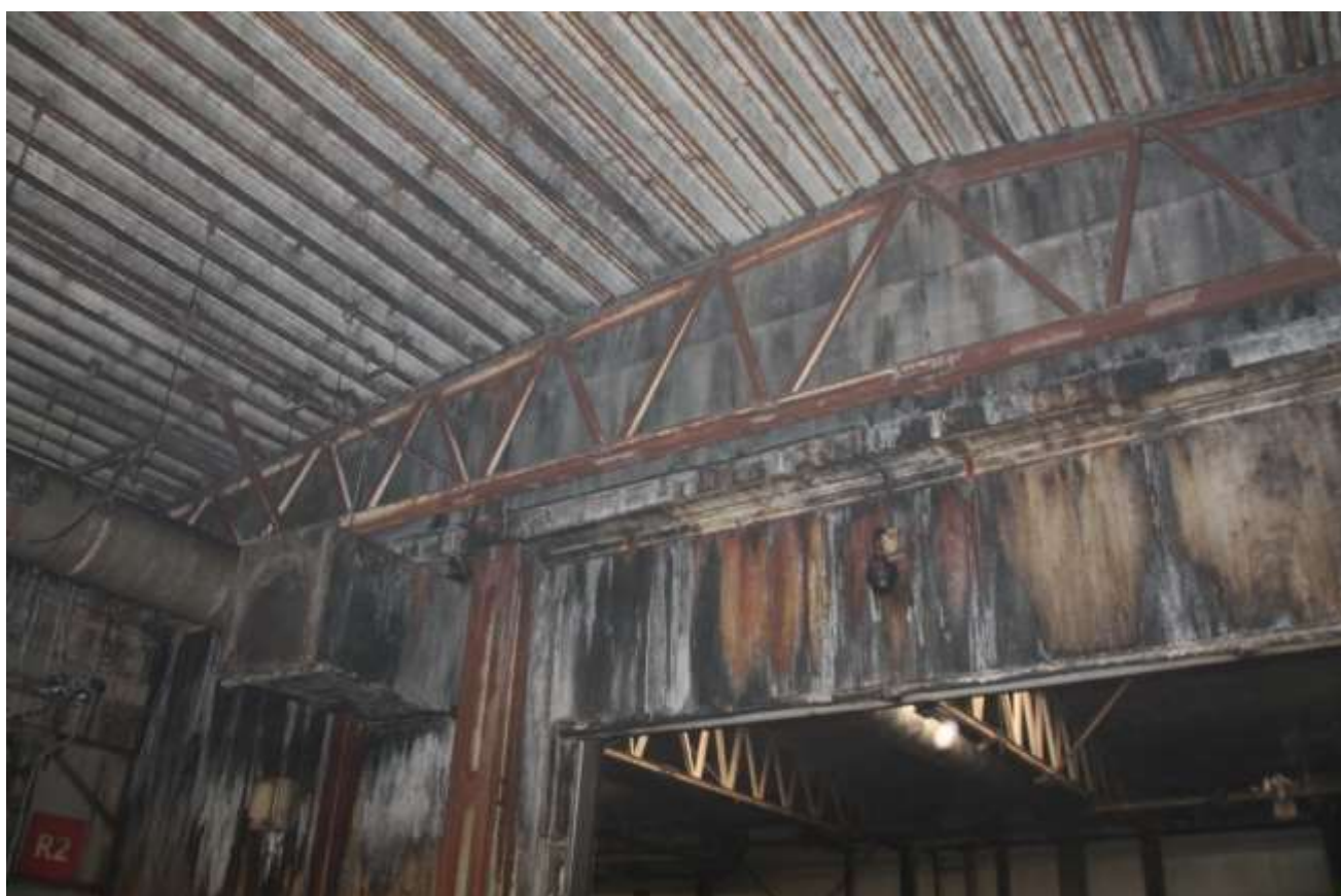
Fot. 6. Hala –łącznik operacyjny: 409B (PL4743) –Skrajny dźwigar stalowy i brama przejazdowa do hali przyjęcia odpadów. Na zdjęciu widoczne zużyte powłoki antykorozyjne oraz powierzchniowa korozja elementów stalowych.
