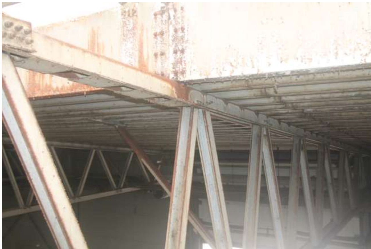
Fot. 3. Hala przyjęcia odpadów: 409A (PL4738) –Stan zachowania konstrukcji w okolicy kalenicy, pasa świetlnego. Na zdjęciu widoczne zaschnięte wykropliny i zacieki. Skorodowane miejsca konstrukcji stalowej pokrywają się z miejscami zacieków, wykroplin.
