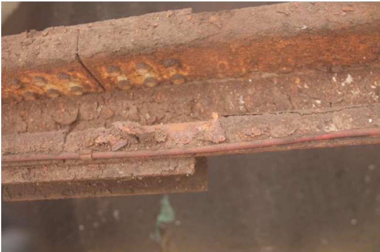
Fot. 13. Hala –łącznik operacyjny: 409B (PL4743) –Połączenie pasa dolnego w środku rozpiętości dźwigara –widok z góry. Element stalowy pozbawiony powłok antykorozyjnych, występuje korozja powierzchniowa elementu stalowego.
