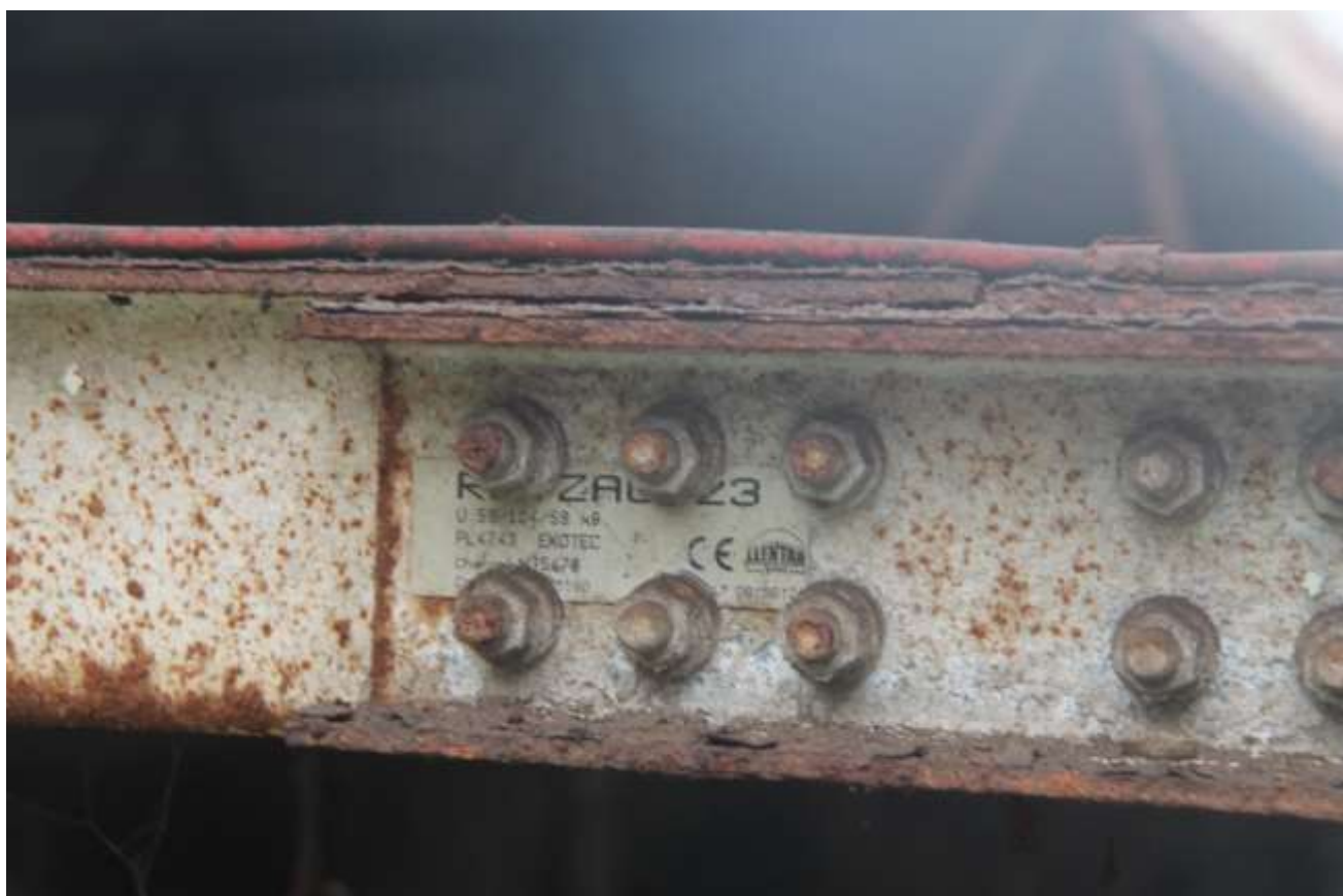
Fot. 12. Hala –łącznik operacyjny: 409B (PL4743) –Połączenie pasa dolnego w środku rozpiętości dźwigara. Widoczne uszkodzenia korozyjne powłok antykorozyjnych oraz elementów stalowych.
