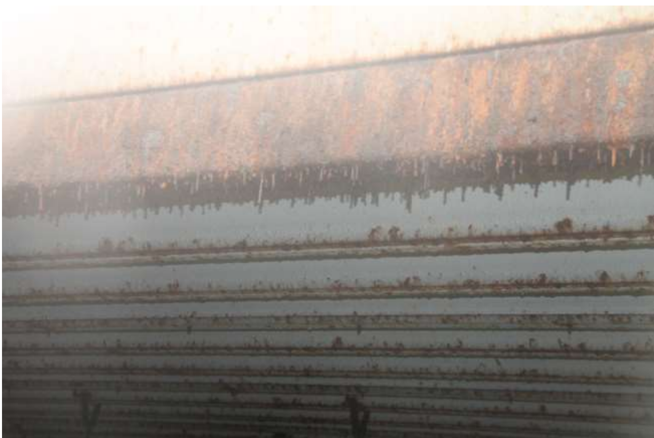
Fot. 14. Hala –łącznik operacyjny: 409B (PL4743) –krawędź ściany pasma świetlnego i blachy trapezowej. Widoczne zaschnięte wykropliny zanieczyszczeń i rdzy oraz stan zachowania elementów stalowych.
