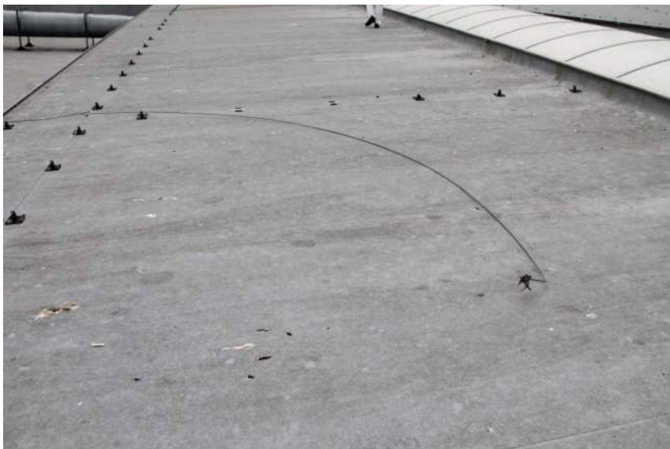
Fot. 16. Hala –łącznik operacyjny: 409B (PL4743) –Uszkodzenia instalacji odgromowej w postaci: odpiętych zwodów, miejscowe braki uchwytów, uszkodzone złącza.
