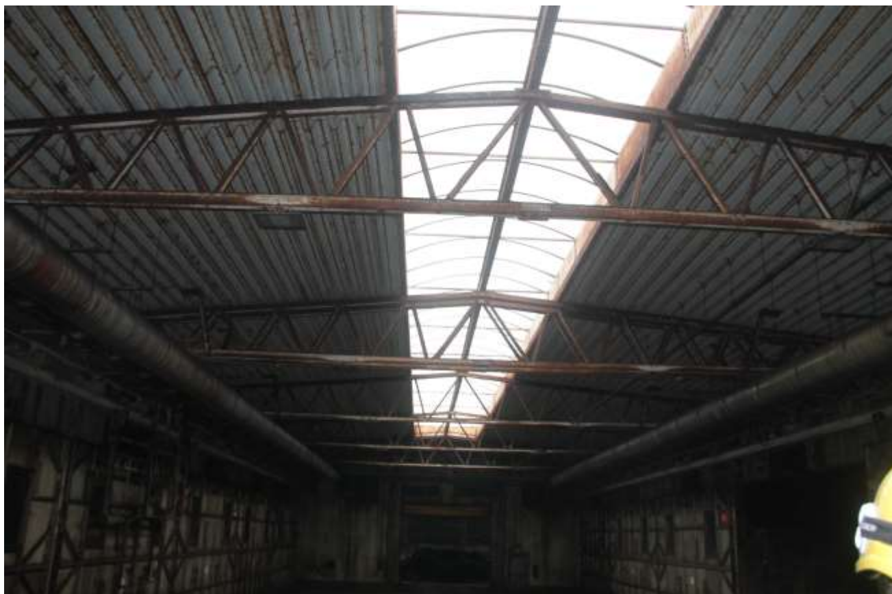
Fot. 7. Hala –łącznik operacyjny: 409B (PL4743) –Widok na pokryte korozją powierzchniową dźwigary stalowe hali.
