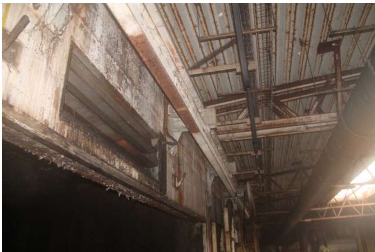
Fot. 8. Hala –łącznik operacyjny: 409B (PL4743) –Belka po której poruszają się wrota do komory intensywnego kompostowania. W miejscu otworu wentylacyjnego, gdzie występuje wzmożony przepływ zanieczyszczonego powietrza, półka dolna dwuteownika pokryta jest korozją.
