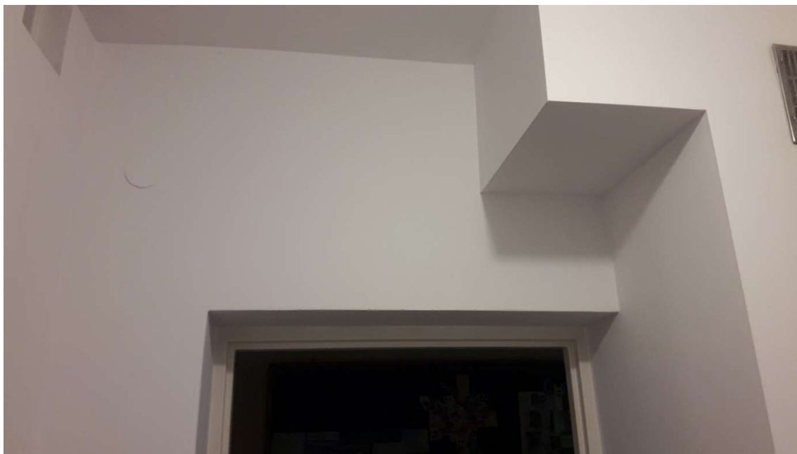
Zdjęcie 1 Pom. 1/6 obudowa kanałów wentylacji, kratka wentylacyjna, wentylacja pośrednia
