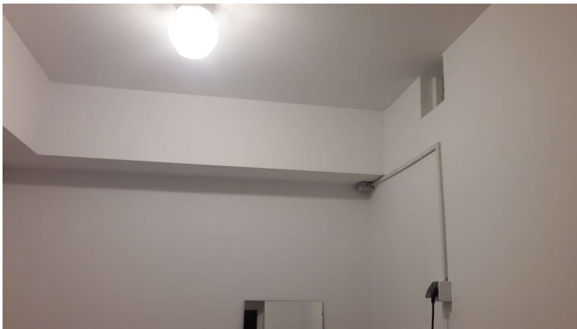
Zdjęcie 38 WC n/p 1/6 obudowa kanałów wentylacyjnych, wentylacja pośrednia
