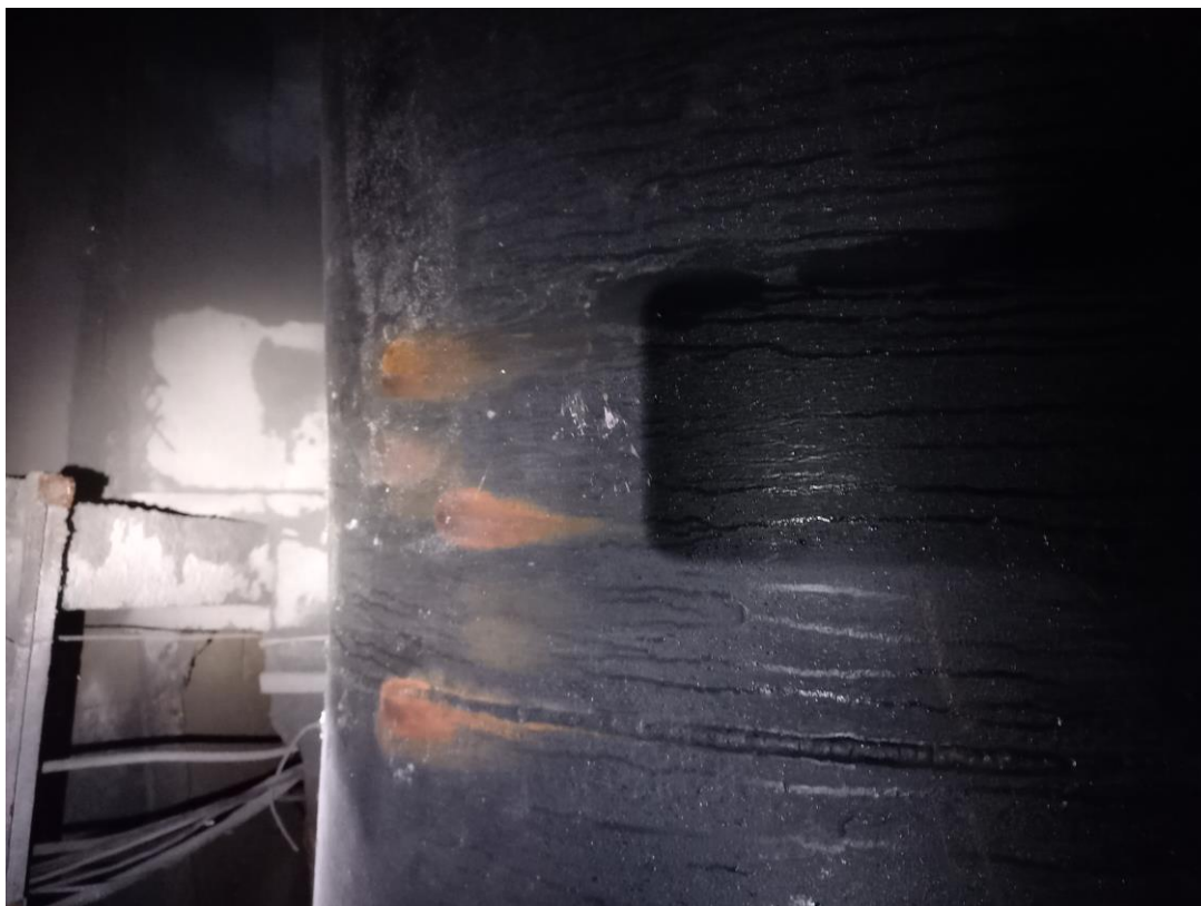
Zdj.2 Widok zewnętrznej korozji na rurociągu
