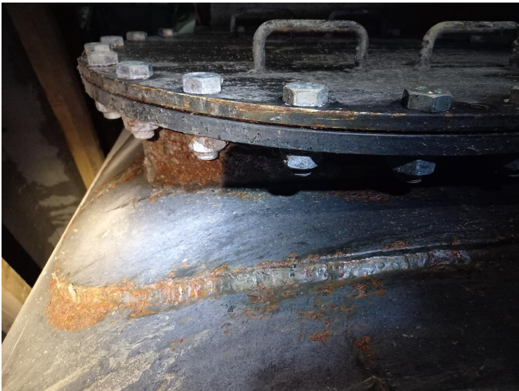
Zdj.1 Widok zewnętrznej korozji na rurociągu
