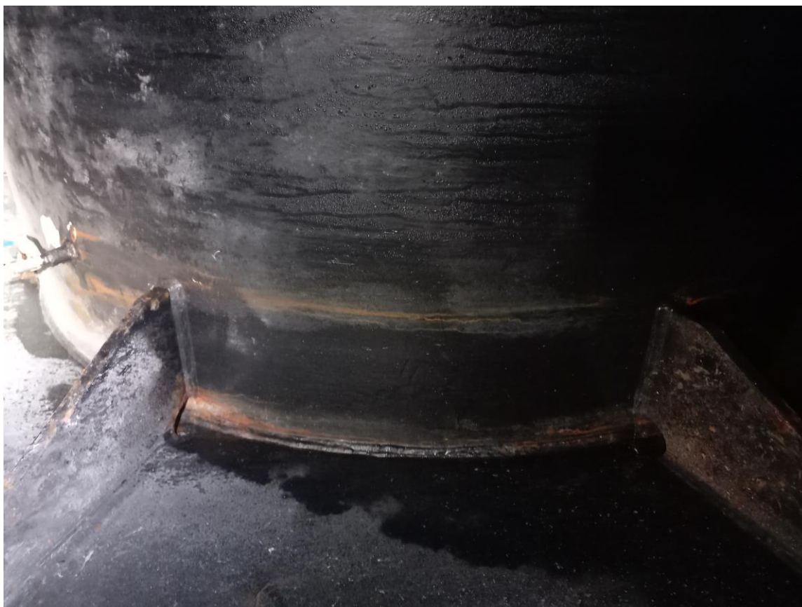
Zdj.3 Widok zewnętrznej korozji na rurociągu
