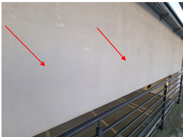
Pęknięcia powierzchniowe tynków i powłok malarskich
