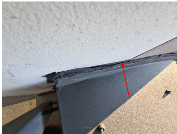
Pęknięcie uszczelnienia przy bokach parapetów
