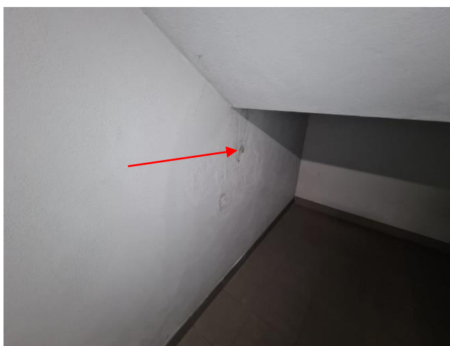
Nieszczelności, łuszczący się tynk
