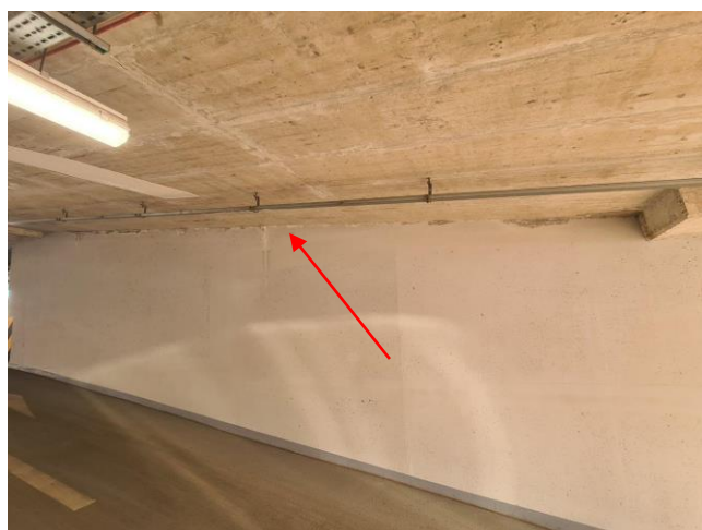
Nieszczelności powodują zamakanie ścian
