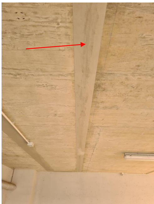
Ślady nieszczelności w miejscach naprawy konstrukcji
