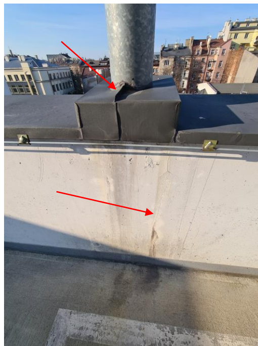
Pęknięcie konstrukcji żelbetowej, nieszczelności obróbek powodują powstawanie zacieków
