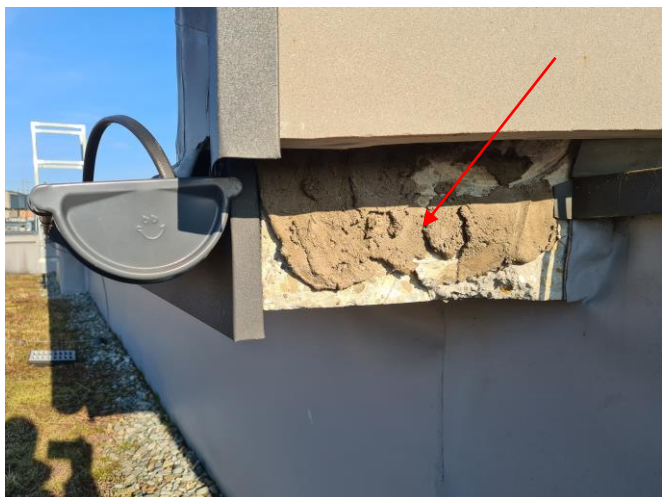
Odspojona płytki – uzupełnienie np. obróbką blacharską
