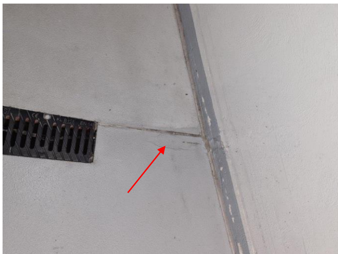
Zarysowanie wykończenia posadzki z żywicy
