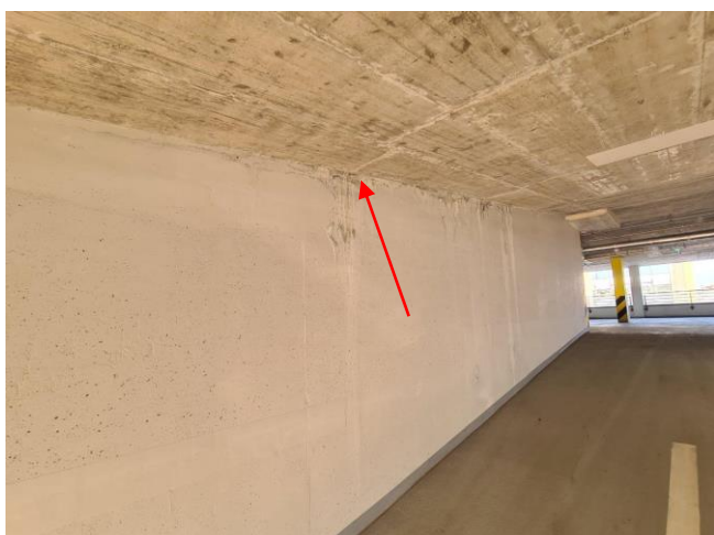
Nieszczelności powodują zamakanie ścian
