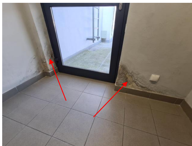
Nieszczelności powodują zawilgocenie ścian, łuszczący się tynk
