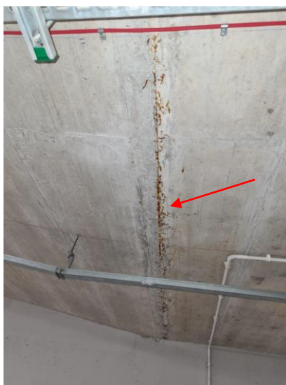
Korozja nieoczyszczonego drutu wiążałkowego przed betonowaniem
