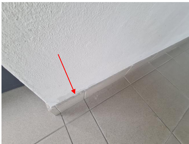
Pęknięcia powstałe przez odspojenie płytek cokołu
