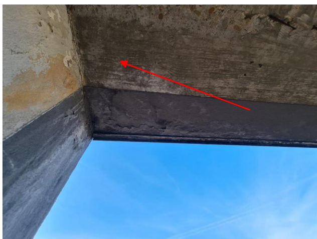
Nieszczelności powodują łuszczenie się tynku i pow. malarskich
