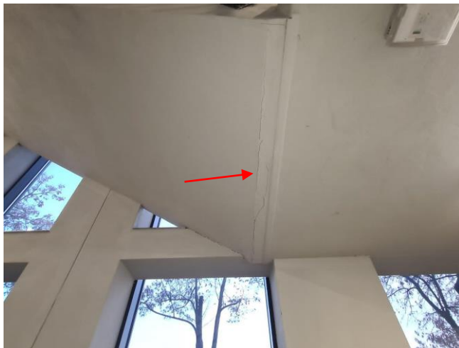
Zarysowanie konstrukcji schodów
