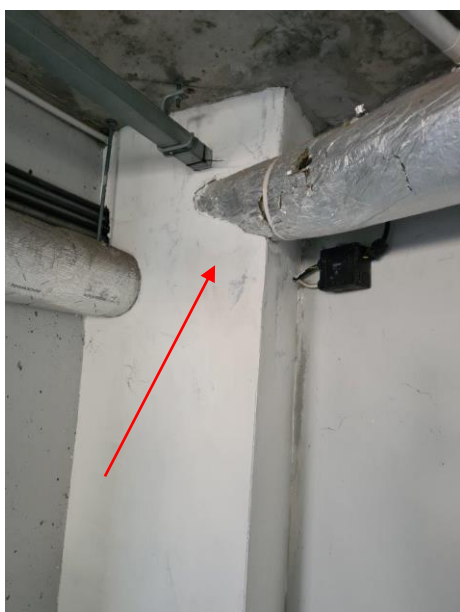
Nieszczelności powodują zamakanie ścian, brak powłok malarskich na poprawkach tynków
