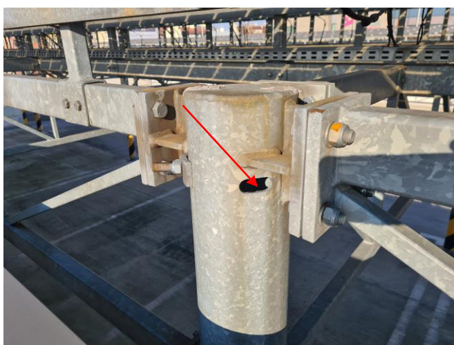
Otwory w konstrukcji stalowej należy uszczelnić – dostająca się woda do wnętrza konstrukcji powoduje gromadzenie wody i możliwe jest uszkodzenie dolnej części słupów podczas niskich temperatur
