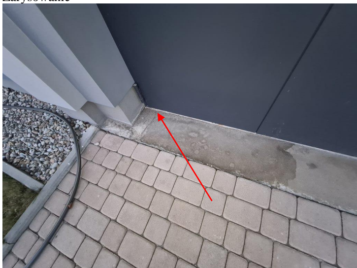
Nieszczelność pod drzwiami powoduje ścian wewnątrz pomieszczenia
