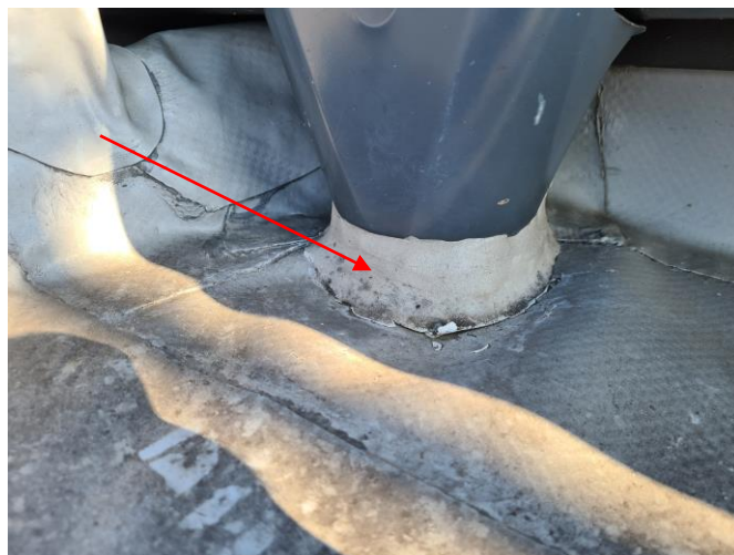
Poprawa uszczelnienia przejścia rury spustowej przez menprame PCV
