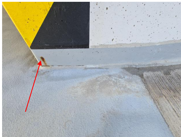
Korozja narożników stalowych podtynkowych
