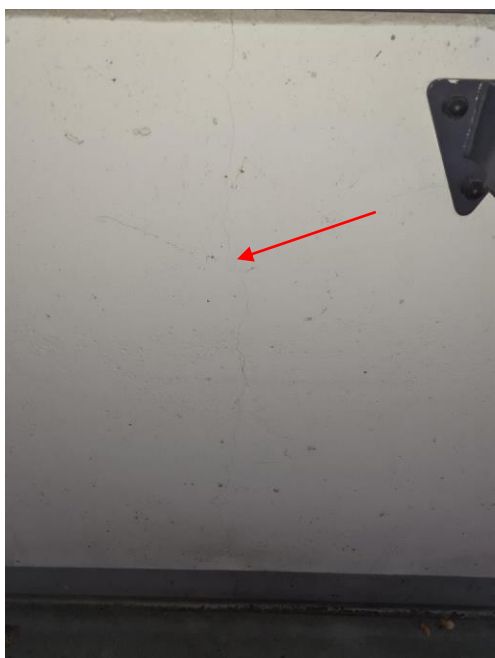
Zarysowania konstrukcji
