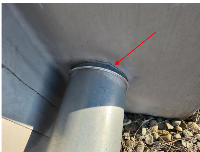
Brak uszczelnienia przy przejściu rury wentylacyjnej przez menprame PCV
