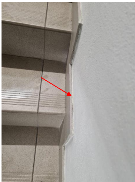
Pęknięcia przy cokole, odspojone płytki
