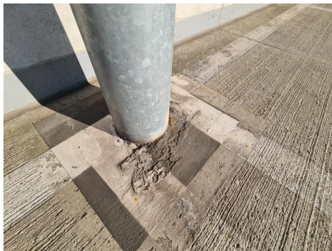
Łuszcząca się powłoka przy podstawie słupów, korozja konstrukcji nawierconych otworów w słupach
