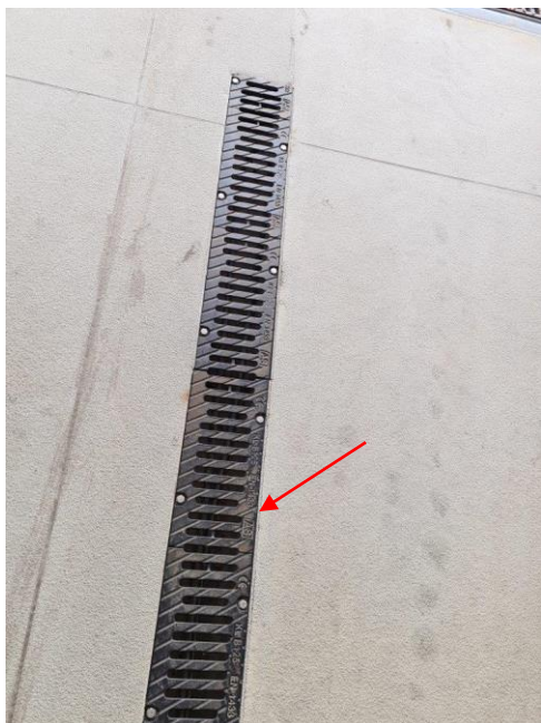
Pęknięcia żywicy przy odwodnieniu liniowym
