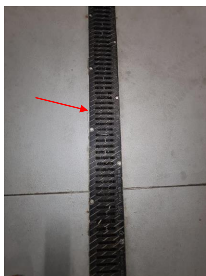
Pęknięcia żywicy przy odwodnieniu liniowym
