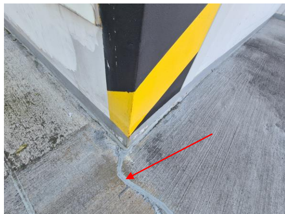
Pęknięcia uszczelnienia przy ścianie i zarysowań płyty
