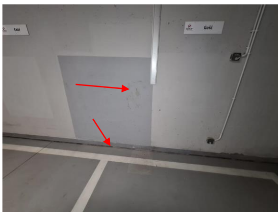
Zawilgocona ściana przez nieszczelności, pęknięte uszczelnienie posadzki przy ścianie
