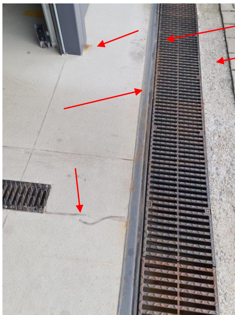
Korozja profilu stalowego przy odwodnieniu liniowym i drzwiach, uszkodzone koryto betonowe, łuszczący się beton
