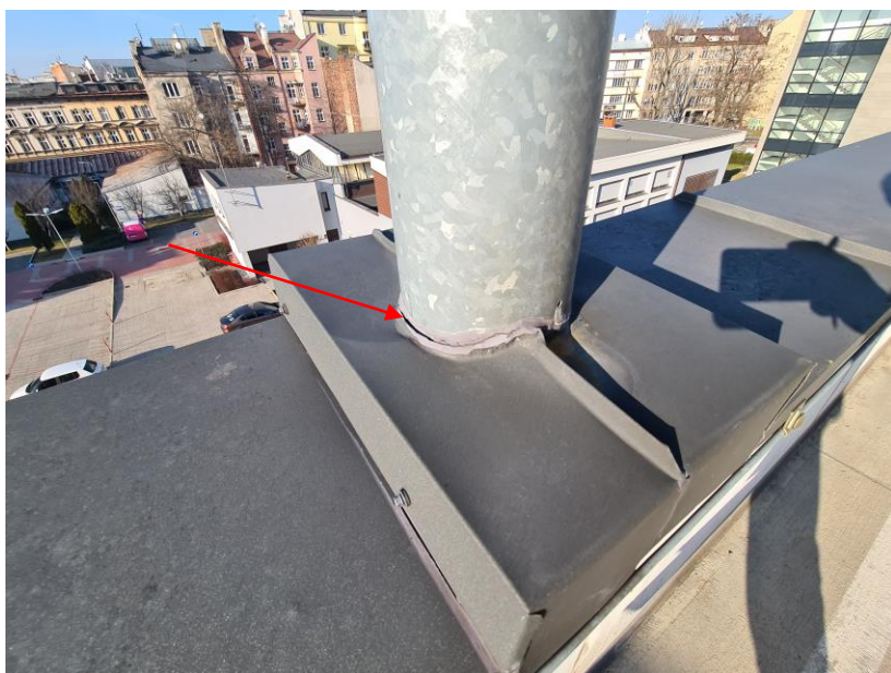
Pęknięte uszczelnienie na przy obróbkach blacharskich
