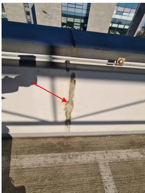
Nieszczelności powodują zacieki
