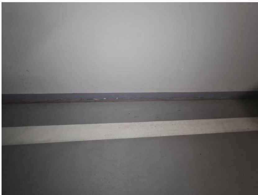
Pęknięcia przy posadzce uszczelnienia
