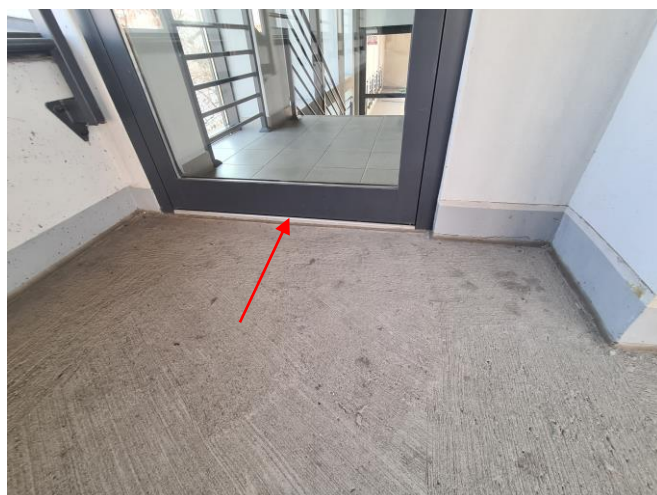
Nieszczelności uszczelnień przy drzwiach
