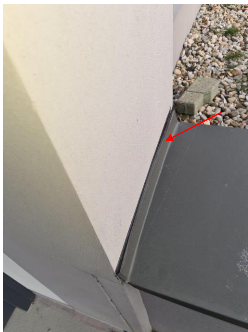
Pęknięcie uszczelnienia
