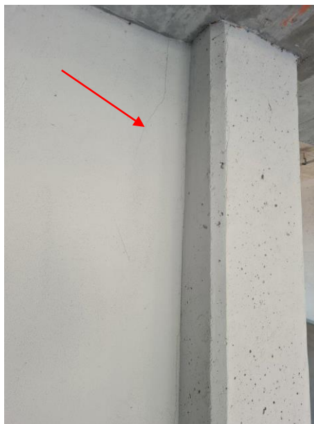
Zarysowania konstrukcji
