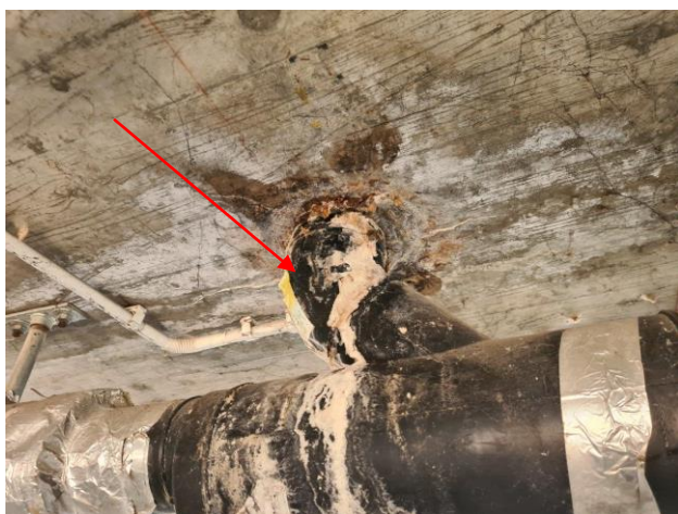
Brak izolacji, nieszczelności przy przejściach rur połączonych z odwodnieniem liniowym
