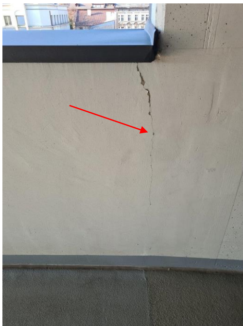
Zarysowania konstrukcji żelbetowych
