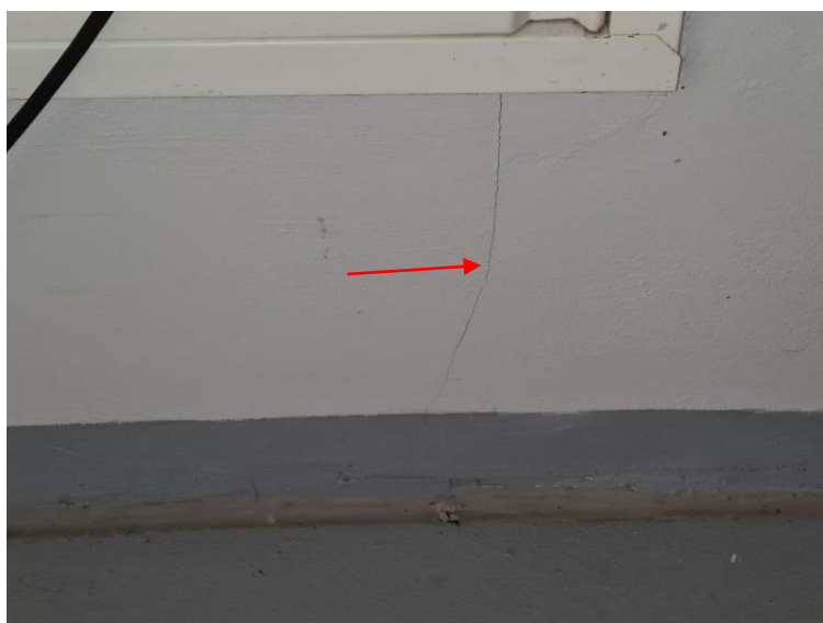
Pęknięcia pionowe ścian
