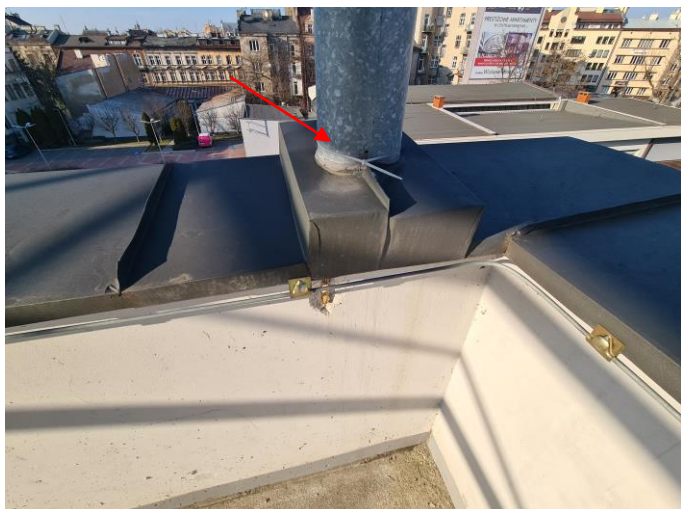
Pęknięte uszczelnienie na przy obróbkach blacharskich
