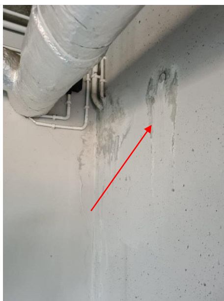
Nieszczelności powodują zamakanie ścian, brak powłok malarskich na poprawkach tynków
