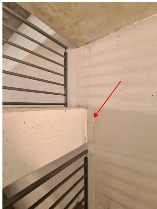
Nieszczelności powodują zamakanie ścian
