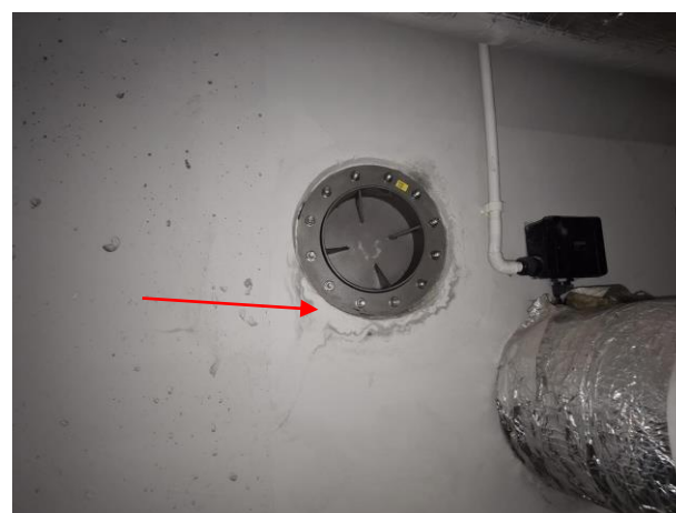
Nieszczelność zabezpieczonego przejścia
