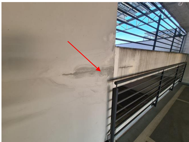
Zarysowania konstrukcji żelbetowych i nieszczelności
