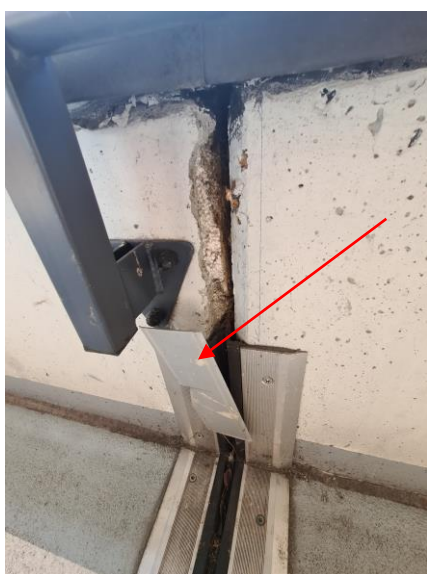
Odpadające elementy na przerwach dylatacyjnych
