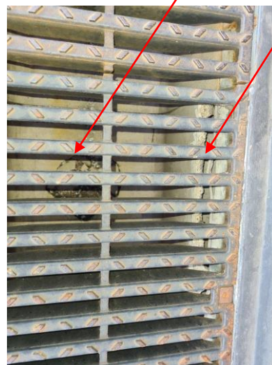
Korozja profilu stalowego przy odwodnieniu liniowym i drzwiach, uszkodzone koryto betonowe, łuszczący się beton
