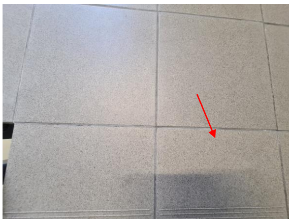
Pęknięcia wypełnień /fugi/
