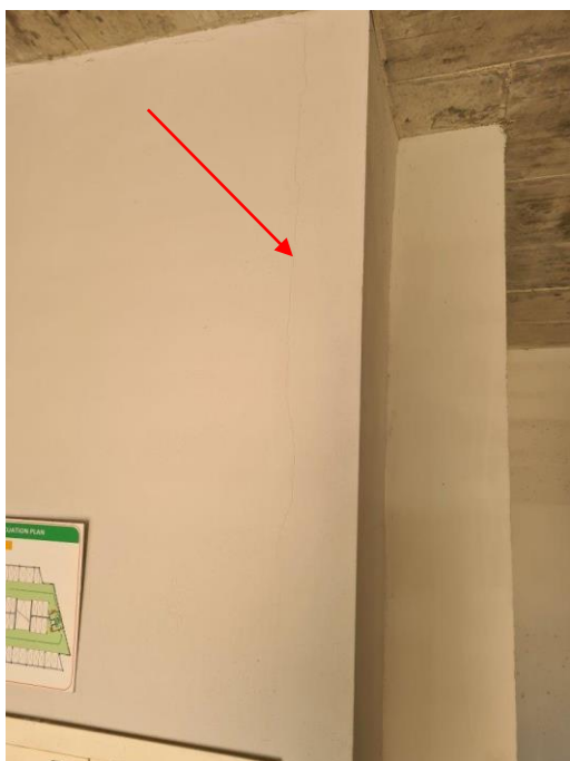
Zarysowania wypełnienia murowanego
