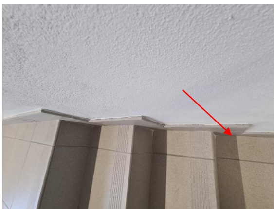
Miejscowe odspojenia płytek na cokołach
