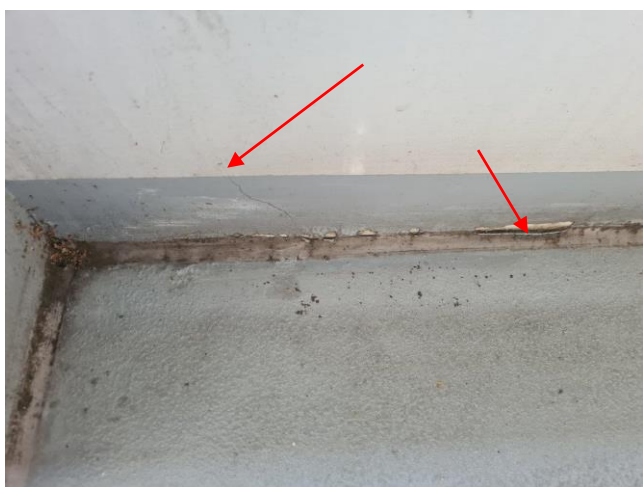
Zarysowanie konstrukcji, pęknięcie uszczelnienia pomiędzy ścianą a posadzką
