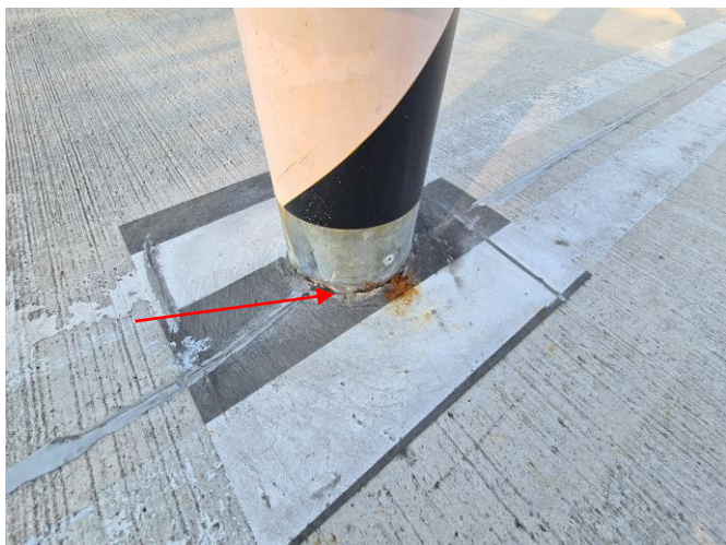
korozja konstrukcji słupów w nawierconych otworach
