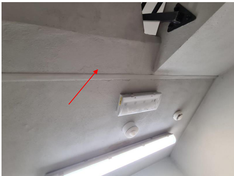
Zarysowania tynku na konstrukcji schodów
