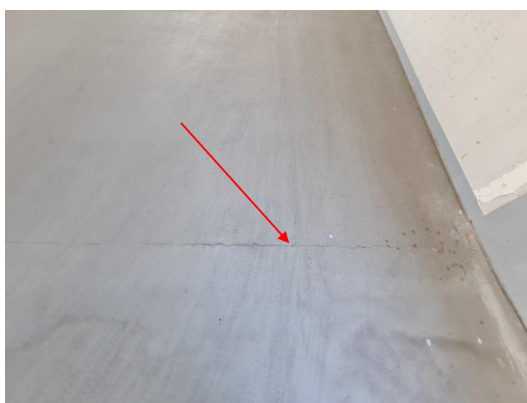
Zarysowania konstrukcji ramp zjazdowych
