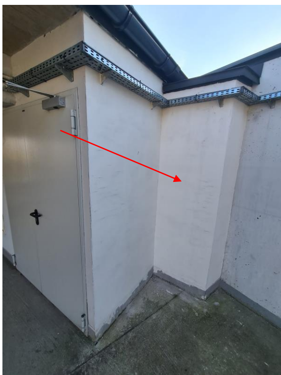
Brak powłok malarskich w miejscach naprawy tynku
