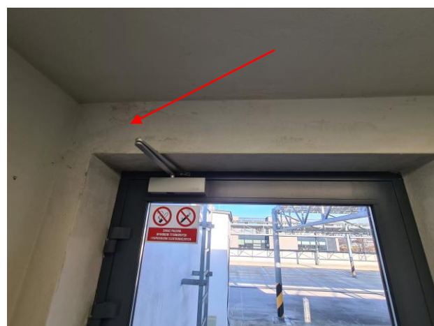
Zacieki i łuszczący się tynk wewnątrz kl. schodowej
