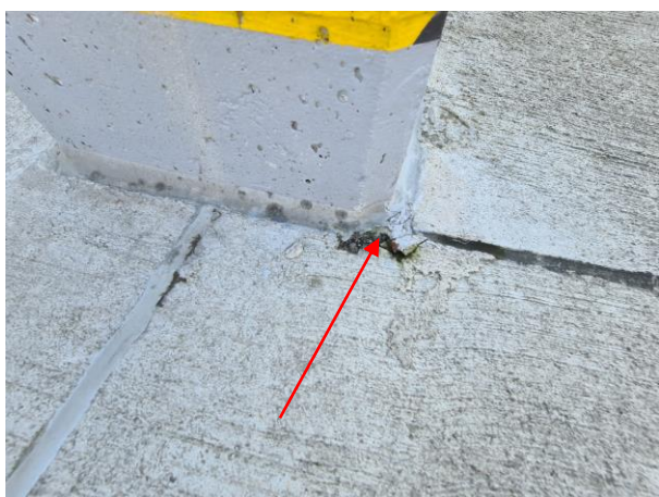
Nieszczelności wypełnień dylatacyjnych
