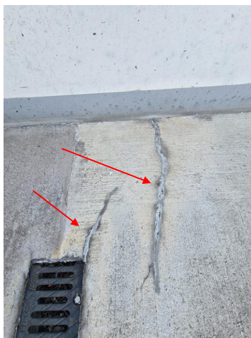
Naprawa pęknięć płyty
