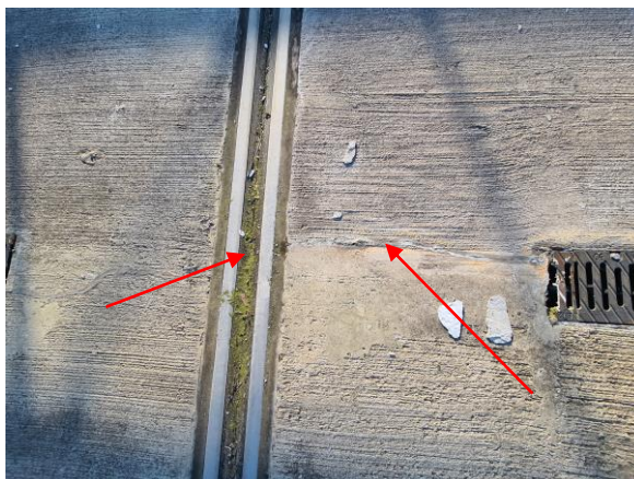
Zarysowania płyt betonowych, nieprawidłowe wykonanie spadków powoduje gromadzenie wody w dylatacji
