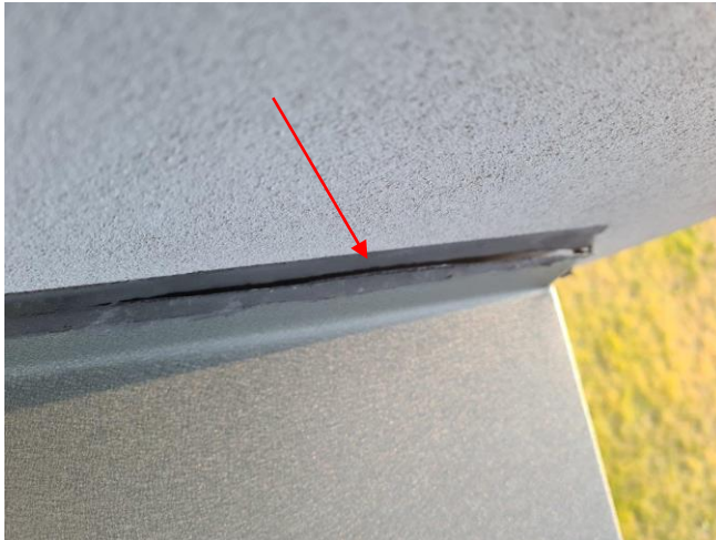
Pęknięcie uszczelnienia
