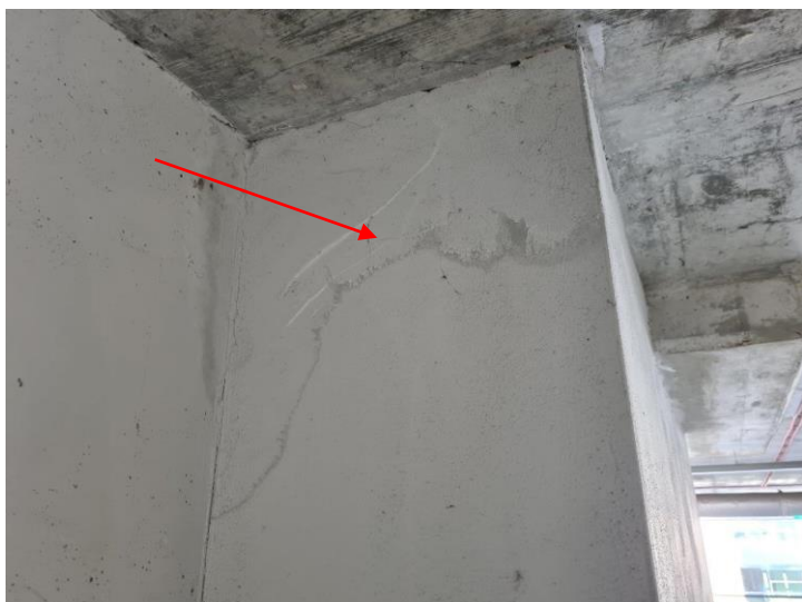
Nieszczelności powodują zamakanie ścian
