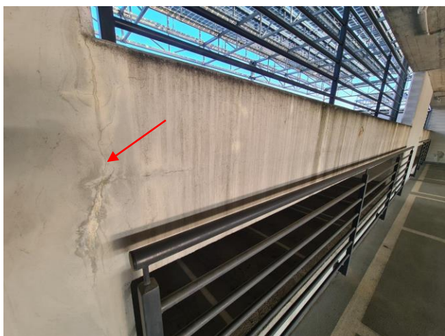
Zarysowania konstrukcji żelbetowych
