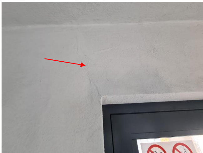
Zarysowanie konstrukcji ścian
