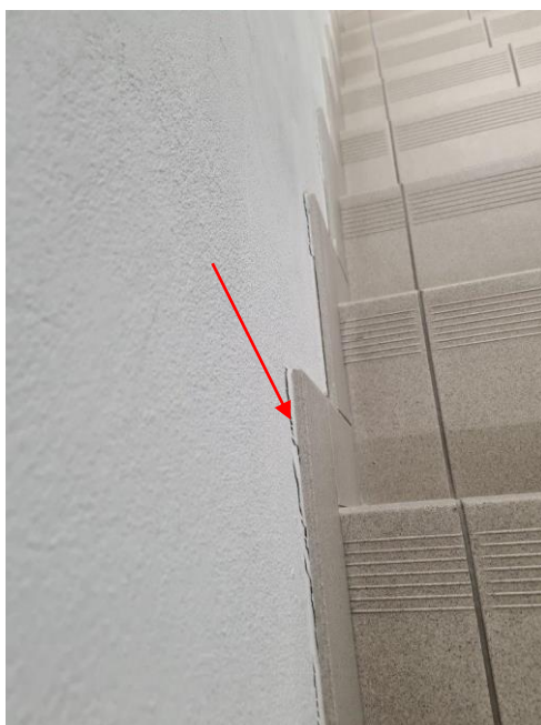
Odspojone płytki na cokole
