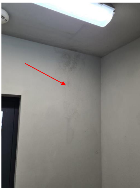
Nieszczelności powodują zamakanie ścian
