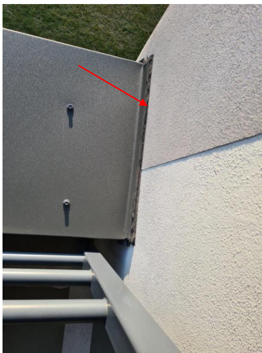
Pęknięcie wypełnienia
