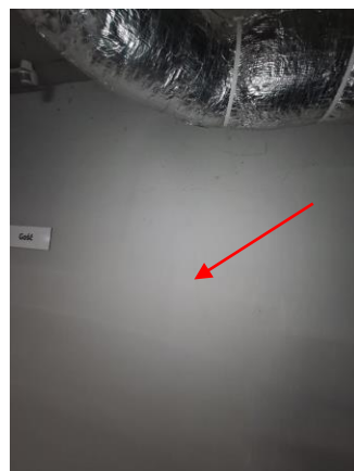
Zawilgocona ściana przez nieszczelności, pęknięte uszczelnienie posadzki przy ścianie
