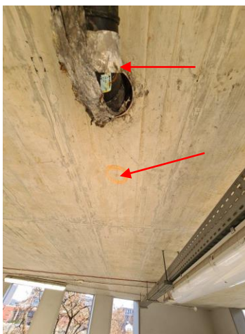
Zarysowanie konstrukcji stropu
