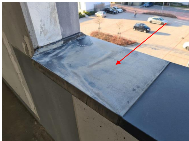
Wymiana / lakierowanie zniszczonej obróbki – uszkodzenie powstałe przez nieszczelności
