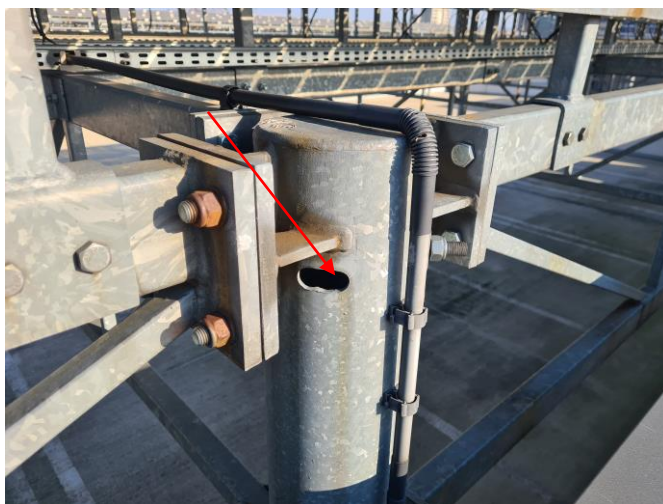
Otwory w konstrukcji stalowej należy uszczelnić – dostająca się woda do wnętrza konstrukcji powoduje gromadzenie wody i możliwe jest uszkodzenie dolnej części słupów podczas niskich temperatur
