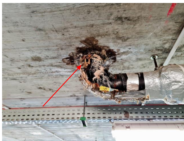
Brak izolacji, nieszczelności przy przejściach rur połączonych z odwodnieniem liniowym
