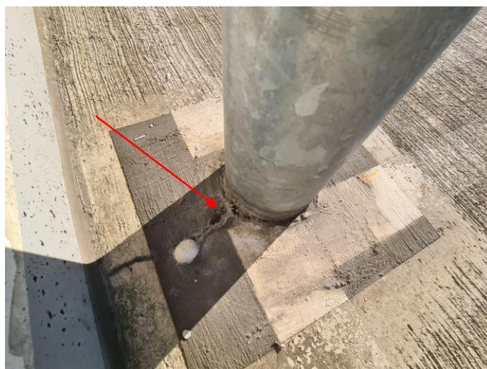
Łuszcząca się powłoka przy podstawie słupów, korozja konstrukcji słupów w nawierconych otworach
