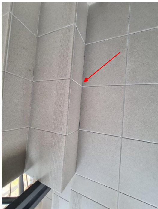
Zarysowanie wypełnienia pomiędzy płytkami
