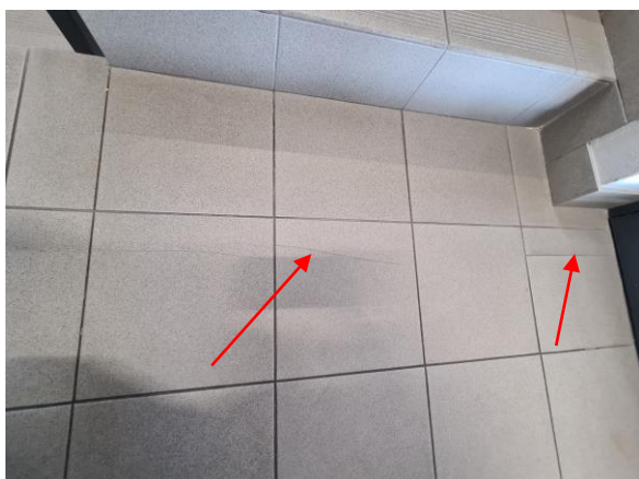
Pęknięte i odspojone płytki
