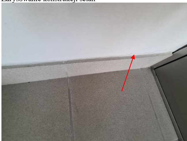
Pęknięcia powstałe przez odspojenie płytek cokołu
