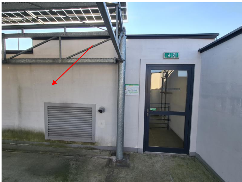
Pęknięcia tynku i powłok malarskich, nieszczelność przy drzwiach
