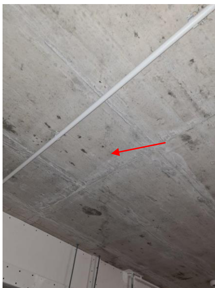
Zarysowania ukośne konstrukcji
