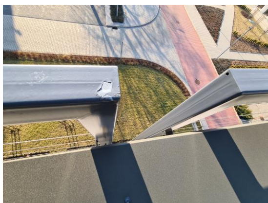
Pęknięcie uszczelnienia przy bokach parapetów
