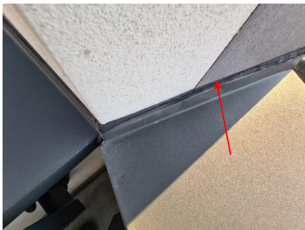
Pęknięcie uszczelnienia przy bokach parapetów
