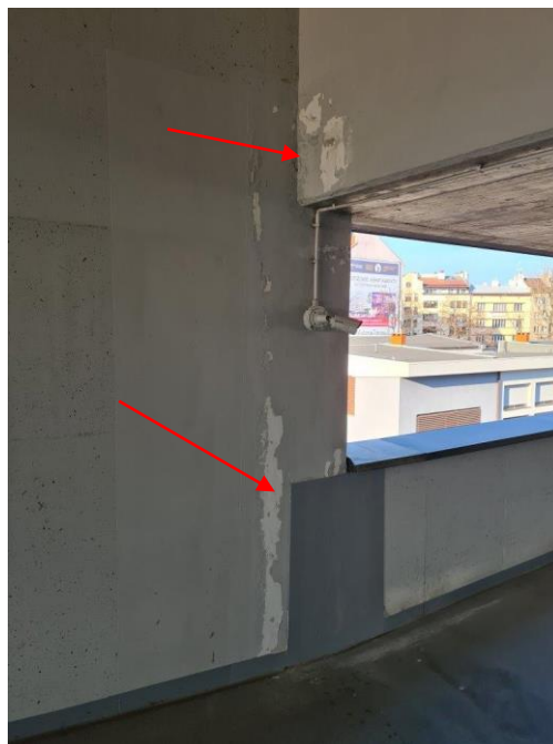
Nieszczelności powodują łuszczenie się tynku i pow. malarskich
