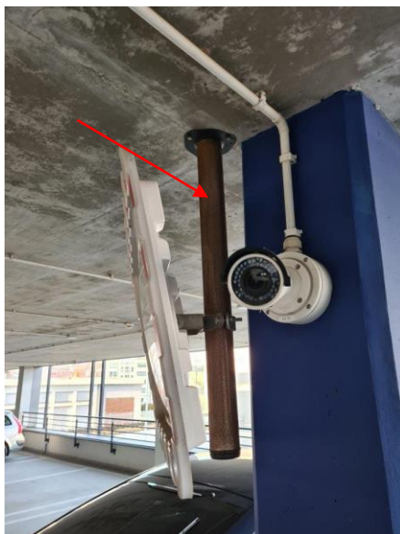
Korozja słupka lustra
