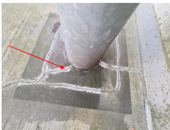
Nowe pęknięcia naprawianych zarysowań płyty
