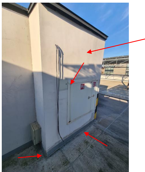
Korozja narożników stalowych i skrzynki hydrantu, pęknięcia uszczelnienia przy ścianie, pęknięcia i odspojenia zaprawy na ścianie
