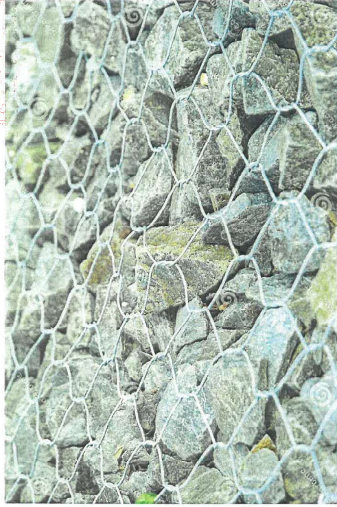
Rysunek 250t. Przykładowe rozwiązanie montażu kamienia łupanego w siatce metalowej.
