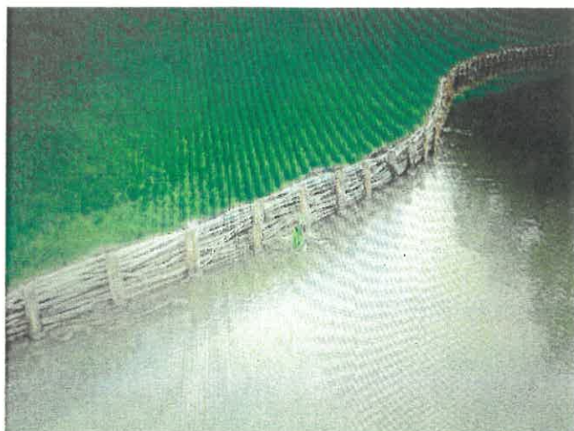
Rysunek 1 Fot. Przykładowe rozwiązanie montażu faszyny.
