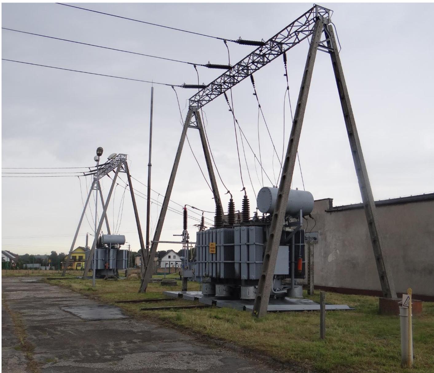
Fot. 3. Leszczyny – stanowiska transformatorów mocy
