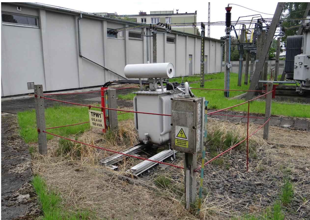
Obroki – stanowisko transformatora potrzeb własnych
