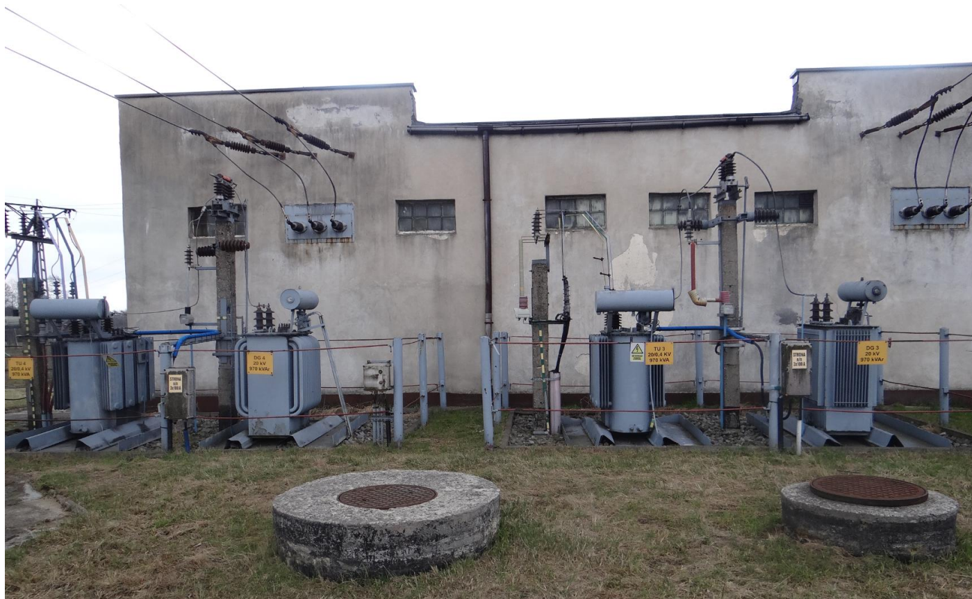
Fot. 5. Leszczyny – stanowiska zespołów uziemiających 20 kV
