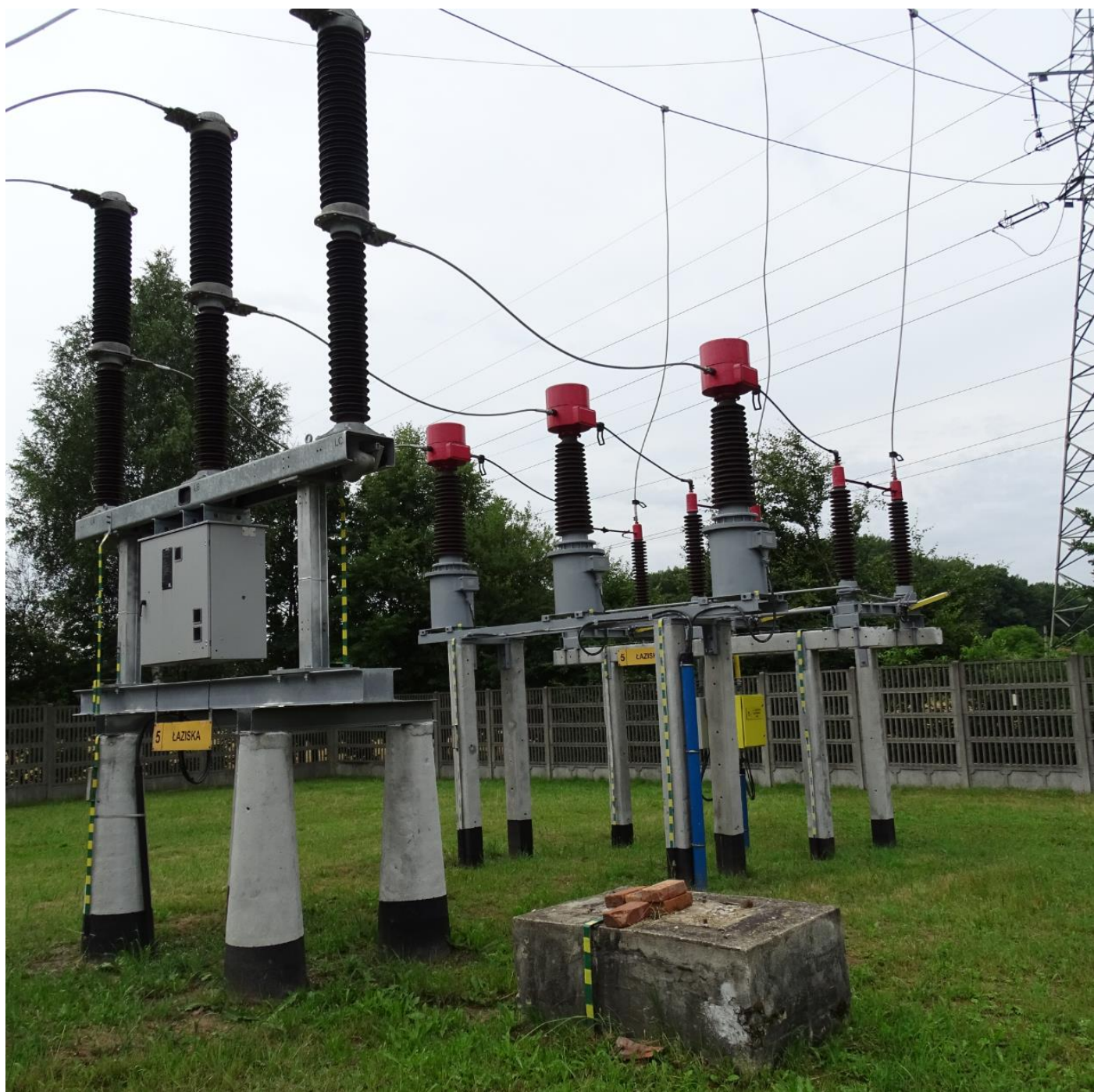
Fot. 3. Orzesze – pozostały po wymianie fundament napędu wyłącznika (3 szt. do demontażu)
