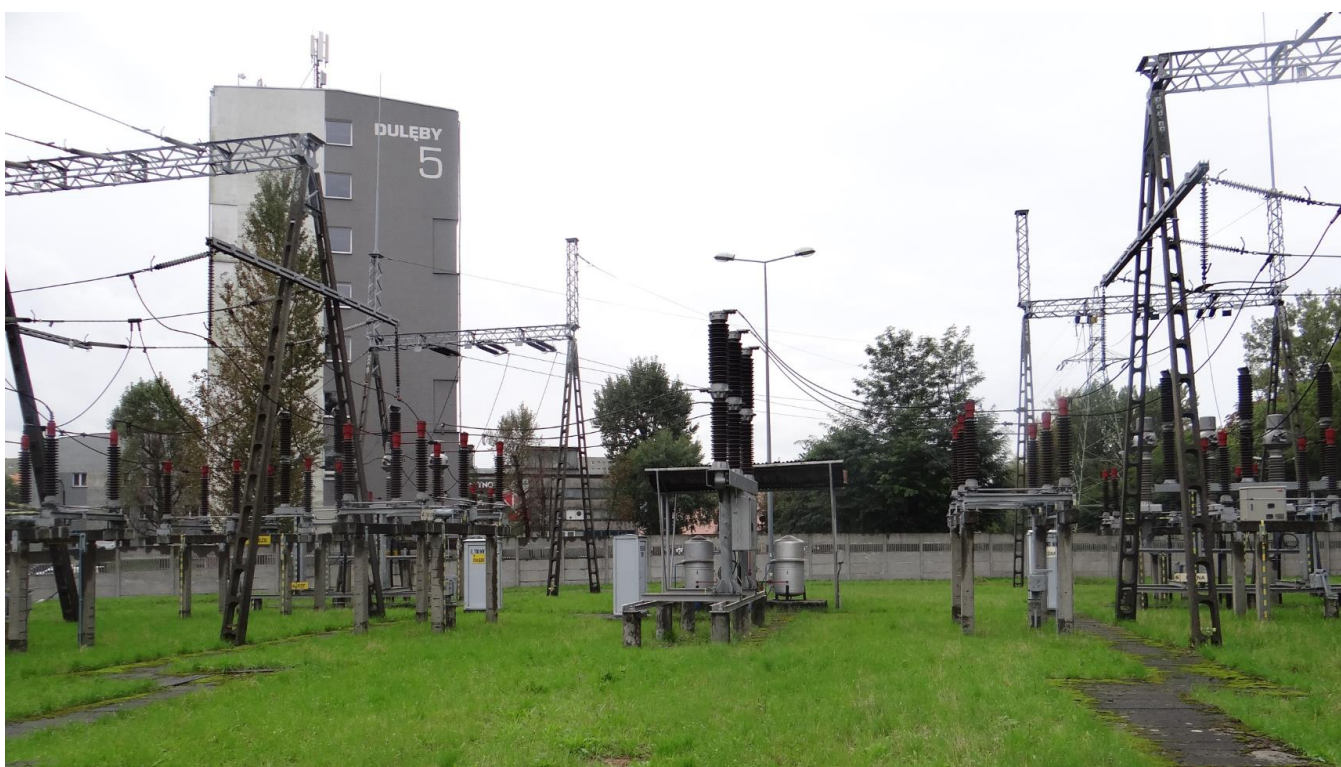
Fot. 5. Obroki – rozdzielnia 110 kV
