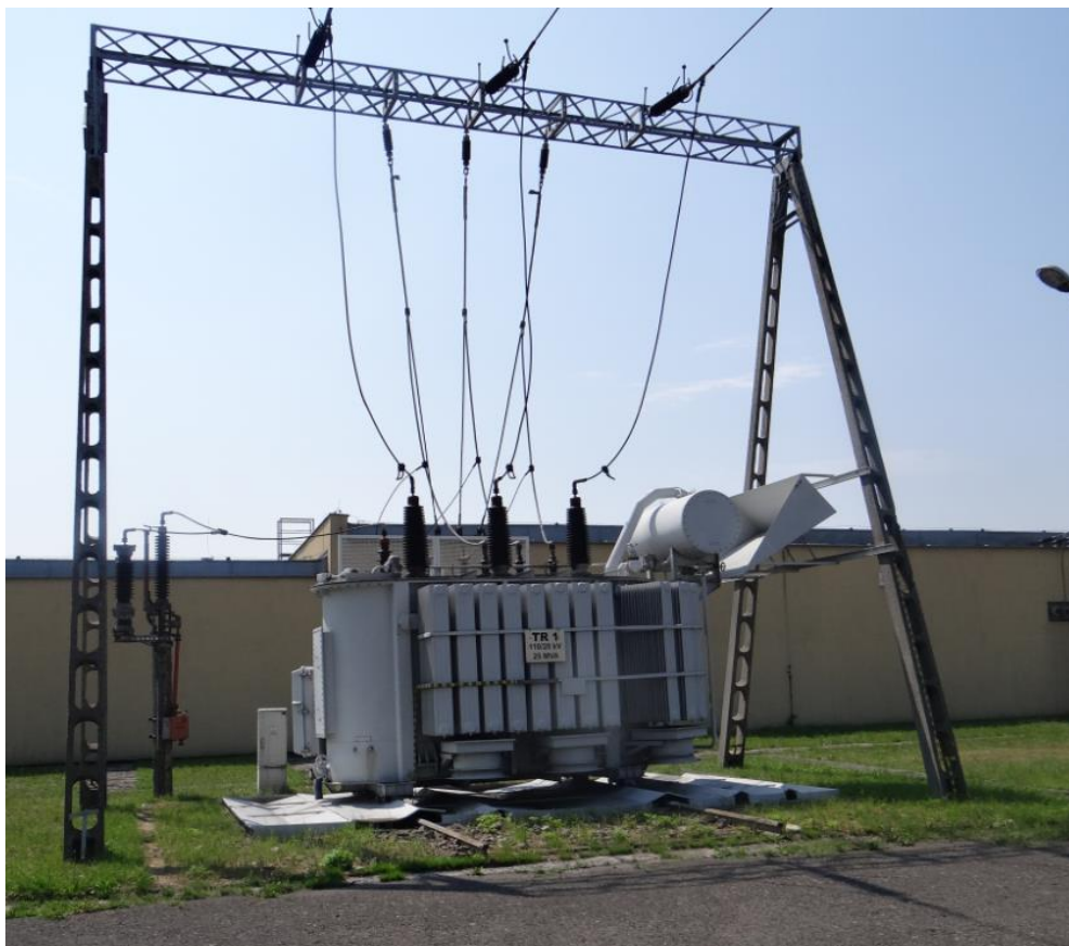
Fot. 2. Reta – bramka TR1, ekrany ociekowe na stanowisku
