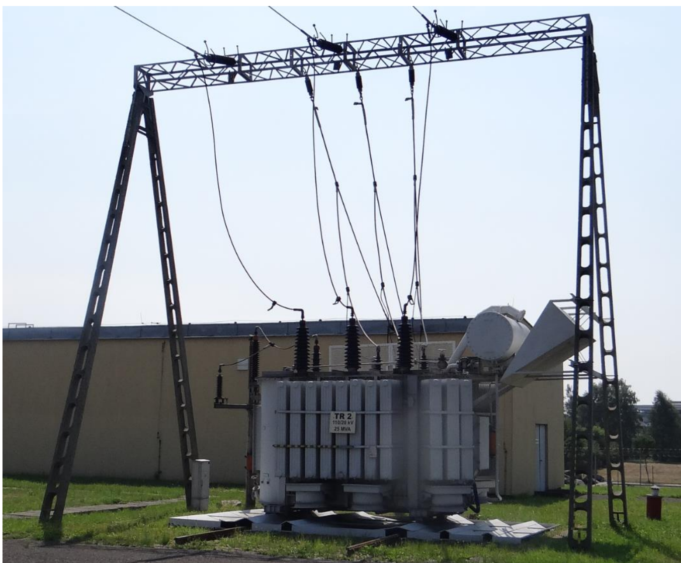
Fot. 4. Reta – bramka TR1, ekrany ociekowe na stanowisku
