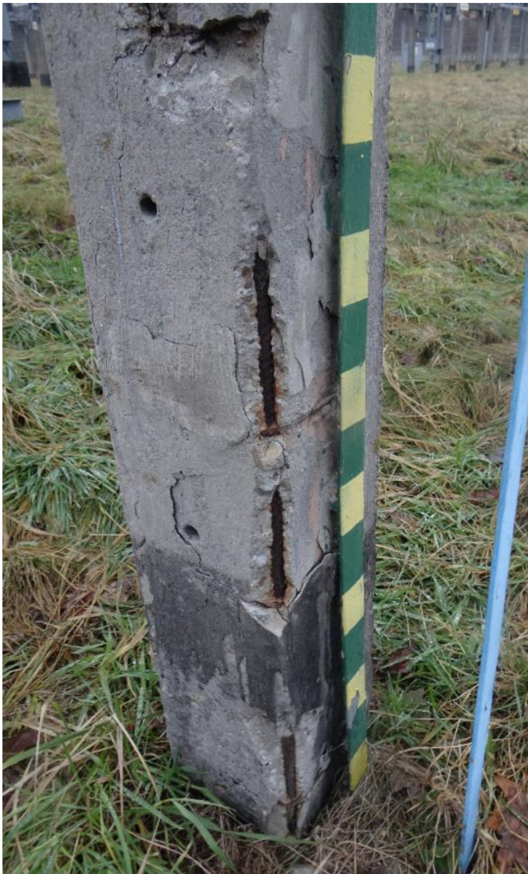
Fot. 4. Orzesze – przykładowa konstrukcja betonowej konstrukcji wsporczej do renowacji
