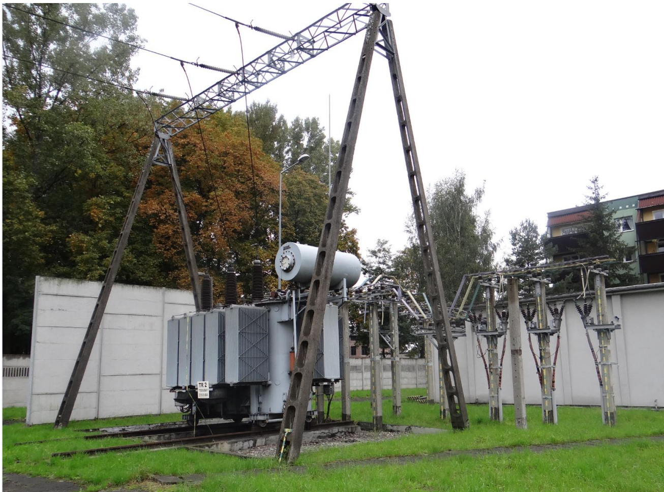
Fot. 2. Obroki – stanowisko TR2, na drugim planie ściana ogniowa
