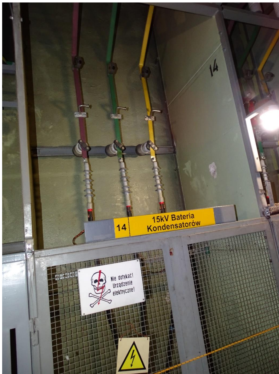
Miejsce zabudowy odłącznika kablowego
