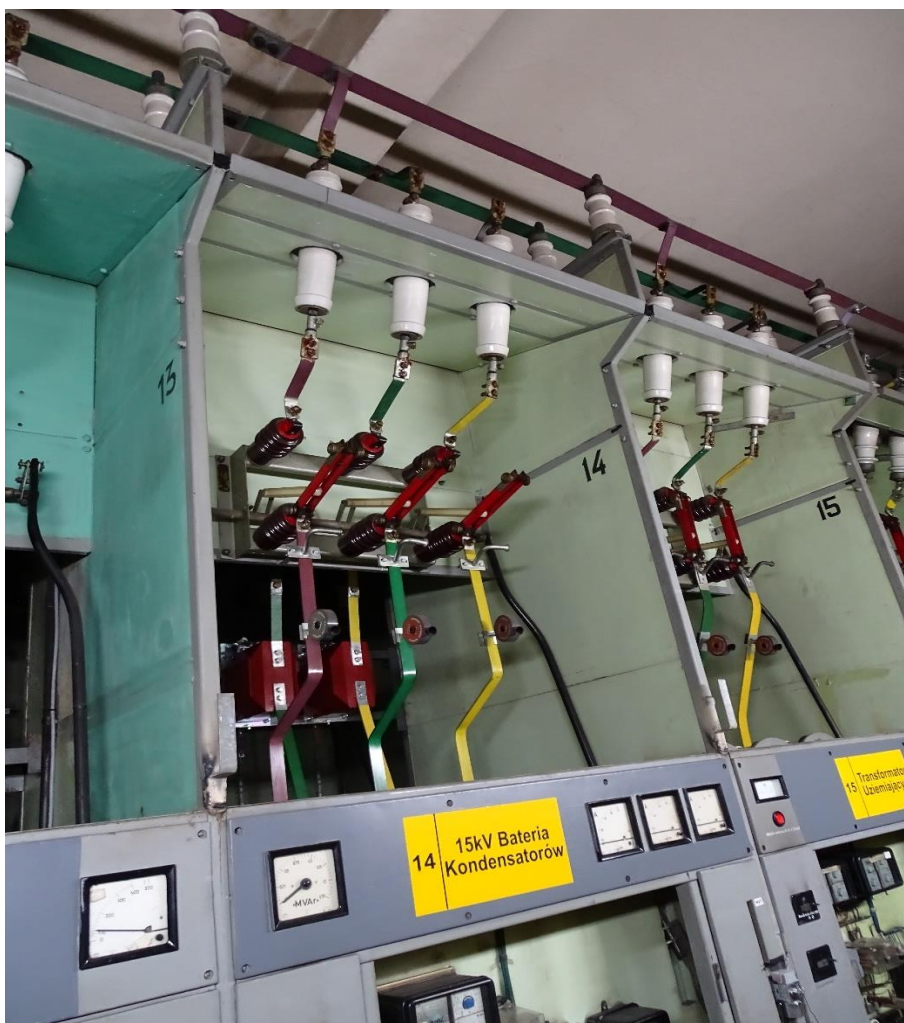
Istniejący odłącznik szynowy i przekładniki prądowe
