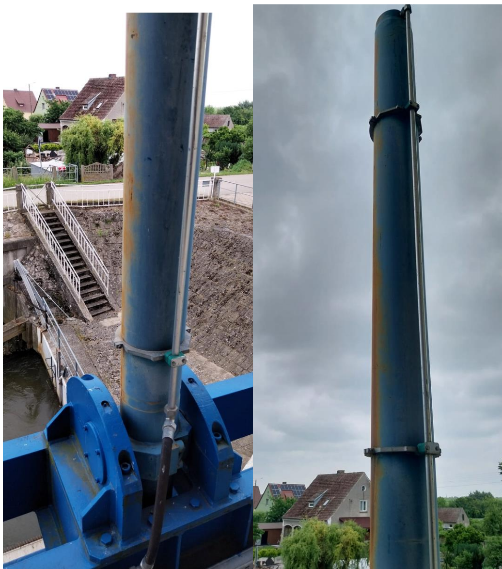
Zdjęcie 1 – widok siłownika na zasuwie turbozespołu nr 1
