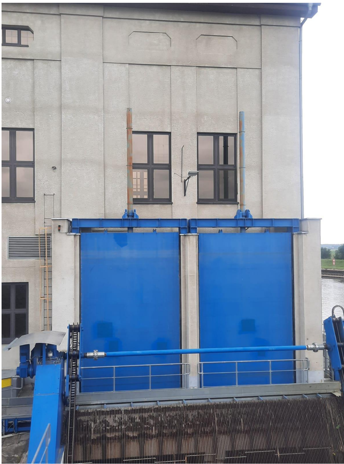
Zdjęcie 3 – widok siłowników na zasuwach turbozespołów nr 1 i 2
