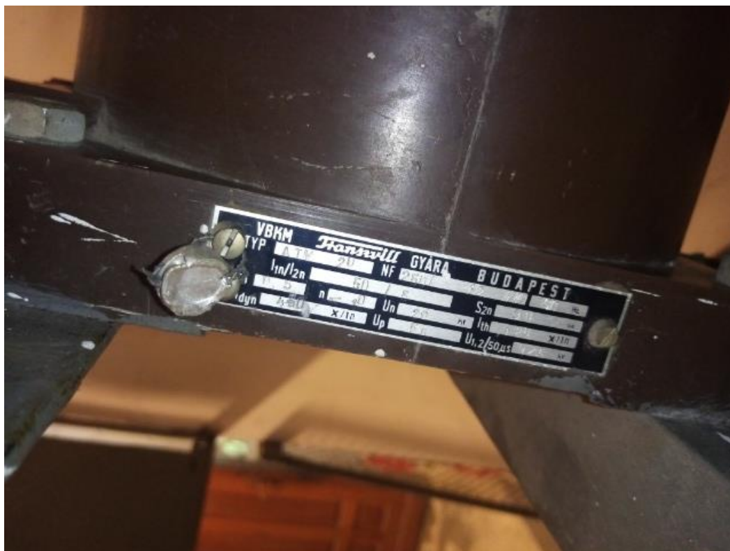
Zdj.2 Parametry zamontowanego przekładnika
