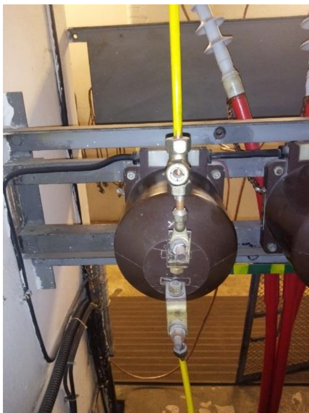
Zdj.1 Obecnie zamontowany przekładnik
