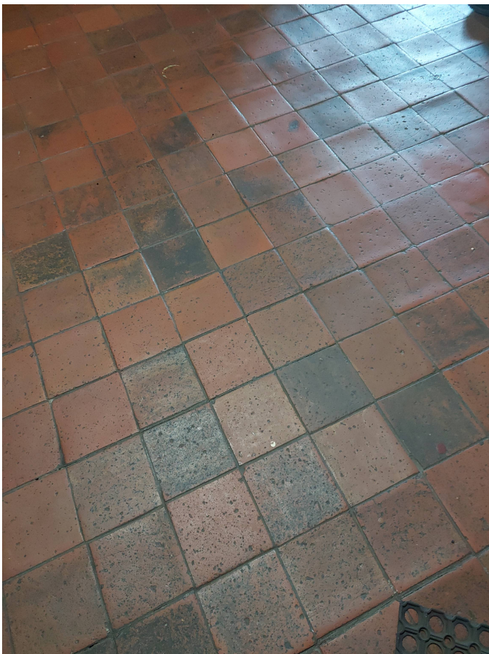
Fot.6. Posadzka klatki schodowej 2 – uszkodzenia wewnątrz
