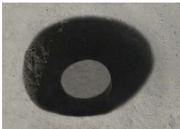
Rys.2 Kotwa transportowa DEHA/Kontakt SK
