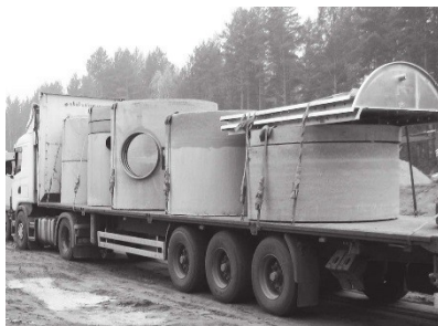
Rys.12 Transport elementów prefabrykowanych
