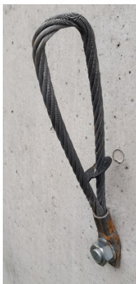
Rys. 11 Prawidłowo zamontowane zawiesie pętlowe do prefabrykatu
