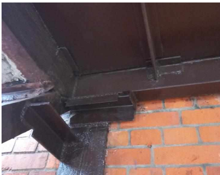
Widoczne zniszczenia konstrukcji schodów
