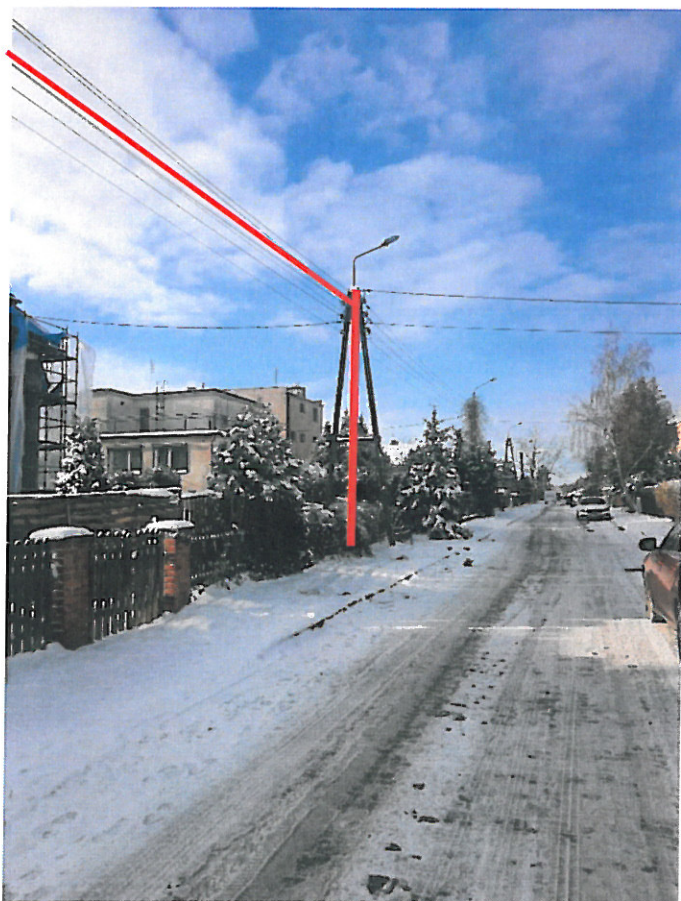
linia od słupa 406 do 408, T-5266 do przebudowy na AsXSn 4x70 + AsXSn 2x25
