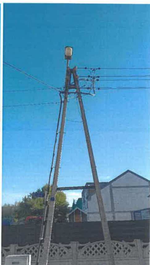
Zdj.4 Istn. słupów z infrastrukturą EOP przeznaczoną do demontażu
