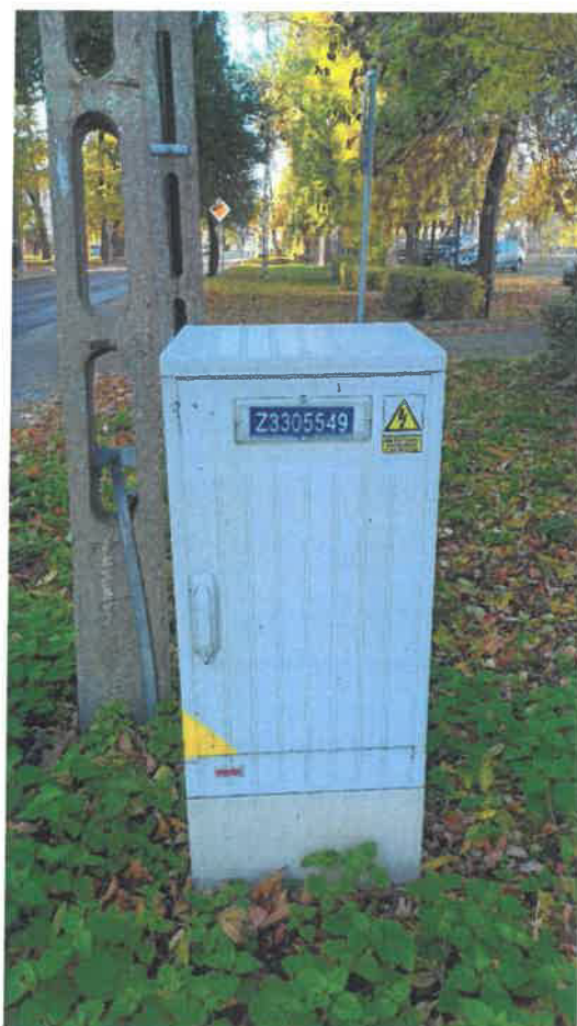
Zdj.2 Istn. złącza kablowego nr Z3305549
