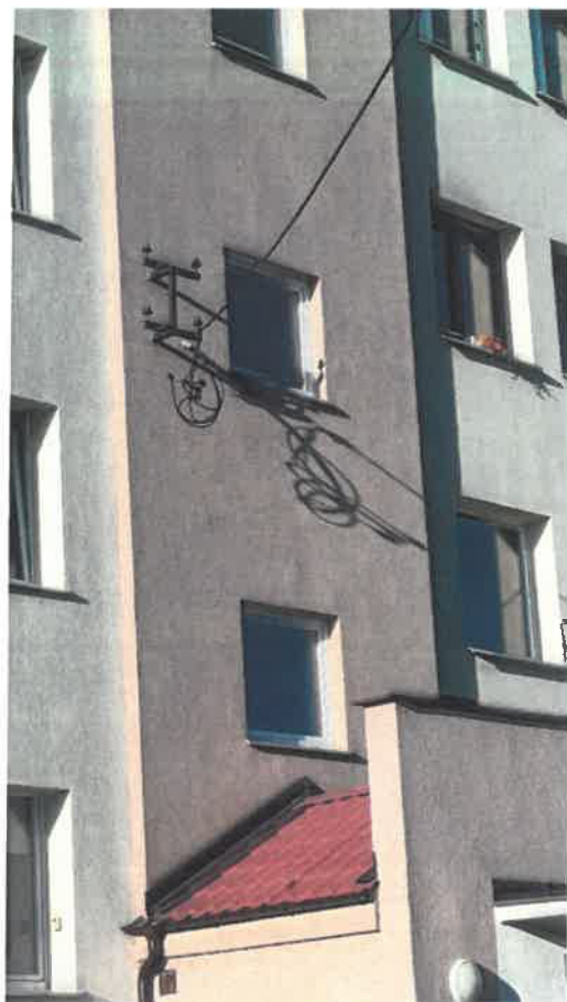
Zdj.5 Istn. przyłączy napowietrznych przeznaczonych do demontażu przy ul. Obrońców Westerplatte nr 9 oraz 7
