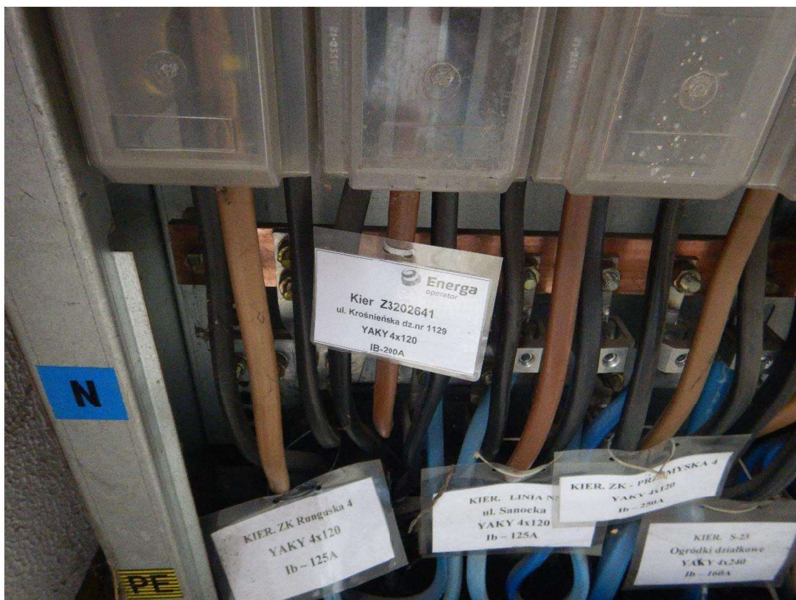
Rozdzielnia nn w T-2294 (fragment)
