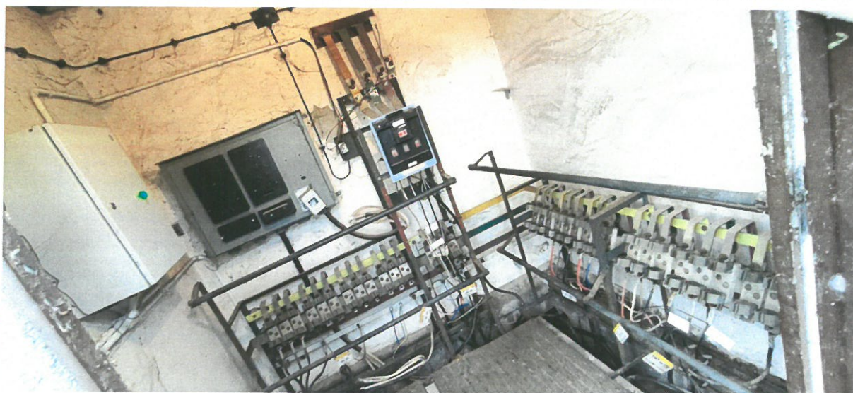
Zdjęcie 5. Rozdzielnica nn-0,4kV do wymiany
