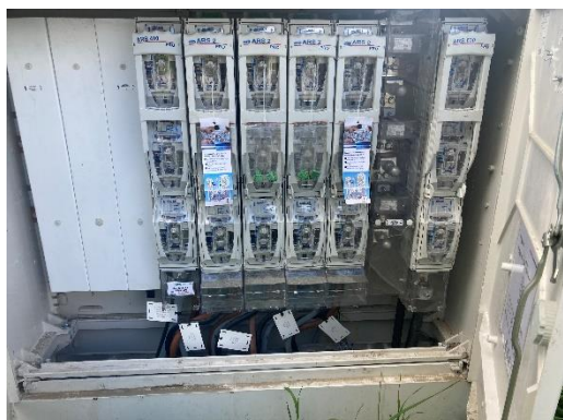
1)Rozdzielnica nn stacji
