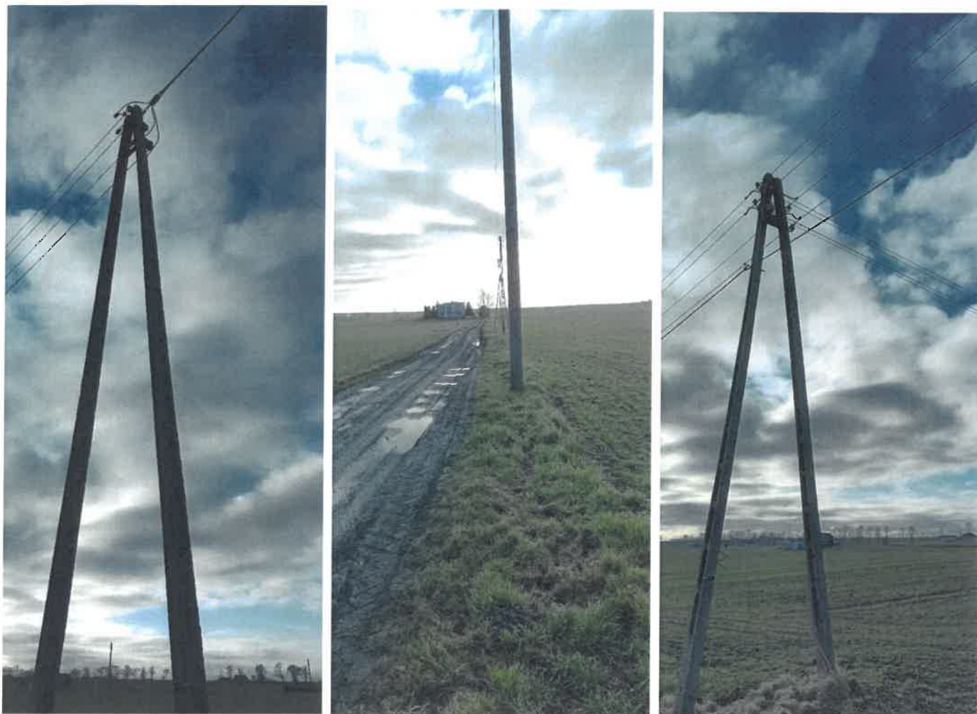
Zdj. 3 Zdjęcia istniejących słupów nr 101, 102 oraz 103 z linią napowietrzną AsXSn 4x70mm 2 i AL. 3x50+70mm 2 przeznaczonymi do demontażu lub wymiany
