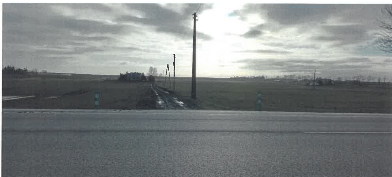
Zdj. 3 Zdjęcia istniejących słupów nr 101, 102 oraz 103 z linią napowietrzną AsXSn 4x70mm 2 i AL. 3x50+70mm 2 przeznaczonymi do demontażu lub wymiany
