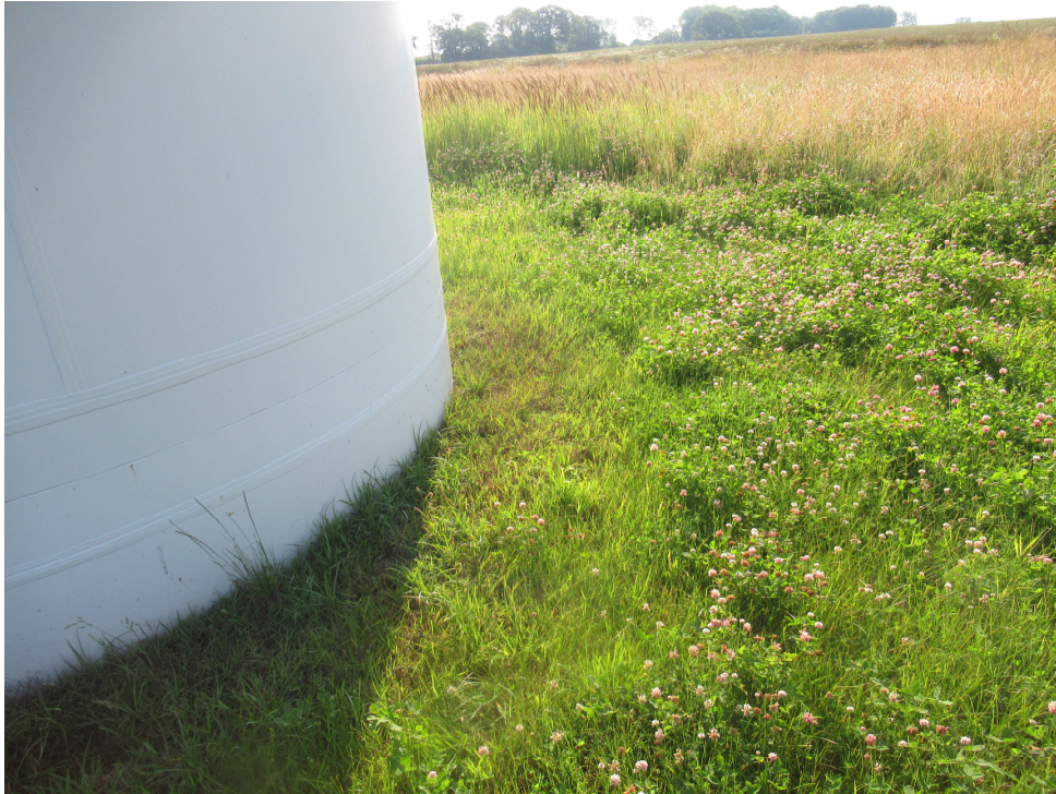
Fot.1 Widoczne niecki wokół wiatraka tworzące zastoiny wody powierzchniowej w obrębie cokołu
