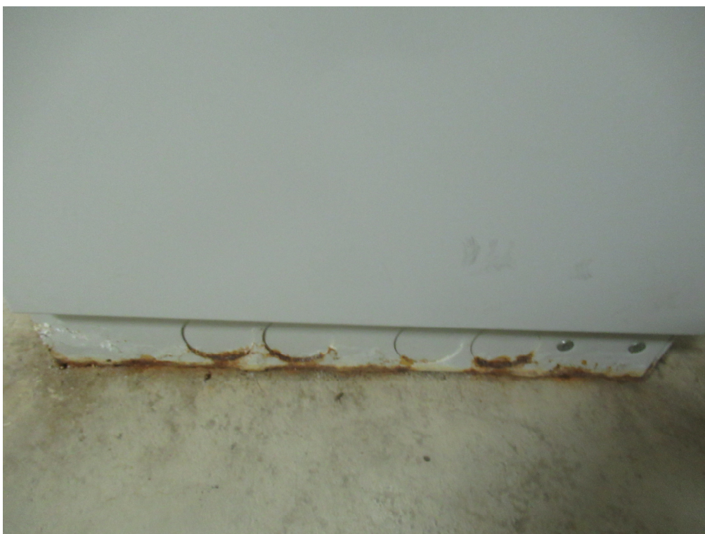
Fot.4 Widoczne skorodowane obudowy urządzeń na styku z posadzką pylonu.
