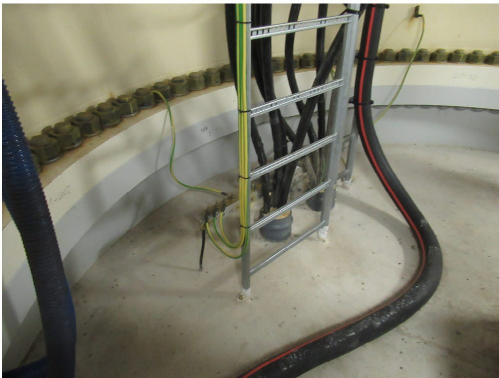
Fot.3 Wnętrze cokołu – miejsce wykonania iniekcji około 30 cm od płaszcza stalowego, promieniście co w rozstawie co 30 cm.
