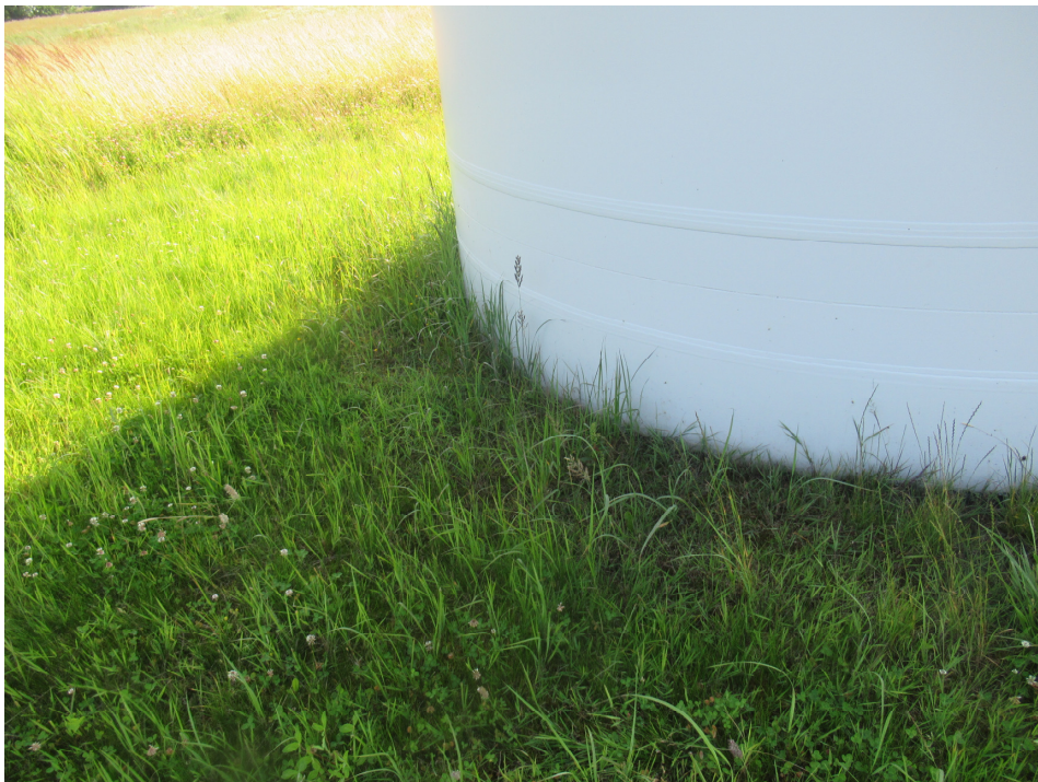
Fot.2 Widoczne niecki wokół wiatraka tworzące zastoiny wody powierzchniowej w obrębie cokołu.
