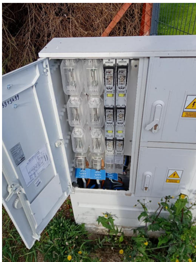
Istniejące złącze nr Z3315499 typu KRSN-P2/2F-NH2/2R-NH00/F
