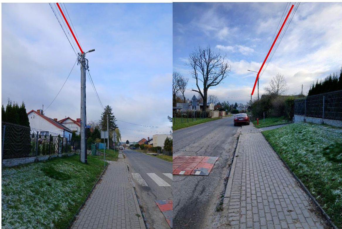
Słup 330171-02/1 / 330171-03/1 - istniejąca linia AL 4x50 do wymiany na AsXSn 4x95 obw. 02, T-5171
