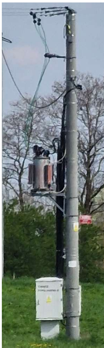
Zdjęcie 1 – Miejsce wpięcia do istn. sieci nn - rozdzielnica nn T340652
