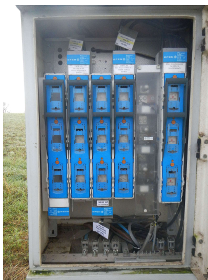
Zdjęcie 1 – Miejsce wpięcia do istn. sieci nn - rozdzielnica nn T340652
