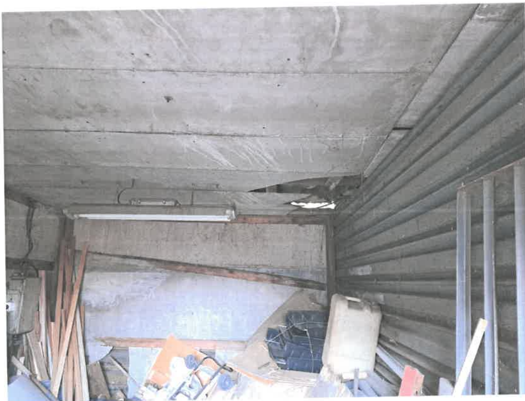
Widok od środka ( podbitka z płyt cementowych)
