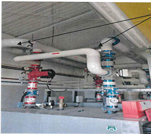
Miejsce włączenia kotła K3 w instalację grzewczą technologiczną
