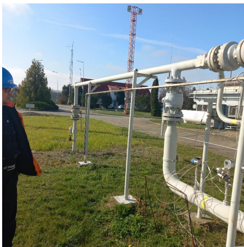
Rurociągi do demontażu
