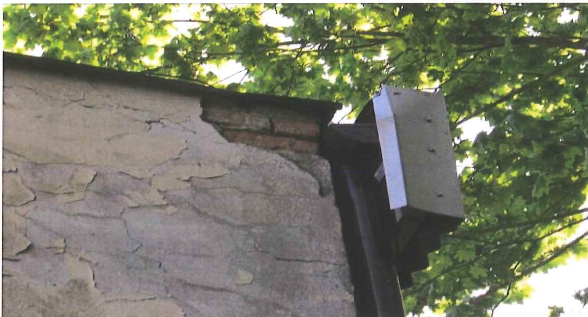
Fot. 5 Widok ubytków tynków na ścianie zewnętrznej sali gimnastycznej.
