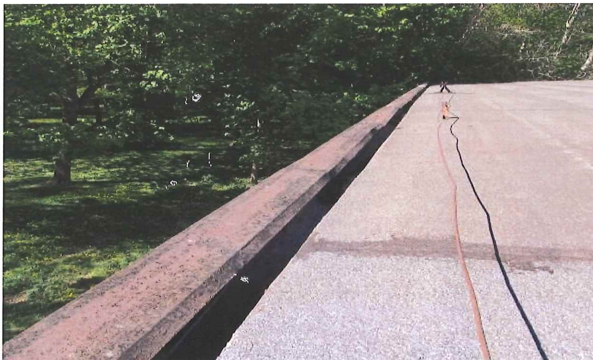
Fot. 18. Skorodowane obróbki blacharskie na dachu Sali gimnastycznej.
