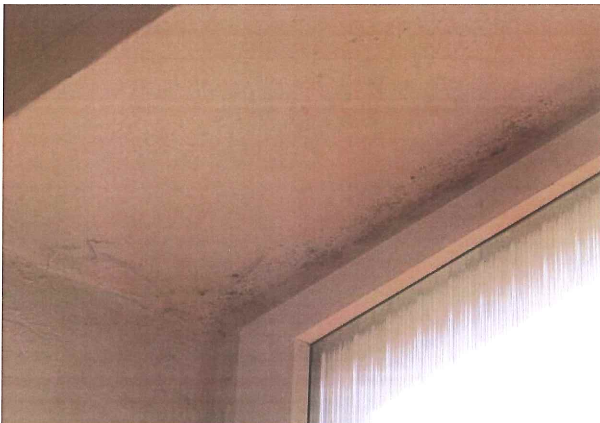
Fot. 23. Miejscowe ogniska pleśni -okna w sali gimnastycznej.
