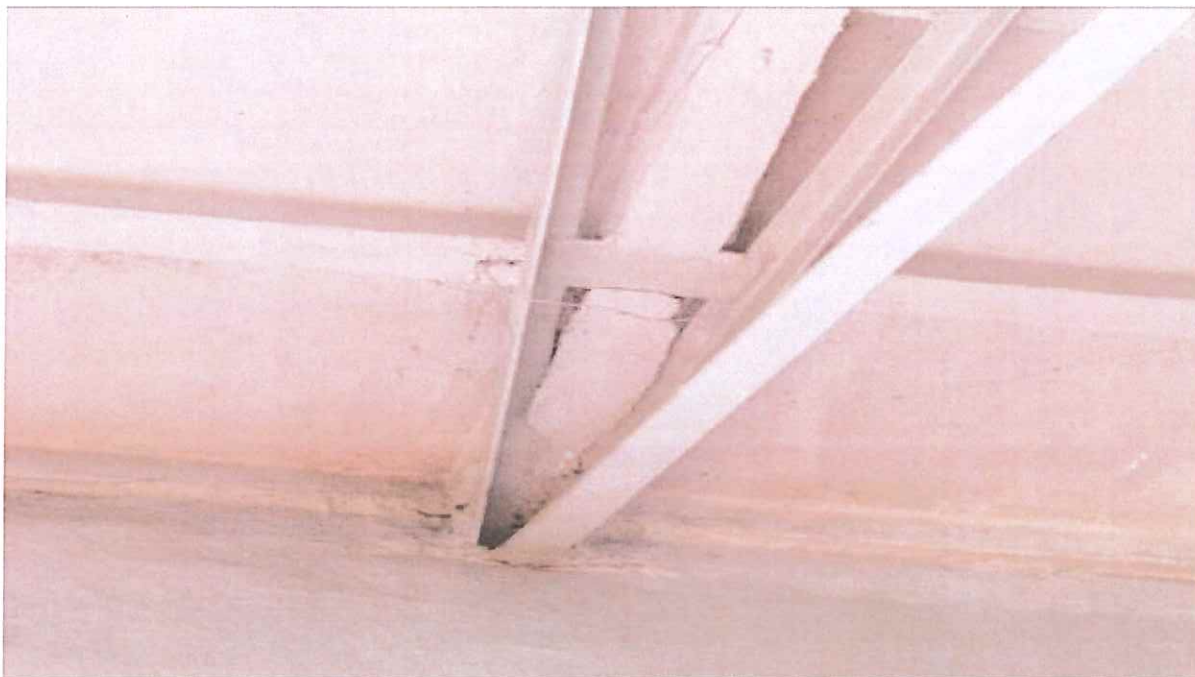
Fot. 13. Widok zawilgoceń sprzed remontu poszycia stropodachu w Sali gimnastycznej.
