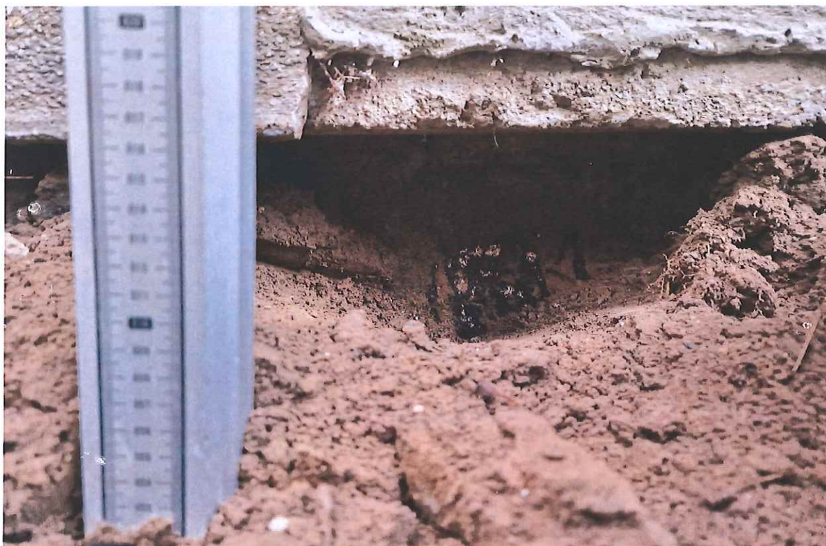
Fot. 7. Widok zaizolowanej ławy fundamentowej.
