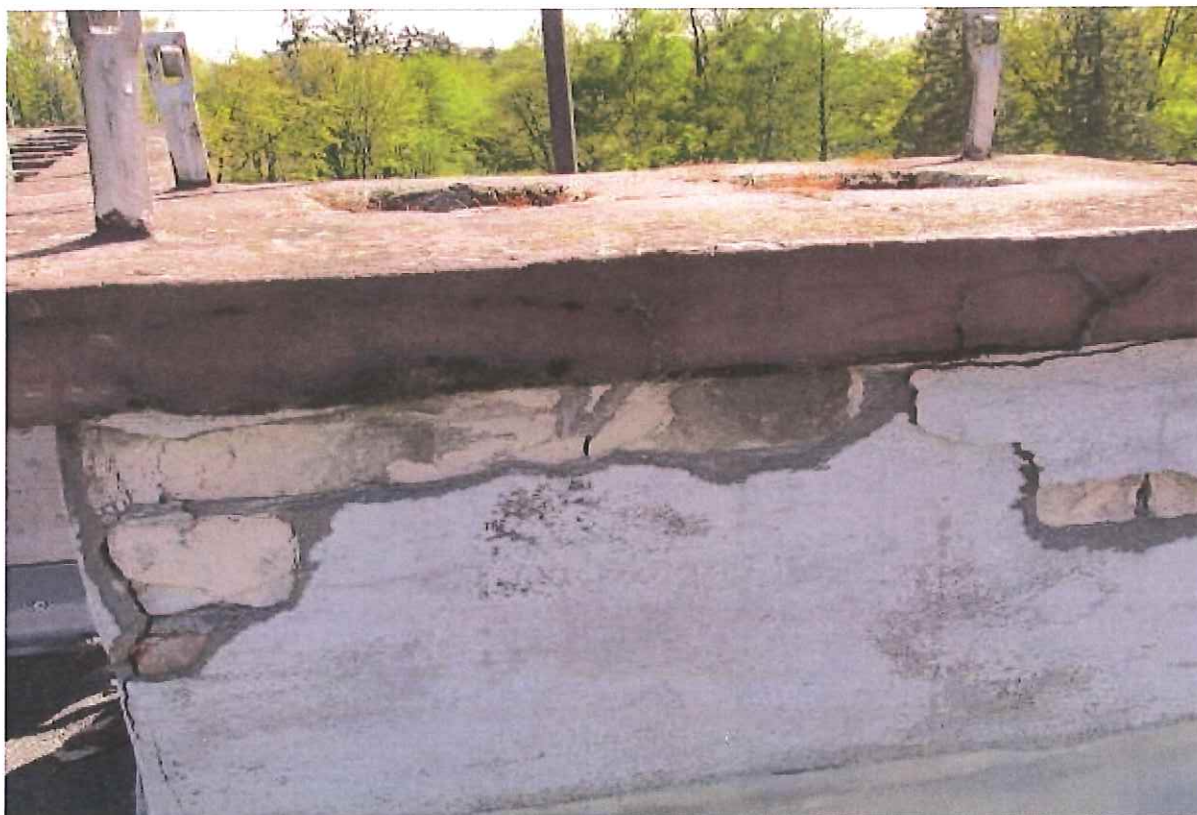
Fot. 19 i 20. Widoczne odspojenie tynku.
