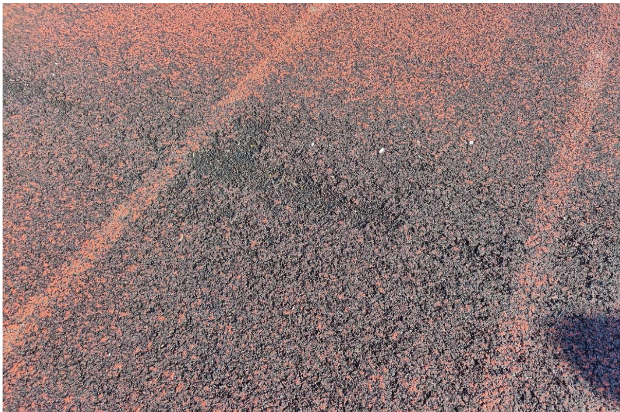
Fot. 9. Zdjęcie terenu – widok ogólny istniejącego obiektu boiska sportowego o nawierzchni poliuretanowej. Widoczne ubytki warstwy wierzchniej nawierzchni boiska.
