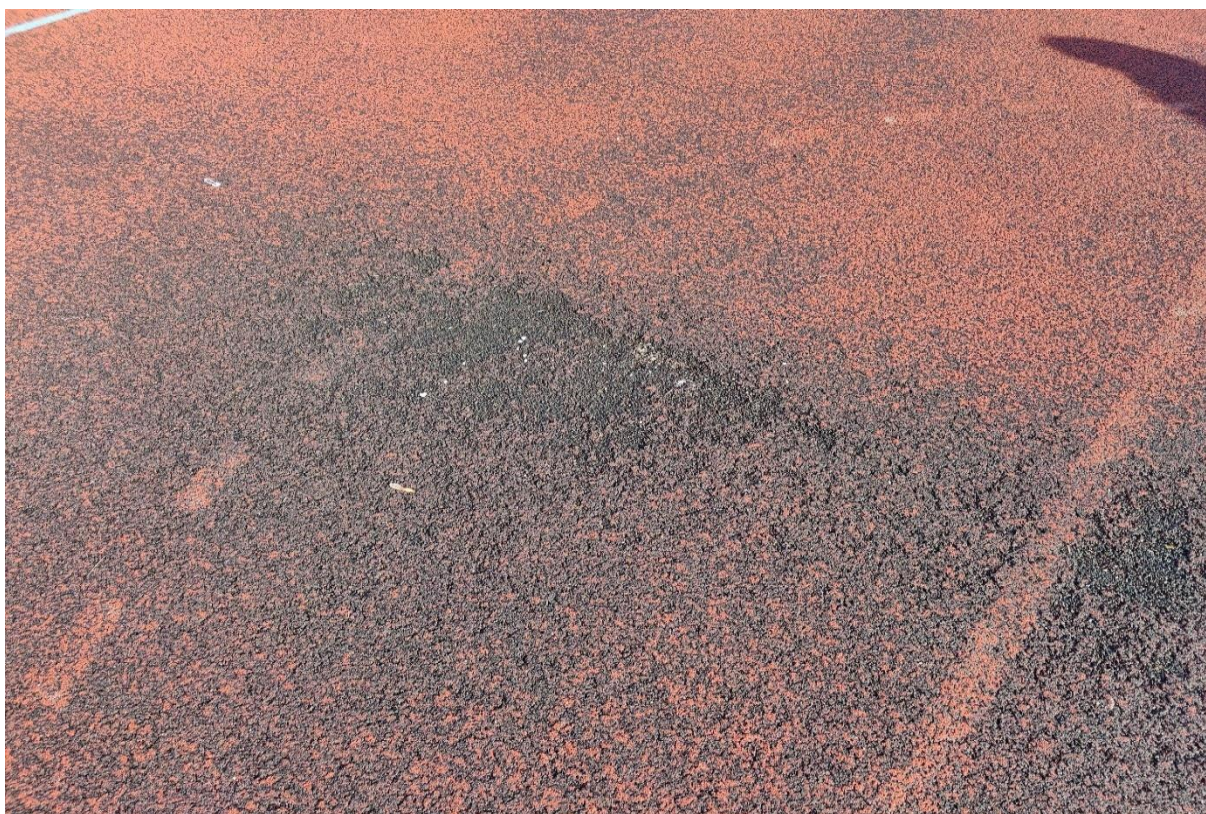
Fot. 8. Zdjęcie terenu – widok ogólny istniejącego obiektu boiska sportowego o nawierzchni poliuretanowej. Widoczne ubytki warstwy wierzchniej nawierzchni boiska.
