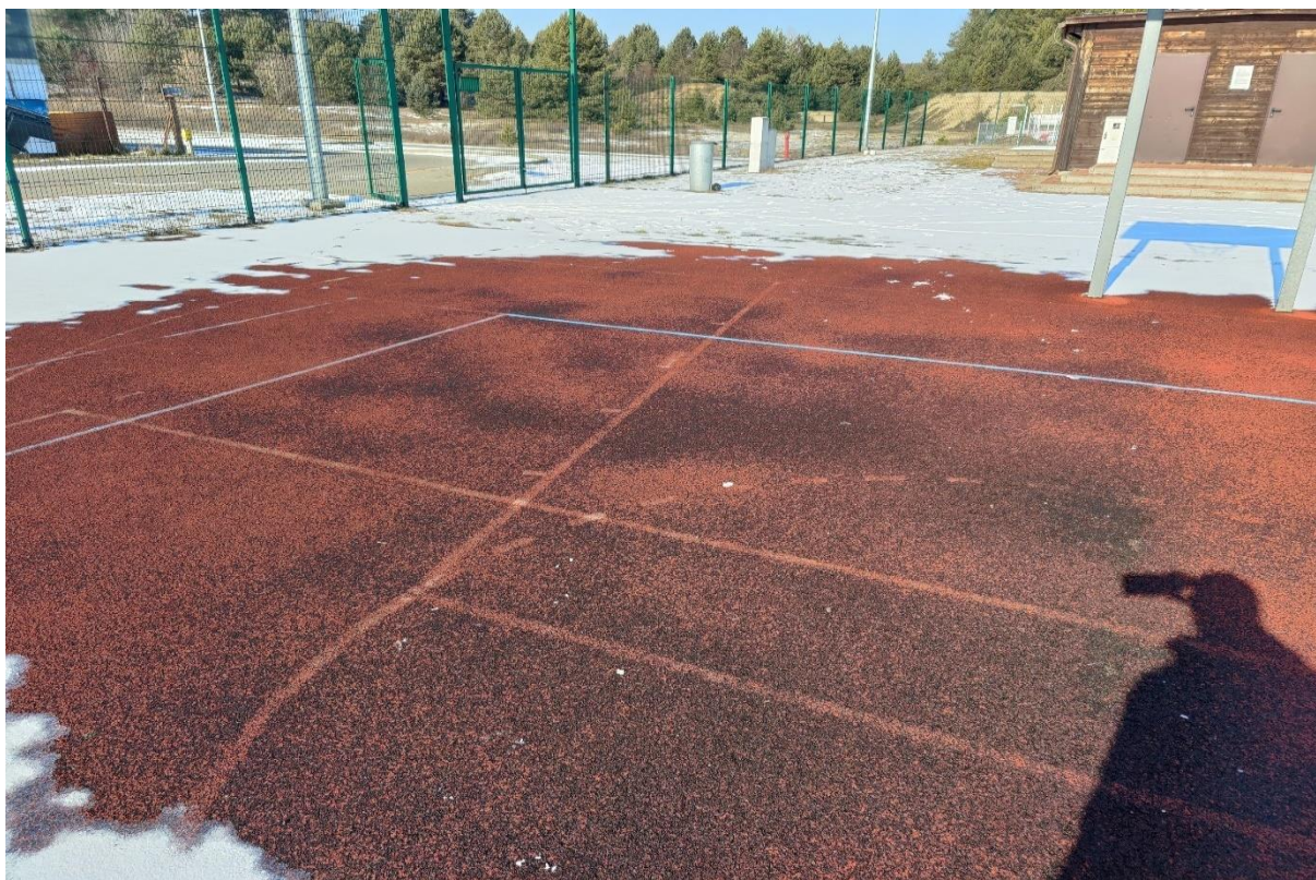
Fot. 7. Zdjęcie terenu – widok ogólny istniejącego obiektu boiska sportowego o nawierzchni poliuretanowej. Widoczne ubytki warstwy wierzchniej nawierzchni boiska.
