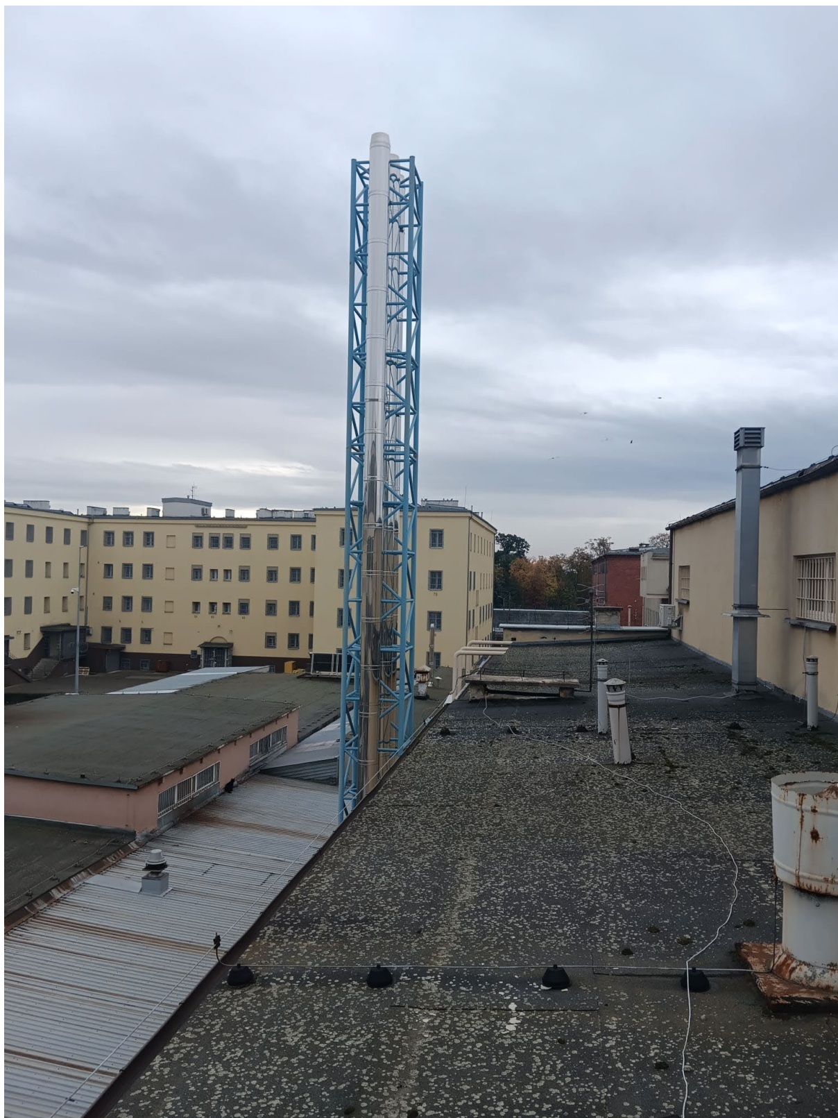
Istniejąca kratowa konstrukcja pod kominy spalinowe
