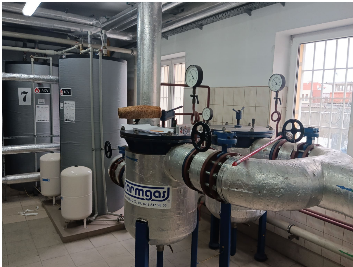
Pomieszczenie kotłowni – istniejące filtry workowe oraz zasobniki wody ciepłej
