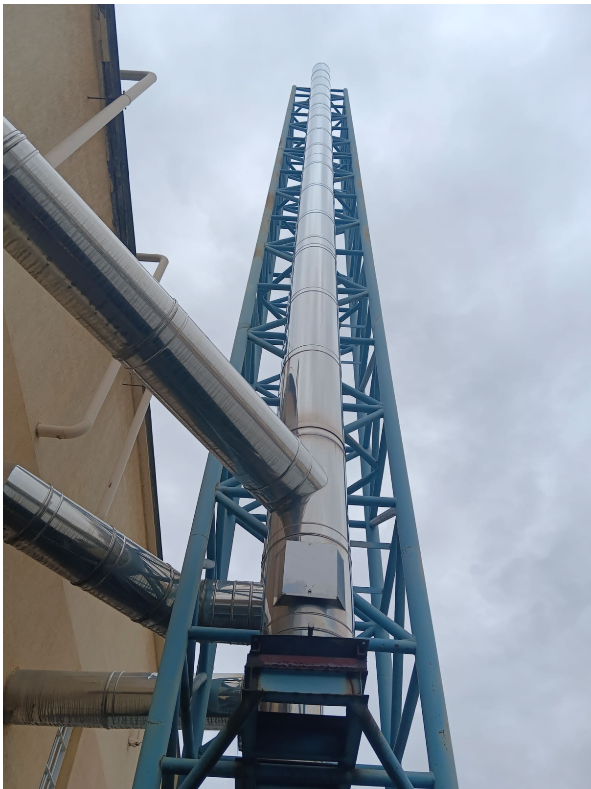
Istniejąca kratowa konstrukcja pod kominy spalinowe
