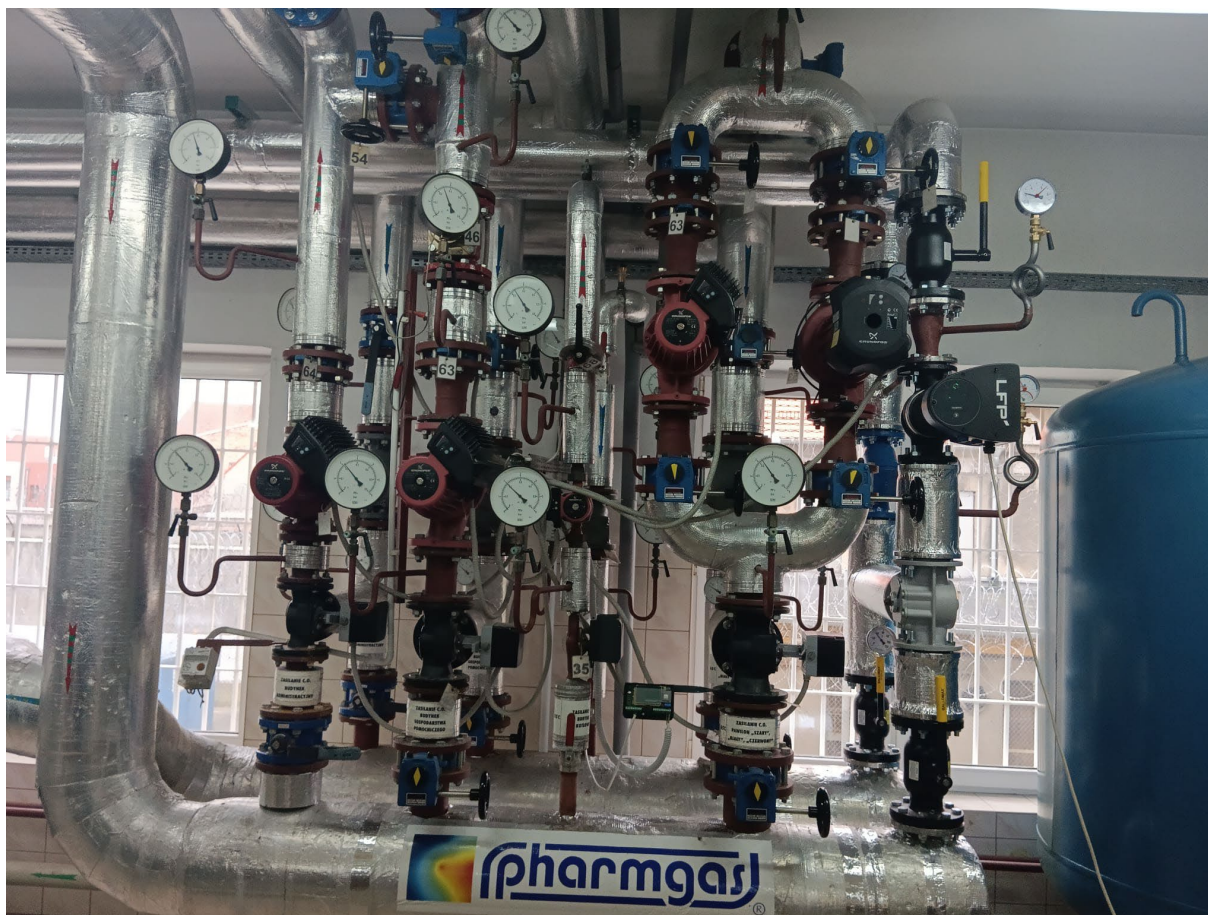
Pomieszczenie kotłowni – istniejące rozdzielacze obiegów grzewczych
