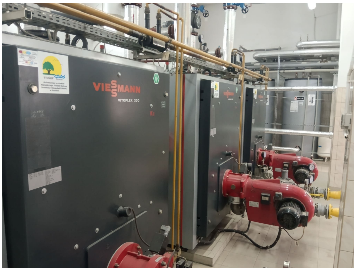
Pomieszczenie kotłowni – istniejące kotły olejowo – gazowe
