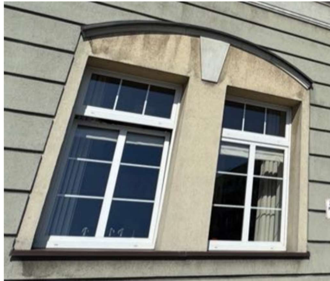
Zdj.5 Obłachowanie nad otworem okiennym Źródło: opracowanie własne
