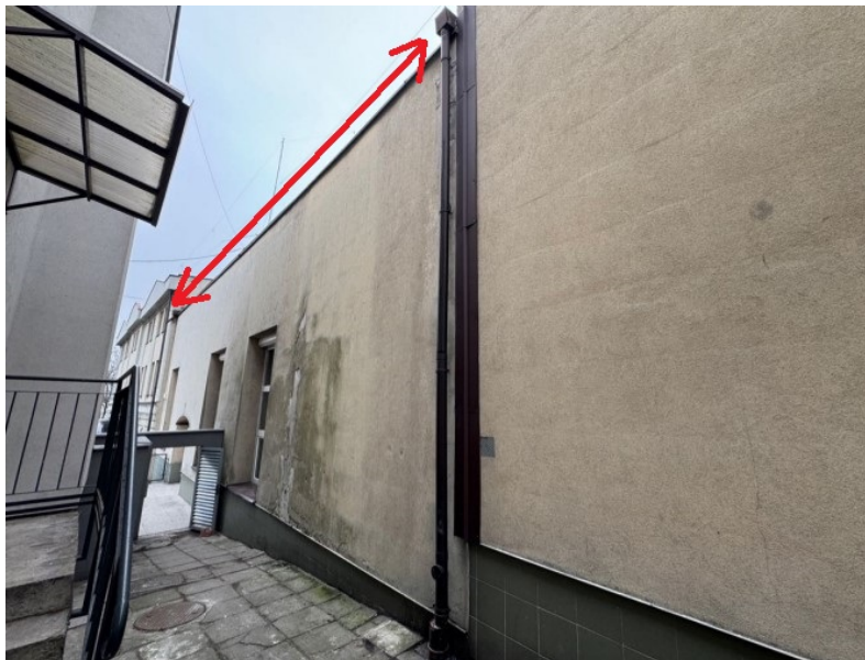
Zdj.6 Obłachowanie na ogniomurze Źródło: opracowanie własne
