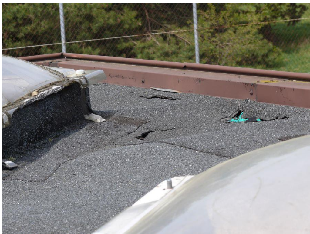
Fot. 4. Fragmenty uszkodzonego pokrycia dachowego kontenera socjalnego
