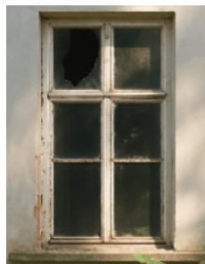
NOWE OKNA WYKONAC NA WZÓR ISTNIEJĄCYCH Z GZYMSEM PODPARAMETOWYM
