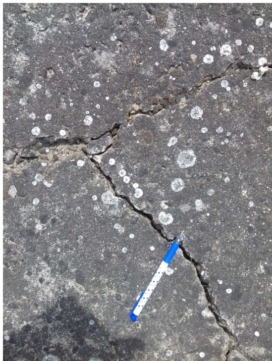
Fot.16 Widok na wylewkę betonową - widoczne znaczne spękania
