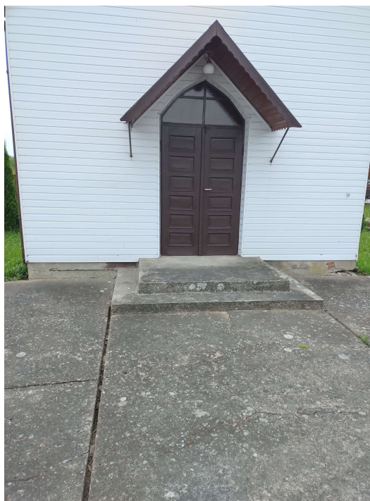
Fot.17 Oddylatowanie wylewki betonowej od schodów wejściowych
