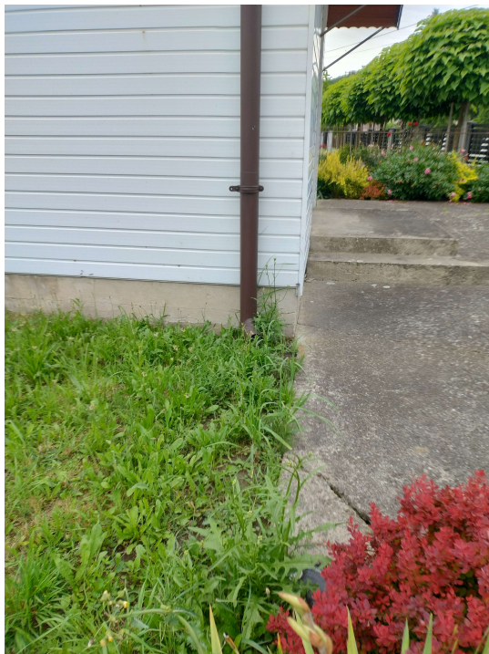
Fot.16 Widok na wylewkę betonową - widoczne znaczne spękania
