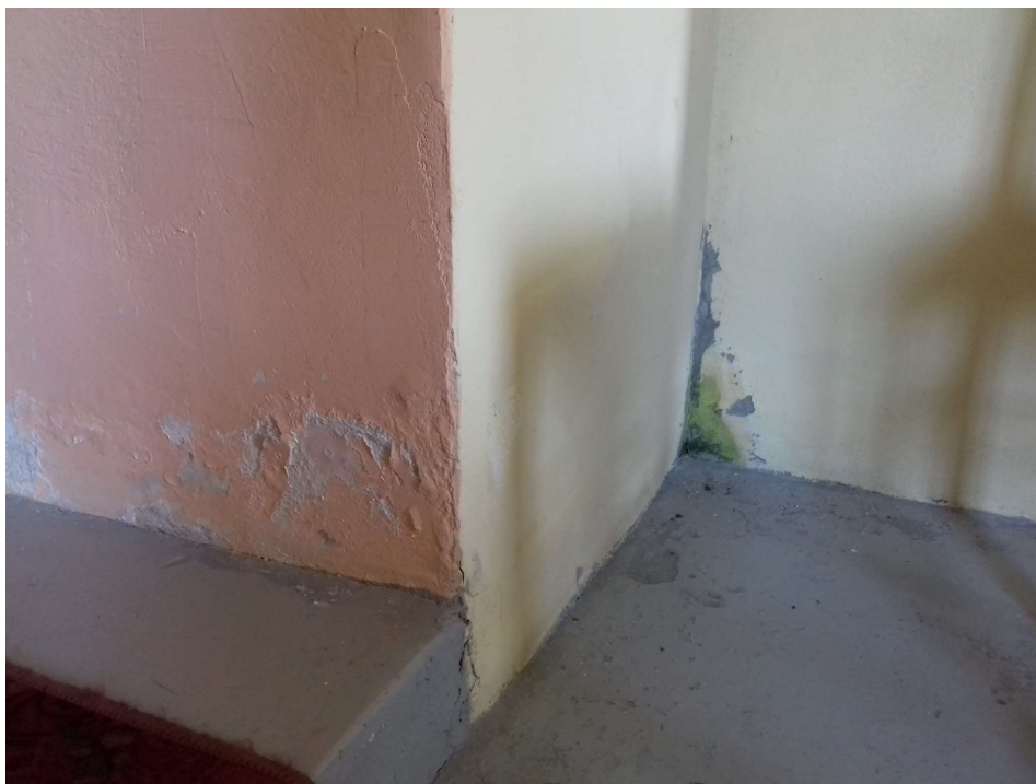
Fot.27. Widok na wnętrze kaplicy – zawilgocenia ścian powodujące odpryski tynku ( przy prezbiterium)
