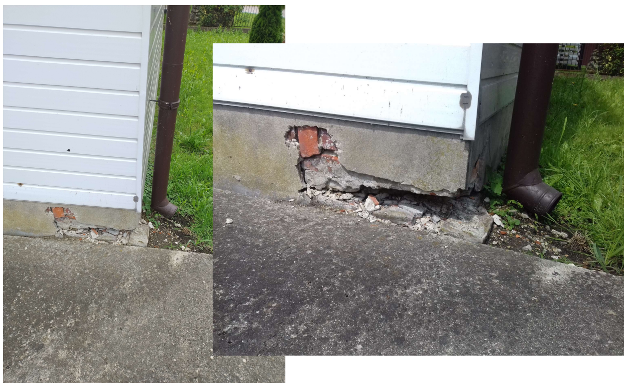
Fot .12,13 Widok na narożnik ściany północno-wschodni - znaczna destrukcja ściany
