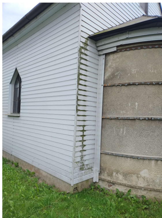
Fot .6,7 Widok na absydę od strony zachodnio-północnej – częściowy brak okładziny – widoczne zawilgocenia ścian
