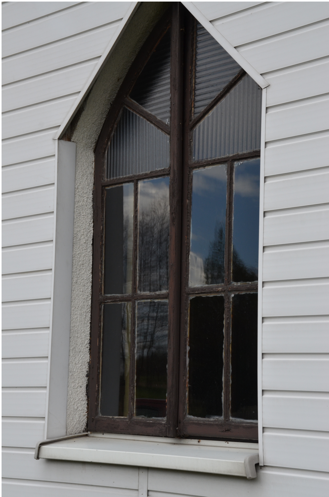
Fot. nr 5. Kaplica Matki Boskiej w Lipowej z 1930 r. Widoczne na fotografii: zdeformowany wykrój otworu okiennego w skutek wprowadzonej okładziny, zdegradowana powłoka malarska na powierzchni drewna, ubytki i degradacja kitu okiennego.
