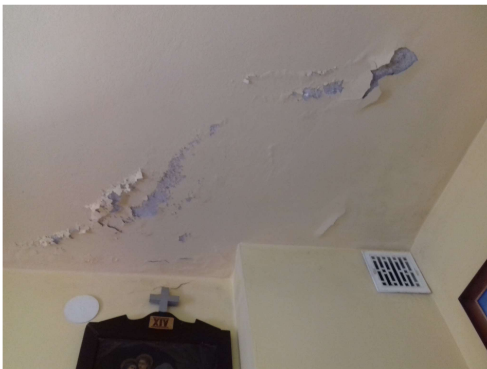
Fot.28. Widok na wnętrze kaplicy – zawilgocenia sufitu powodujące odpryski tynku ( przy kominie)
