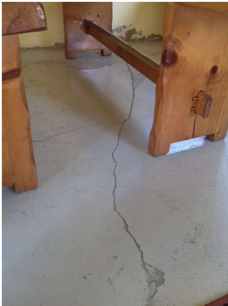
Fot.25,26. Widok na wnętrze kaplicy – spękania i zarysowania betonowej posadzki , zawilgocenia ścian powodujące odpryski tynku
