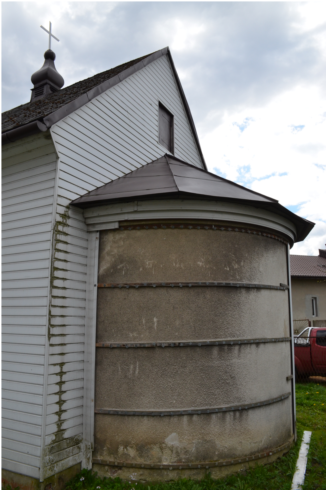
Fot. nr 3. Kaplica Matki Boskiej w Lipowej z 1930 r. Widoczne na fotografii: tynk historyczny nakrapiany widoczny pod okładziną elewacyjną.
