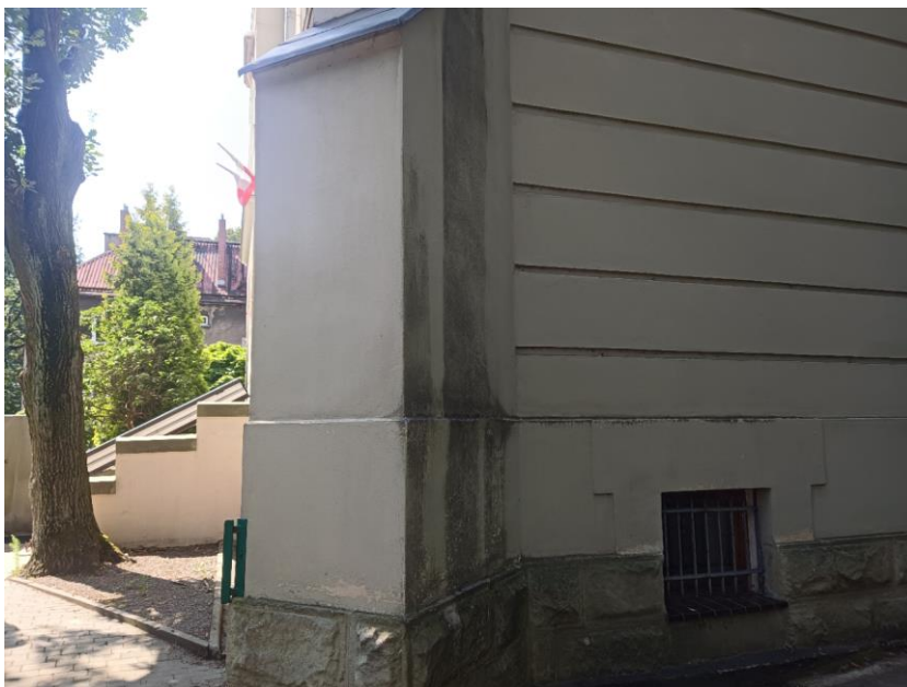
Zdj. 2. Degradacja przypory w północno-wschodnim narożu budynku z widoczną postępującą degradacją biologiczną w północnej części elementu
