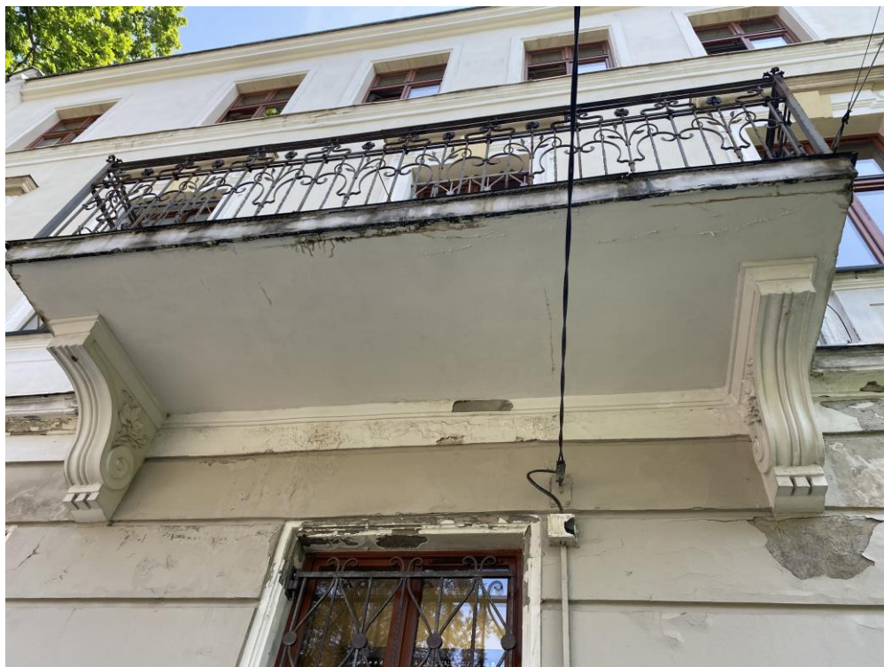
Zdj. 3. Degradacja płyty balkonowej, gzymsu i powierzchni elewacji przylegającej do balkonu na ścianie zachodniej
