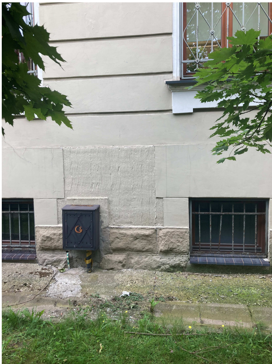
Fotografia 12 – Widok cokołu od strony elewacji bocznej południowej (tynk ryflowany)
