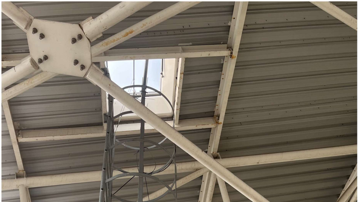
Fot.2 – korozja powierzchniowa elementów stalowych
