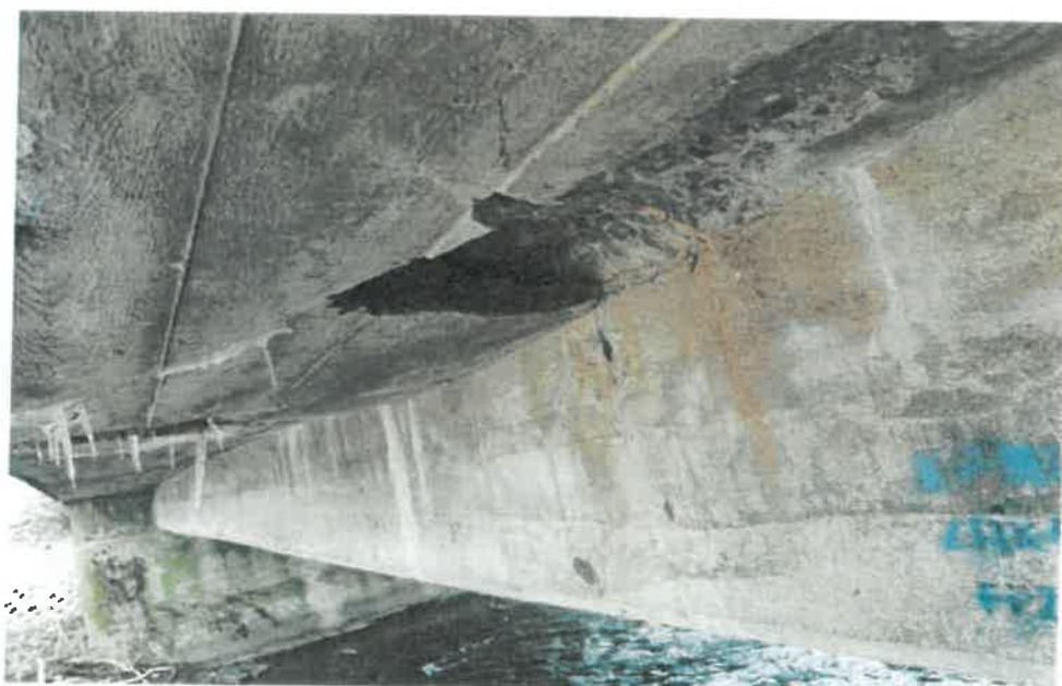
Fot. Nr 6 Zaczny ubytek od uderzenia drzewa
