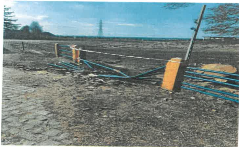
Fot.Nr 5 Zniszczona balustrada na dojeździe
