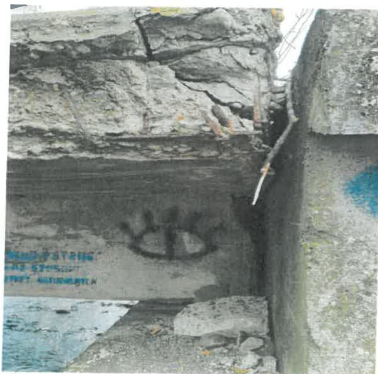
Fot Nr4 Korozyjne uszkodzenie od strony dopływu i Centrum
