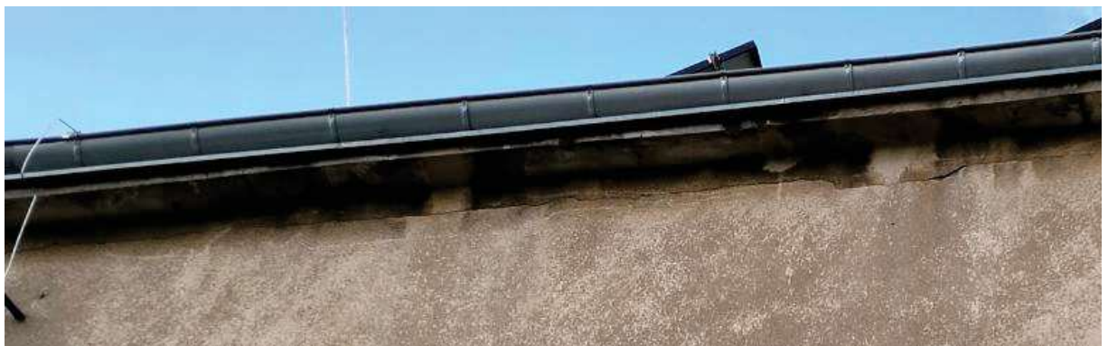
Rysa wzdłuż stropodachu
