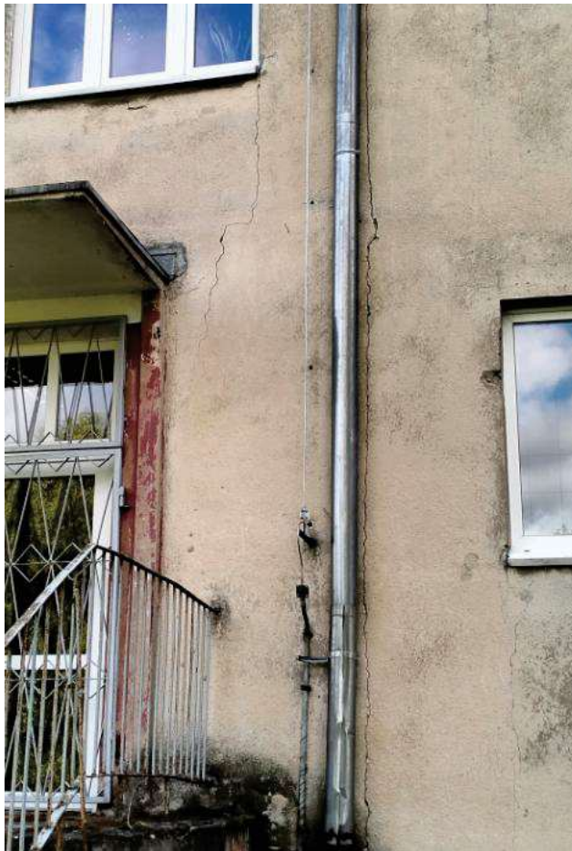
Pionowa ryza wzdłuż długiej połaci ściany
