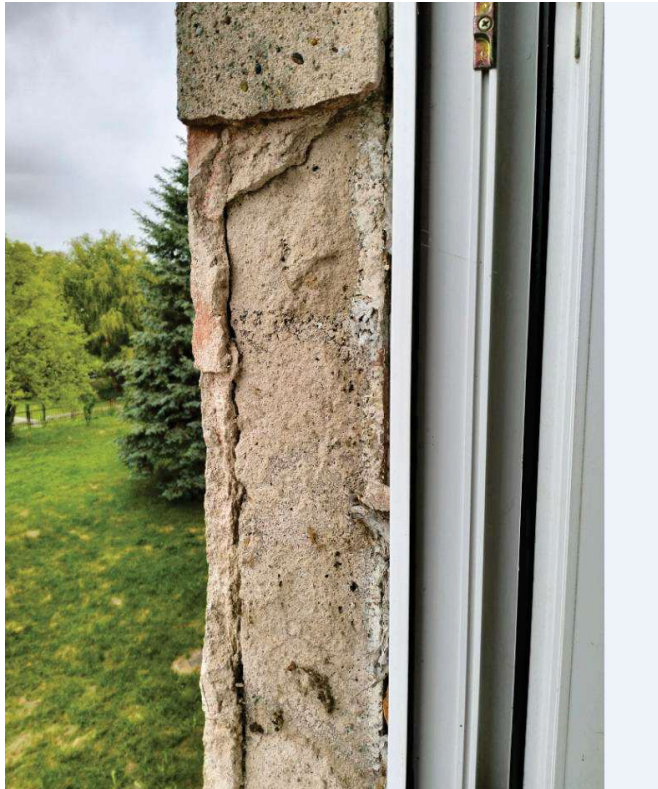
Rozwarstwienie tynku na filarach okiennych, tynk odpada po lekkim dotknięciu
