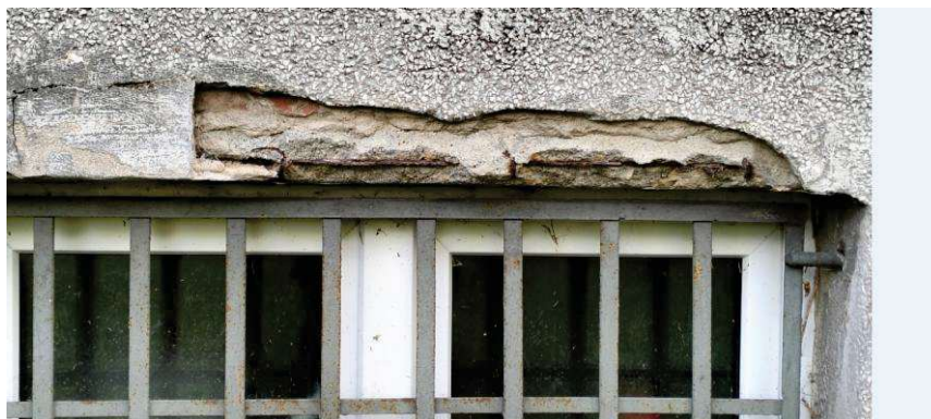
Odsłonięte zbrojenie nadproża żelbetowego
