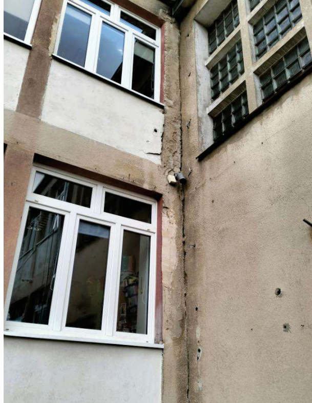
Pionowa ryza wzdłuż narożnika budynku
