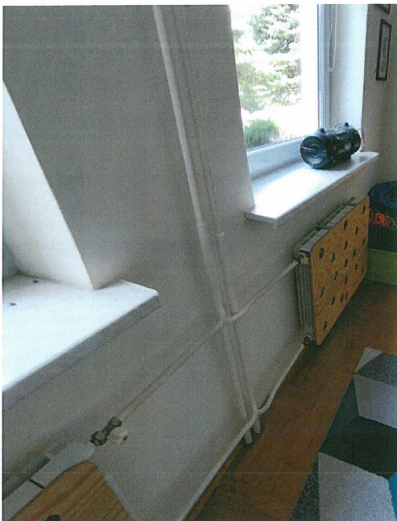
Na zdjęciu widoczne zawory grzejnikowe zamontowane na istniejących grzejnikach w budynku – brak głowic termostatycznych.
