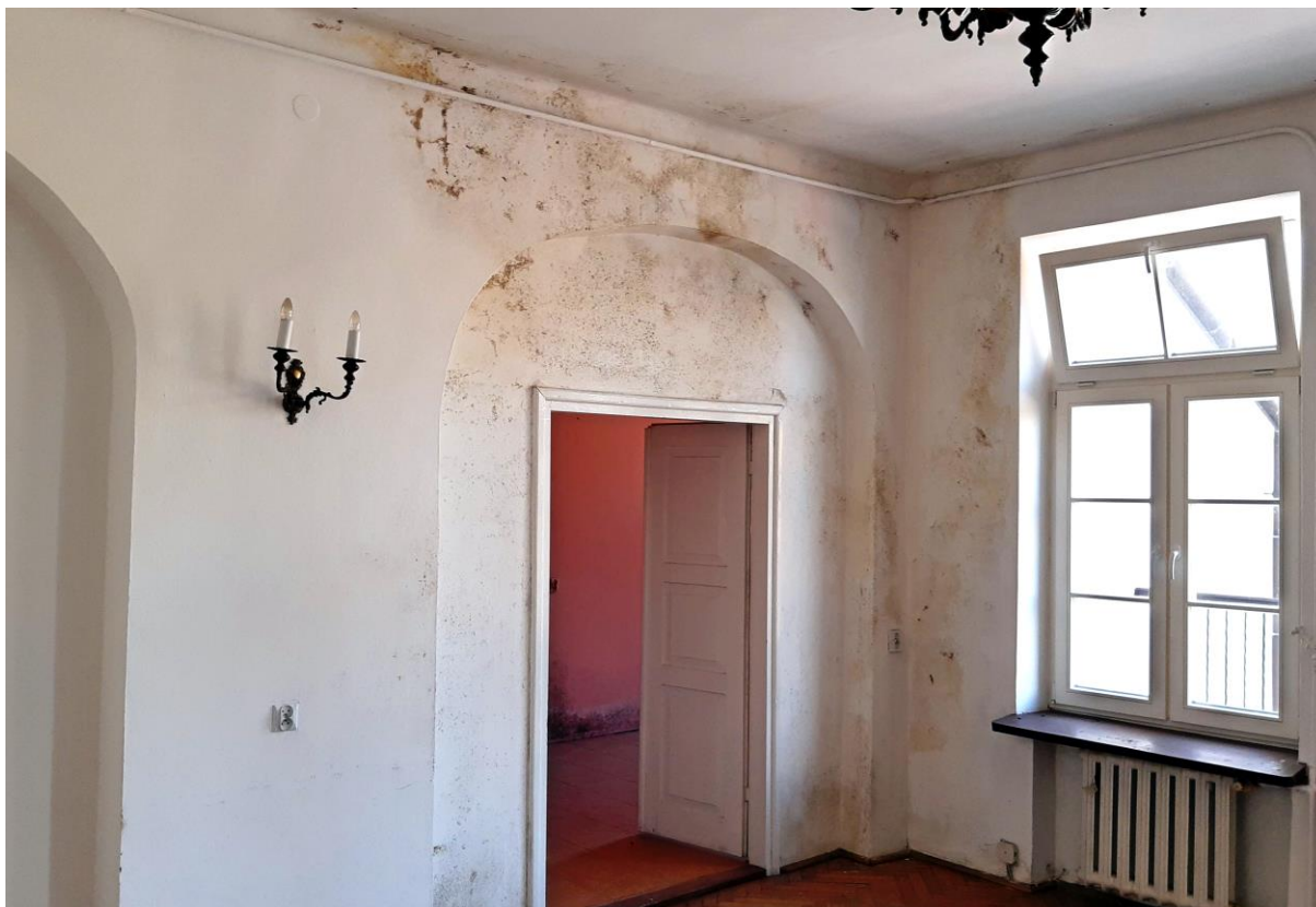
Sala na piętrze. Widoczne skutki nieszczelności pokrycia w północno-zachodniej części pomieszczenia.
