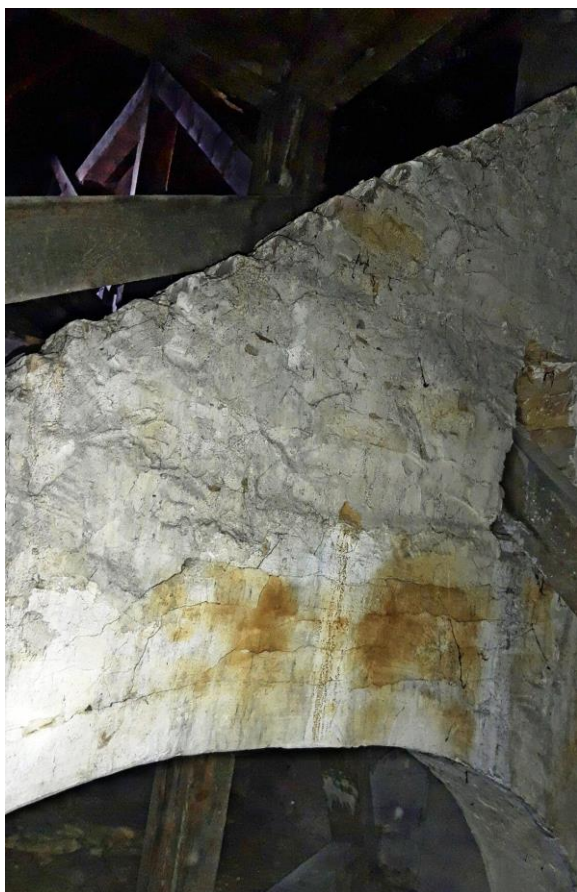
Po lewej jeden ze słupów w dolnej części poddasza. Po prawej zastrzał w górnej części poddasza. Widoczne pionowe pęknięcia wzdłuż włókien drewna.
