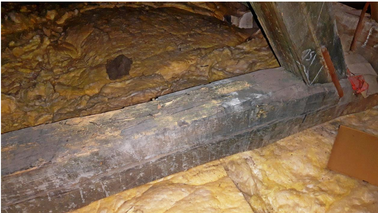
Jedna z belek więzara. Widoczne miejsce porażenia biologicznego.
