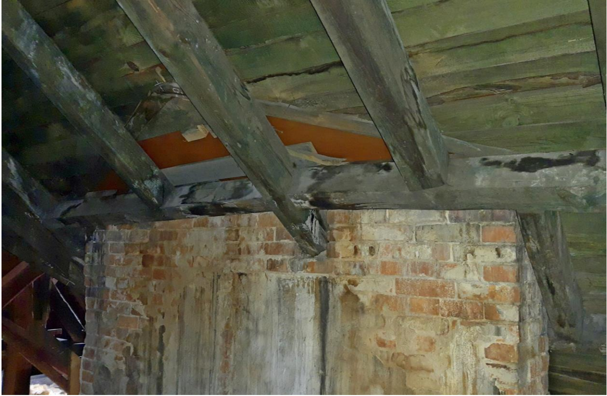
Zacieki i zawilgocenia na krokwiach przy kominie w części wschodniej poddasza.
