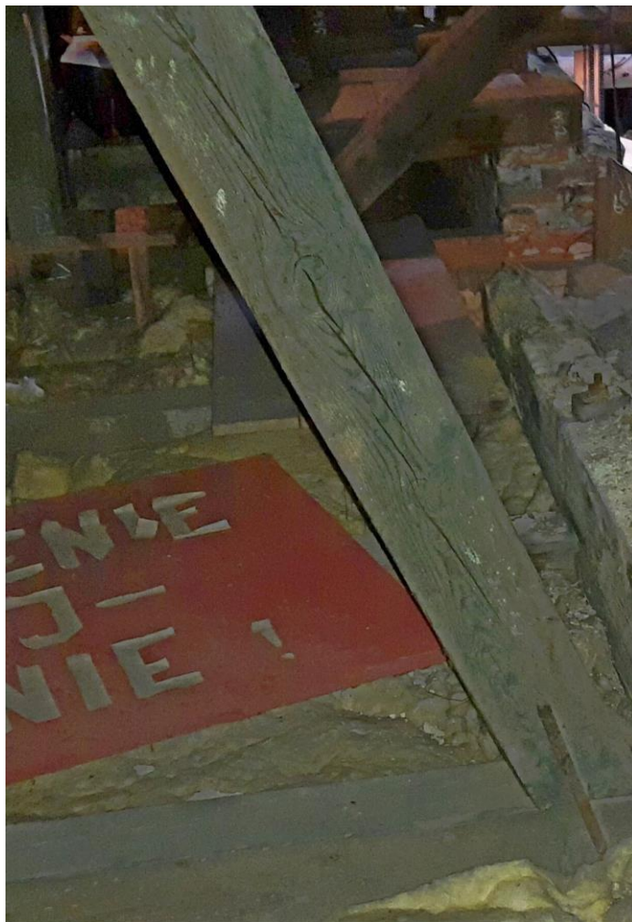
Po lewej jeden ze słupów w dolnej części poddasza. Po prawej zastrzał w górnej części poddasza. Widoczne pionowe pęknięcia wzdłuż włókien drewna.
