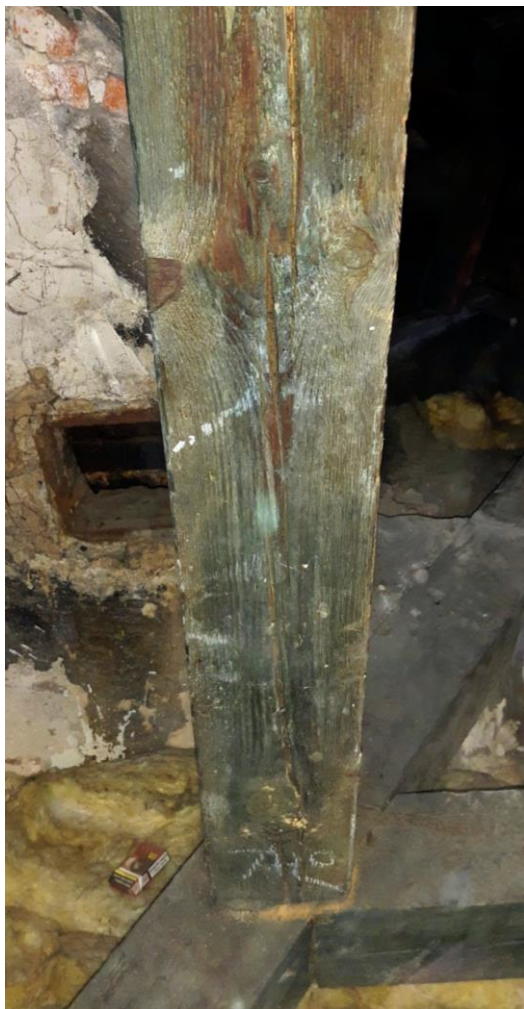
Po lewej jeden ze słupów w dolnej części poddasza. Po prawej zastrzał w górnej części poddasza. Widoczne pionowe pęknięcia wzdłuż włókien drewna.
