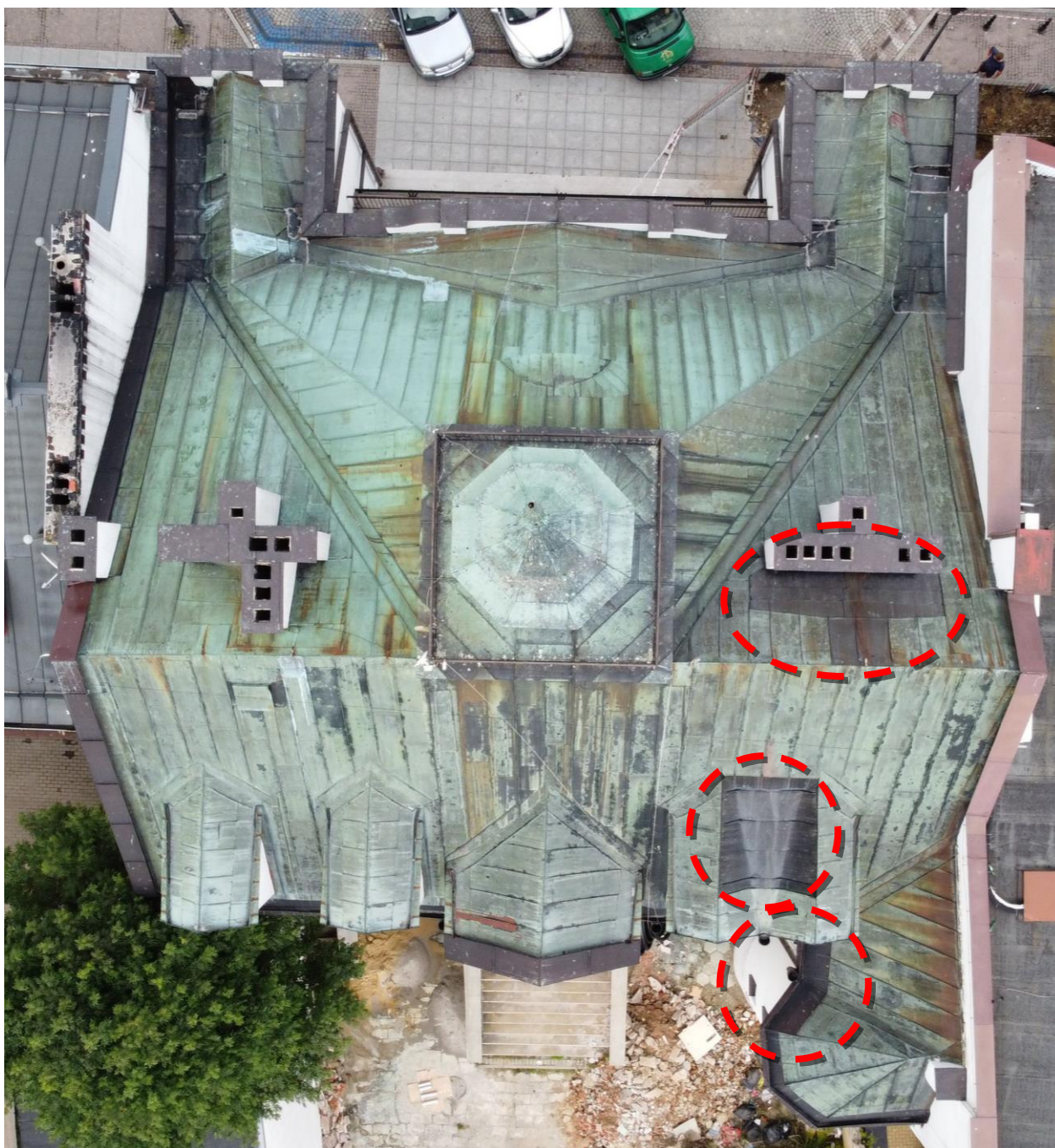
Widok ogólny dachu. Widoczne doraźnie wymienione fragmenty połaci przy kominie, nad lukarnami oraz przy okapie.
