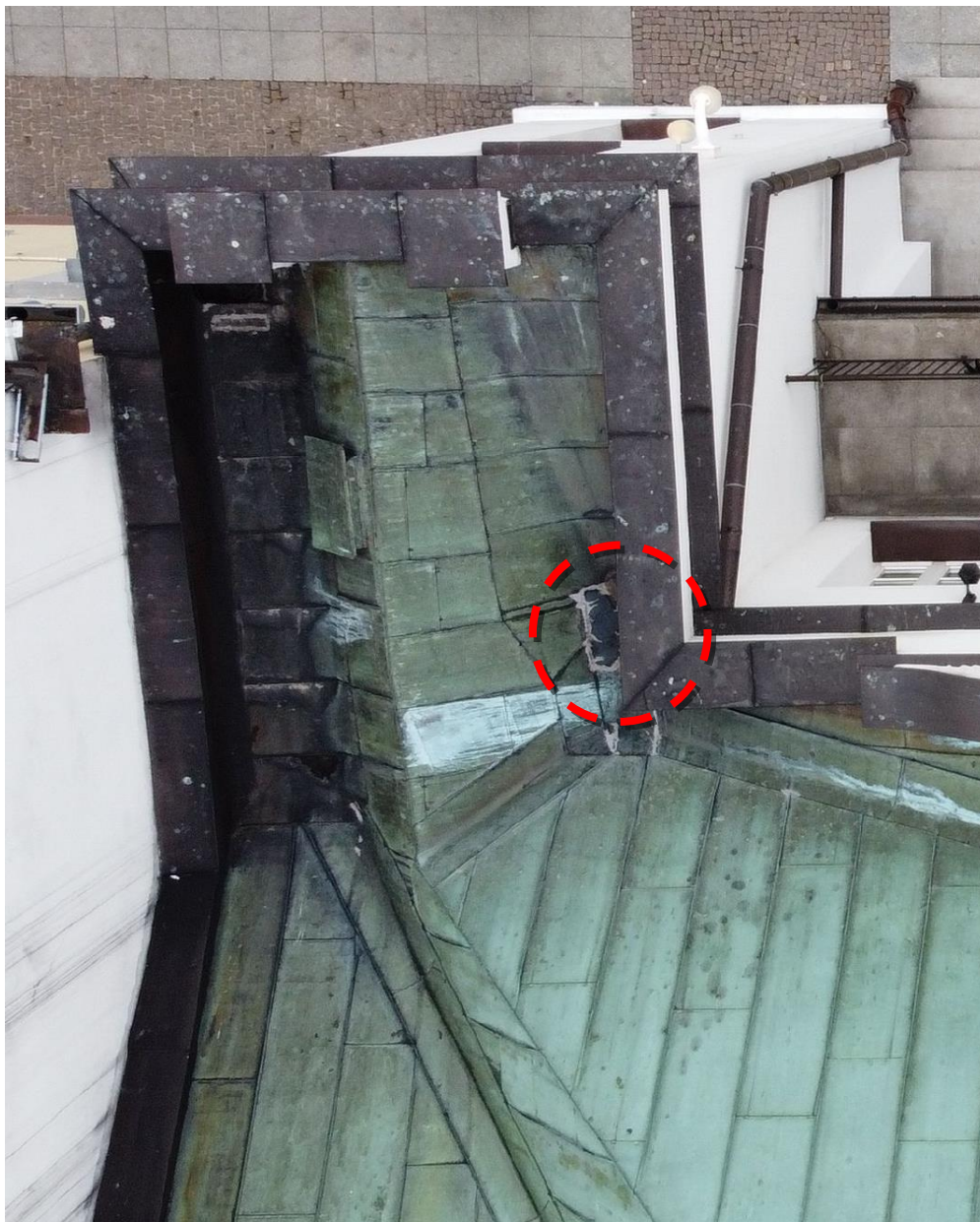
Północno-zachodnia część dachu. Widoczne uszczelniania silikonem wpustu rury spustowej.
