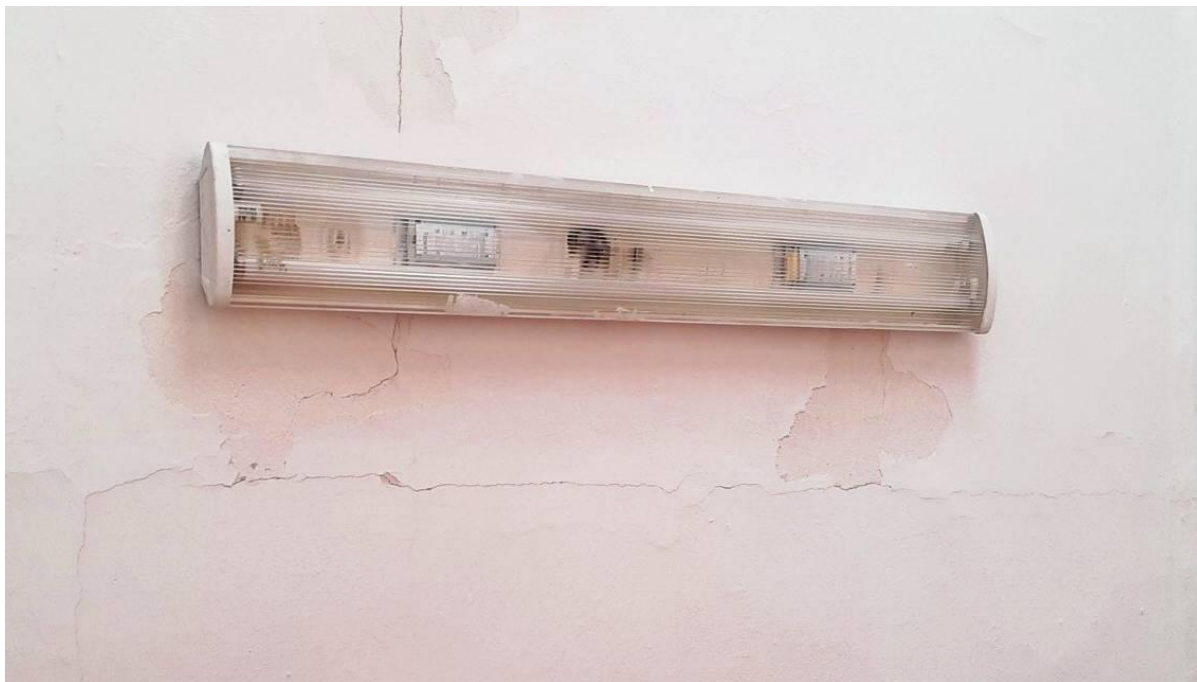
Strop na jednym z pomieszczeń na piętrze. Widoczne rysy włoskowate.
