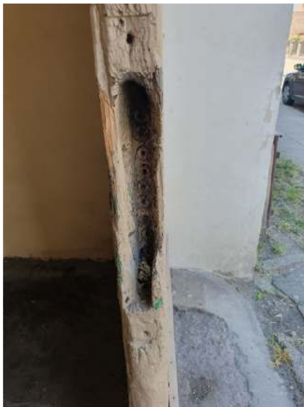
Zdjęcie 18 – Wrota bramne – otwór po zamku- widoczne uszkodzenia struktury drewna ramy wrót.
