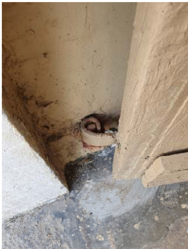
Zdjęcie 19 – Wrota bramne – szczegół zawiasa dolnego w uszkodzonym skrzydle.
