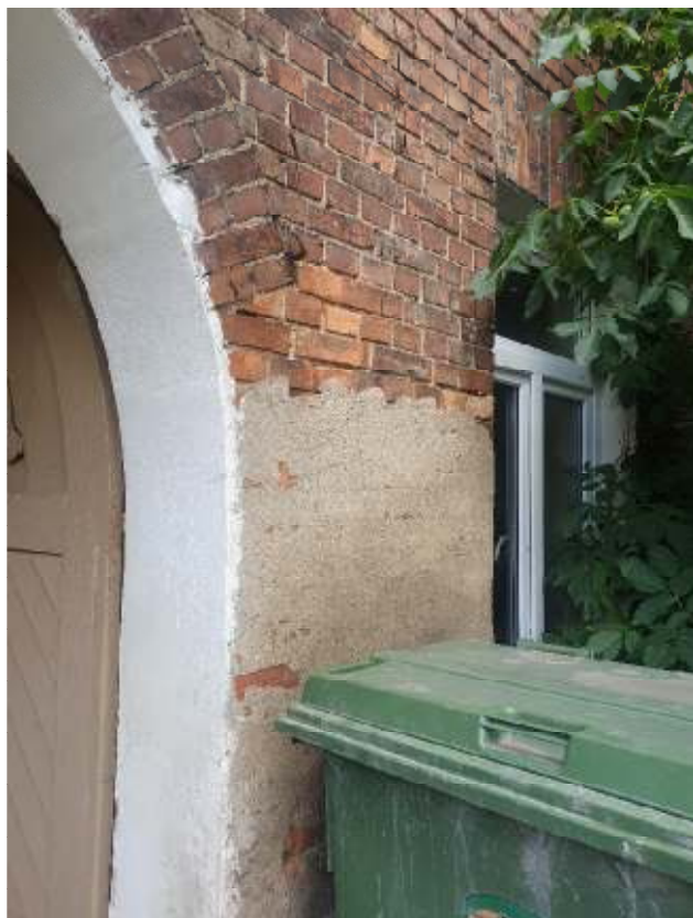
Zdjęcie 11 – Fragment ściany przy przejeździe bramnym od strony podwórka pokryty tynkiem – do usunięcia.
