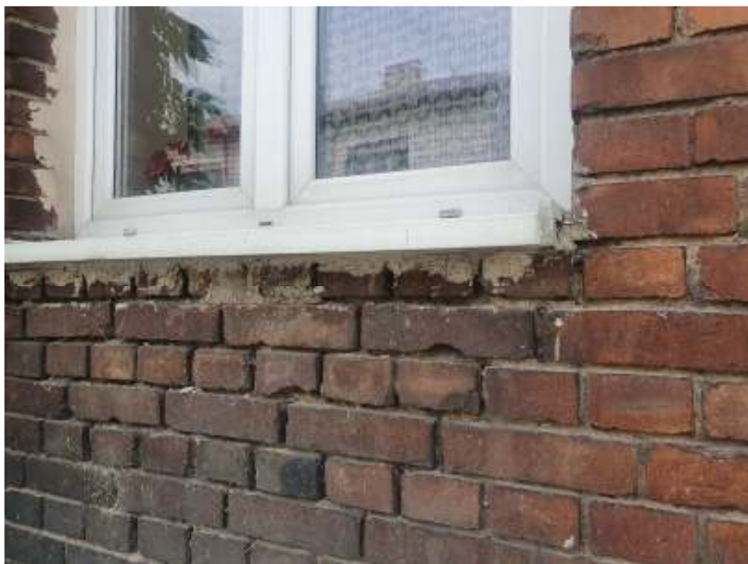
Zdjęcie 7 - Zabrudzenia z zaprawy widoczne pod parapetami i na ościeżach.
