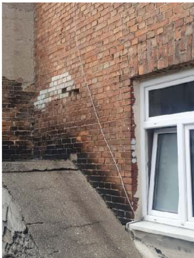
Zdjęcie 10 – Silne zabrudzenie elewacji nad schodami do piwnicy, powyżej ubytki w murze i cegły pokryte farbą.
