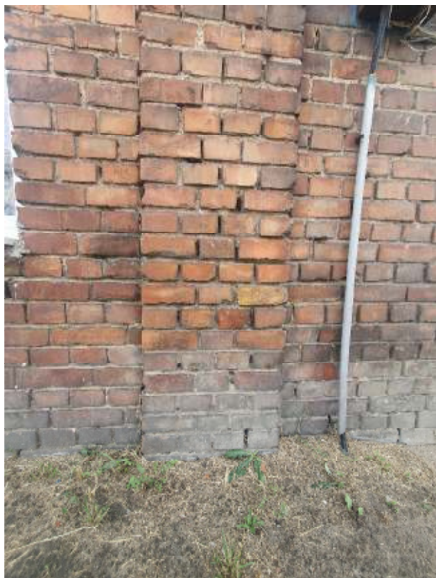
Zdjęcie 5 - detal pilastra – widoczne zabrudzenie w dolnej części i ubytki fugowania.
