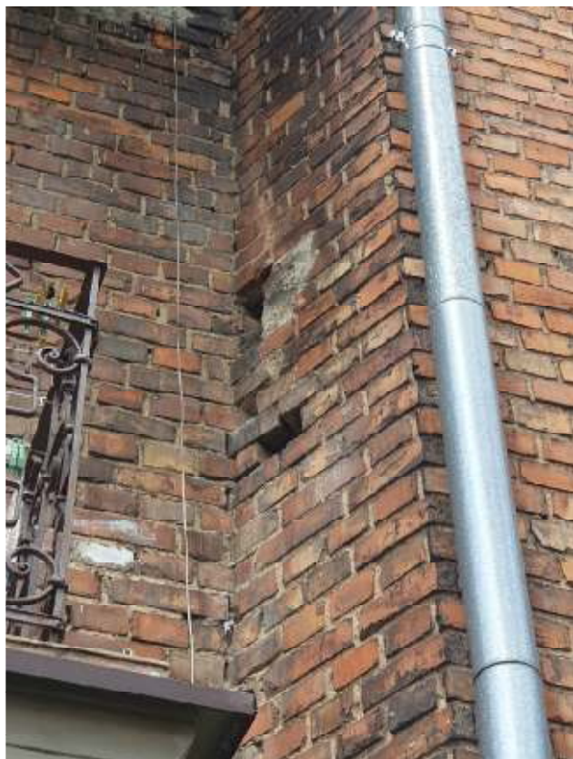
Zdjęcie 9 – Ubytki cegieł na ścianie wykuszu schodowego od strony podwórka.
