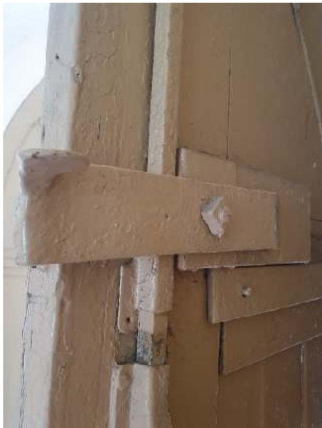
Zdjęcie 21 – Wrota bramne – szczegół mechanizmu zamykającego.
