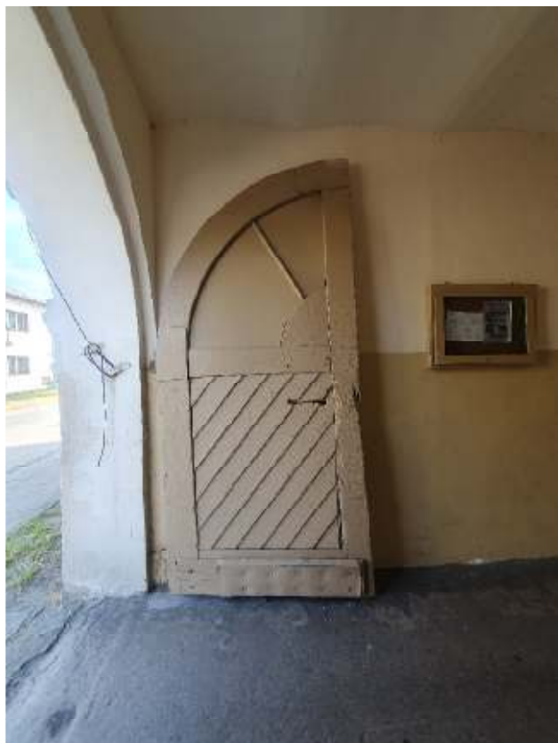
Zdjęcie 13 – Wrota bramne – skrzydło z uszkodzonym zawiasem – nie daje się zamknąć w bezpieczny sposób.
