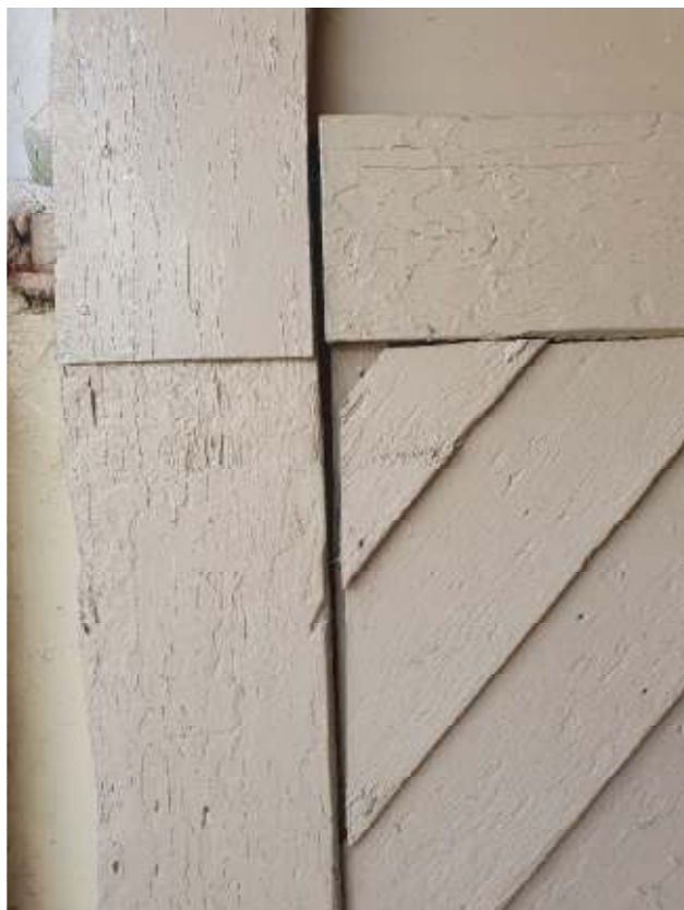
Zdjęcie 15 – Wrota bramne –widoczne „rozejście” się konstrukcji.
