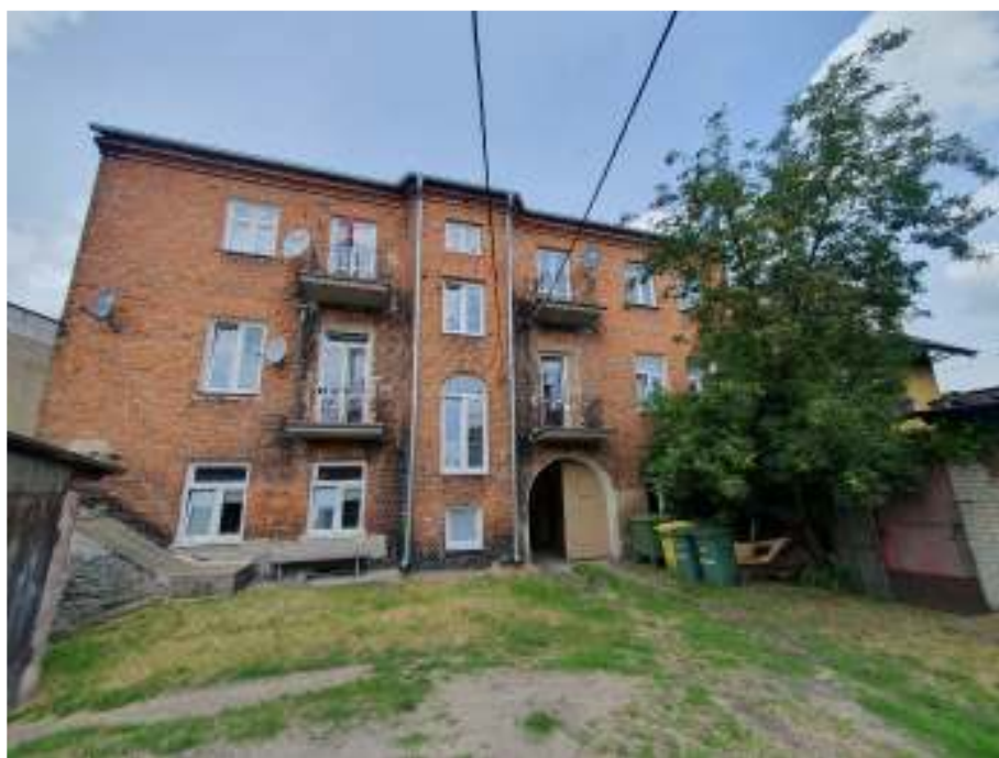
Zdjęcie 2 - Elewacja południowa – widok ogólny – widoczne zniszczenia muru w skutek ściekającej wody opadowej
