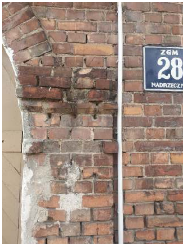
Zdjęcie 6 – Braki cegieł w ozdobnym gzymsie obramowania otworu bramnego - widoczne ubytki i wykwyty wilgoci i soli, fragmenty obcego tynku.
