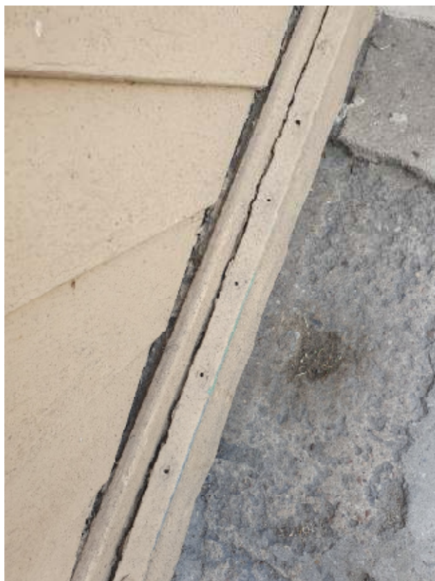
Zdjęcie 16 – Wrota bramne – szczegół dolnego ramiaka i odboju obitego blachą.
