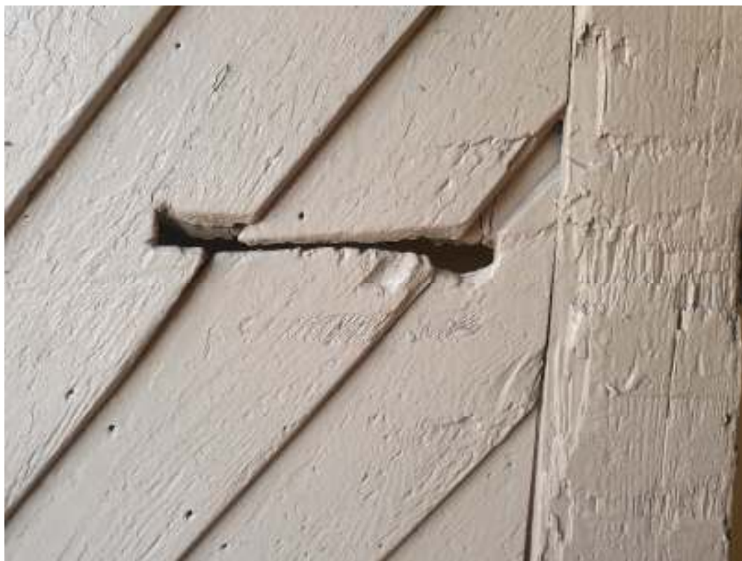
Zdjęcie 14 – Wrota bramne – uszkodzone wypełnienie ramy, widoczne zniszczenie ramiaka.
