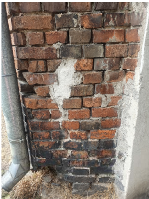
Zdjęcie 8 – Widoczne uszkodzenia muru wykusza schodowego od strony podwórka – uszkodzone, wykruszone cegły, widoczne zabrudzenia i korozja cegły, ubytki fugowania na prawie całej powierzchni.
