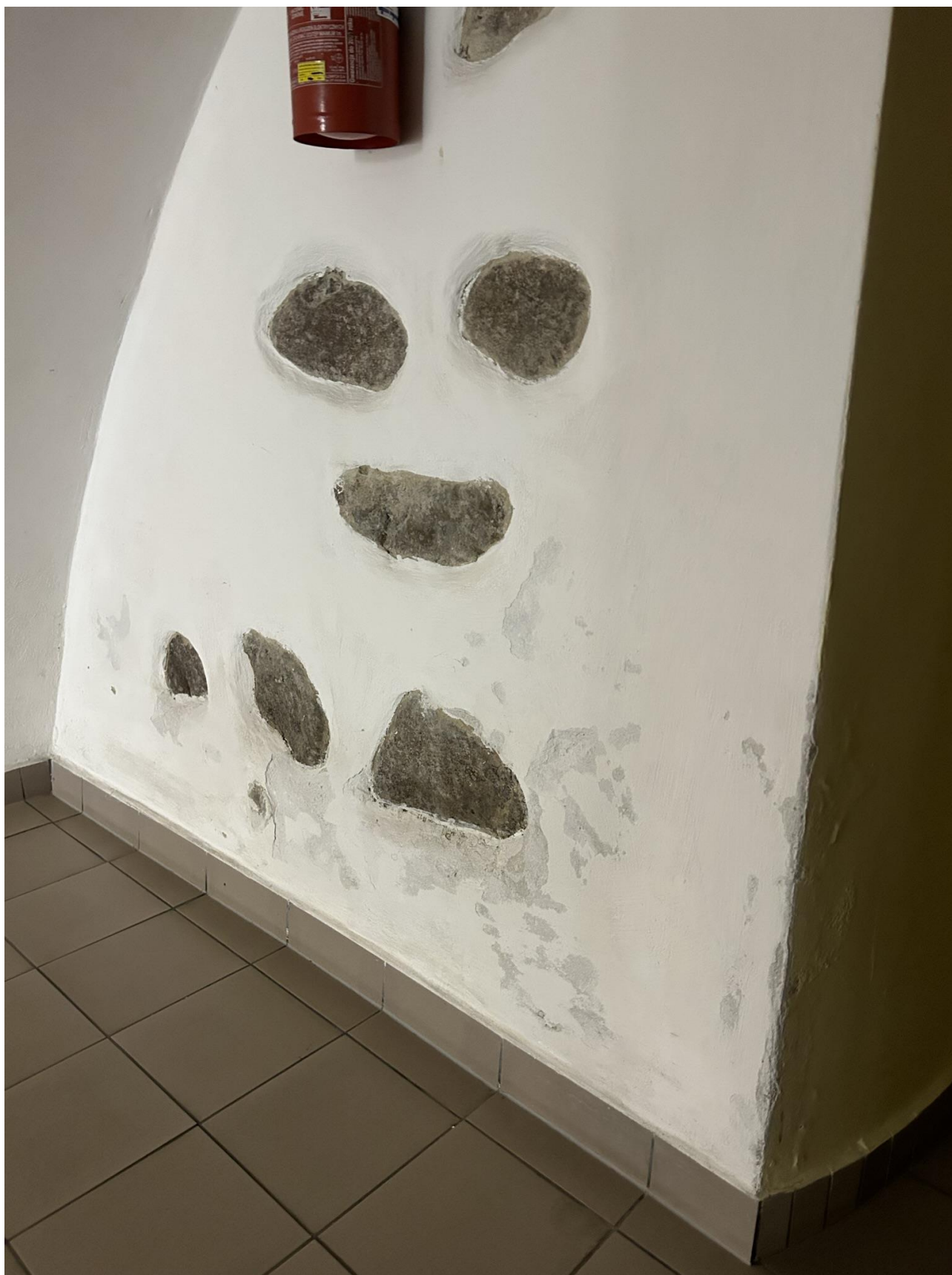
Widoczne zniszczenia spowodowane wilgocią podciąganą kapilarnie
