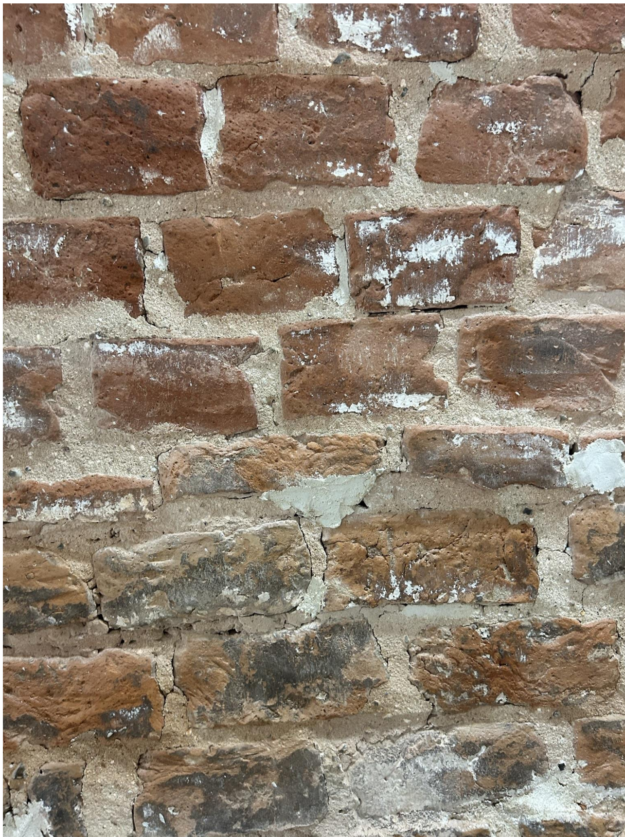
Ściana ceglana- widoczne z zabrudzenia powierzchni cegieł zaprawą i farbą
