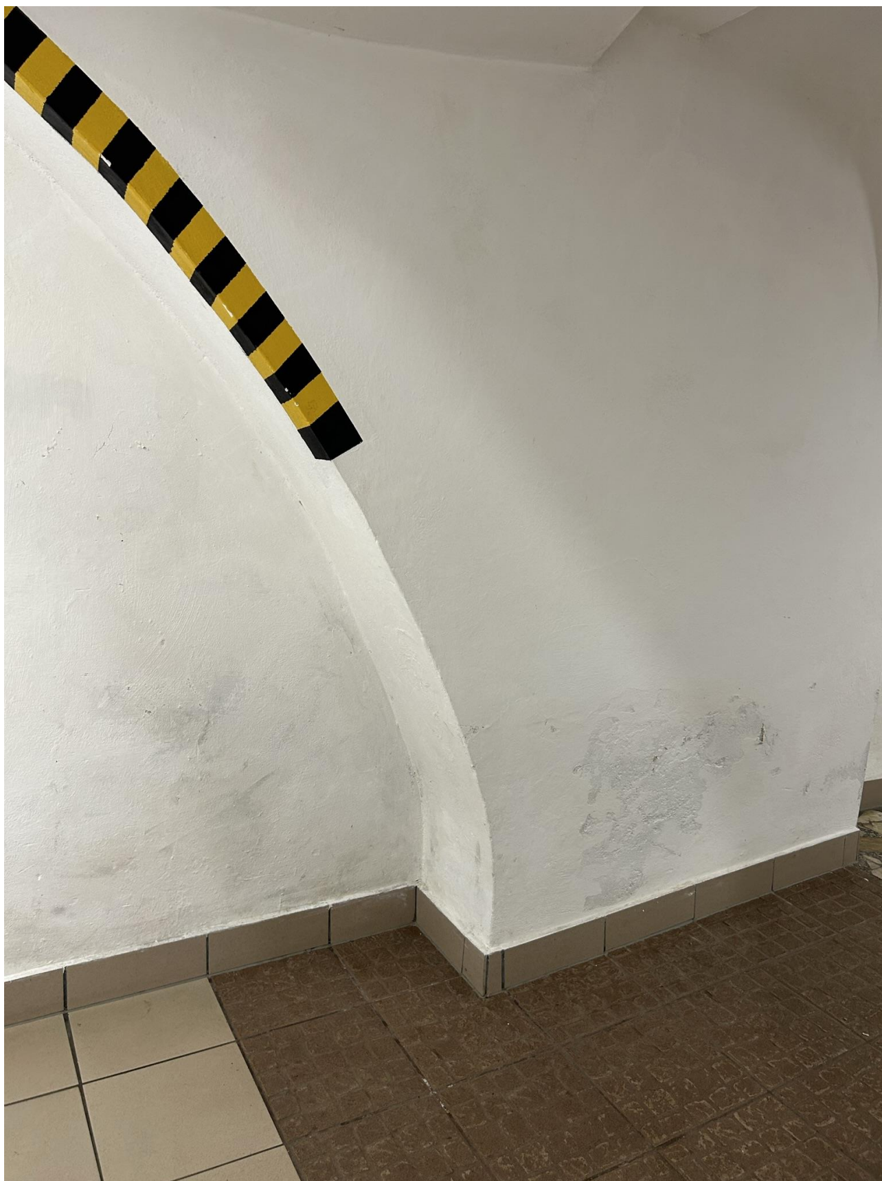
Widoczne zniszczenia spowodowane wilgocią podciąganą kapilarnie
