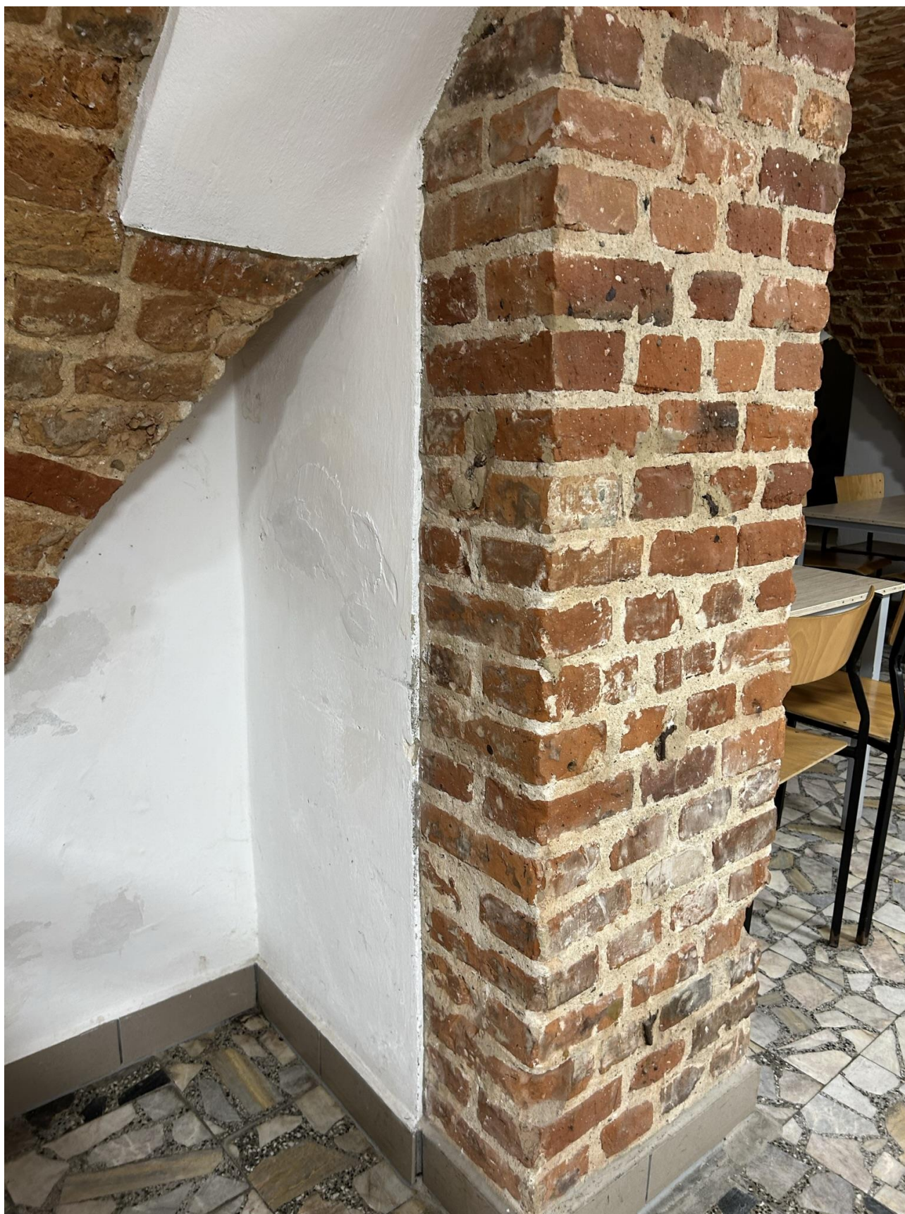
Ściany ceglane i tynkowane- widoczne zawilgocenie tynków z zabrudzenia powierzchni cegieł zaprawą
