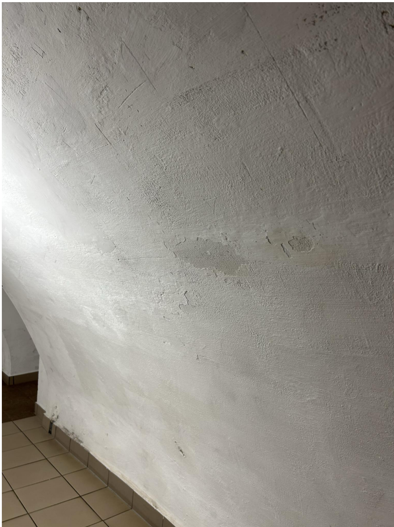
Widoczne wielokrotne naprawy miejscowe
