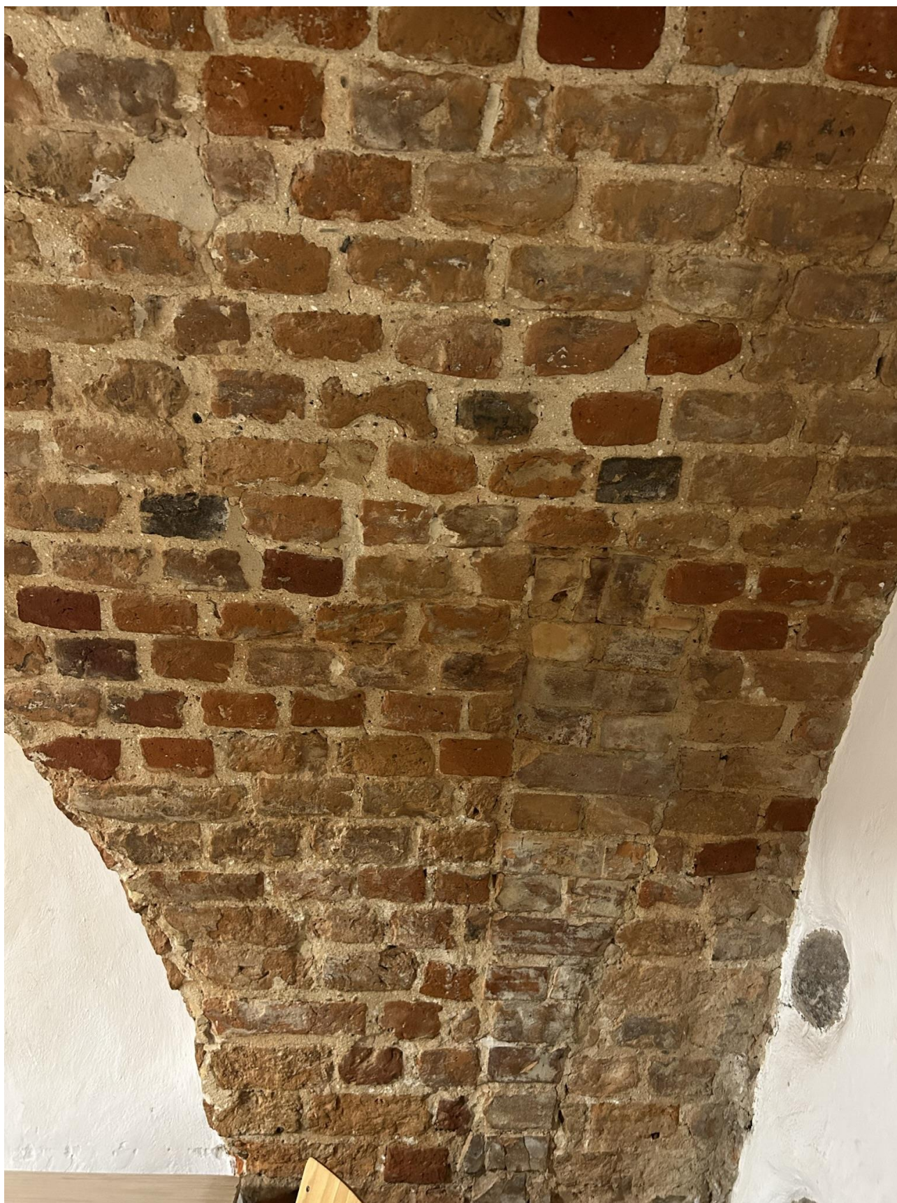
Sklepienie ceglane – widoczne zawilgocenie muru
