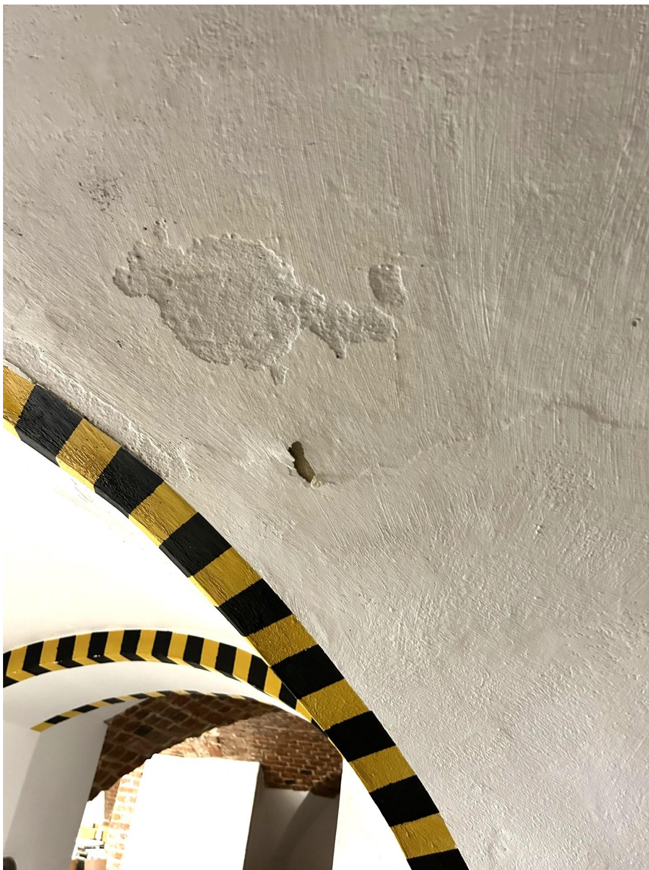
Widoczne zniszczenia spowodowane wilgocią podciąganą kapilarnie
