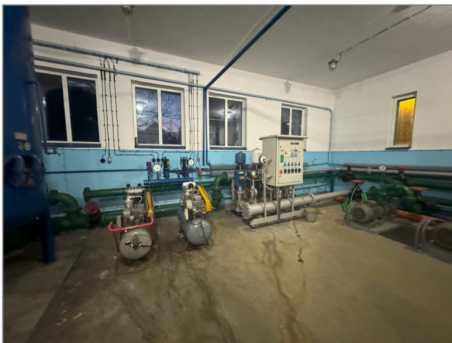
Zdjęcie nr 4. SUW Rososz – zestaw pomp sieciowych, układ dystrybucji powietrza.
