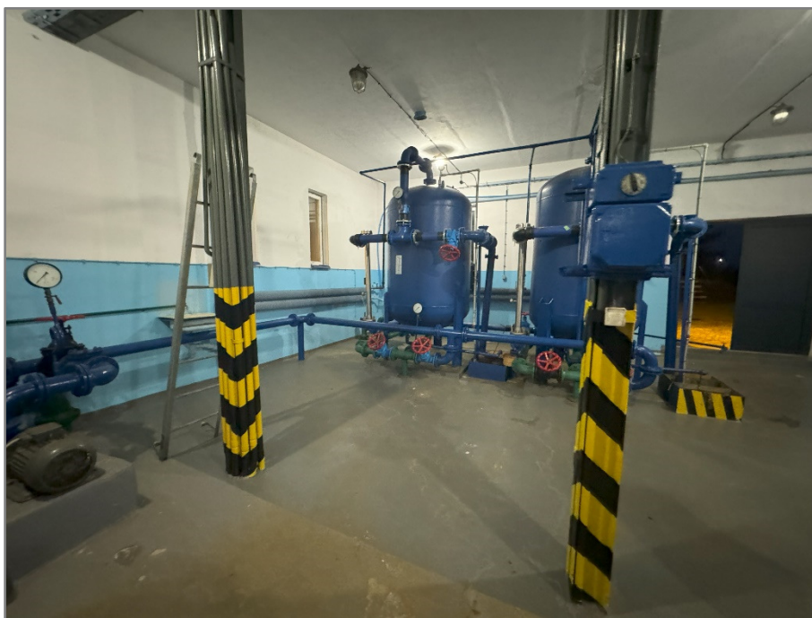
Zdjęcie nr 3. SUW Rososz – układ filtracji ciśnieniowej.
