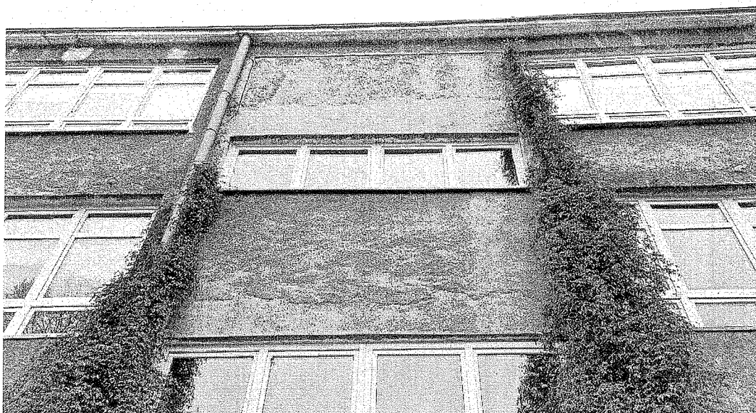
Zdjęcie 3: Widok uszkodzeń tynku.
