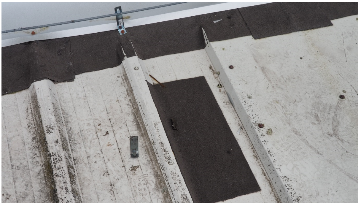
Nowa obróbka blacharska połączona ze starą częścią dachu przy pomocy papy, widać próby poprawy szczelności i częścią wymianę uchwytów instalacji odgromowej.
