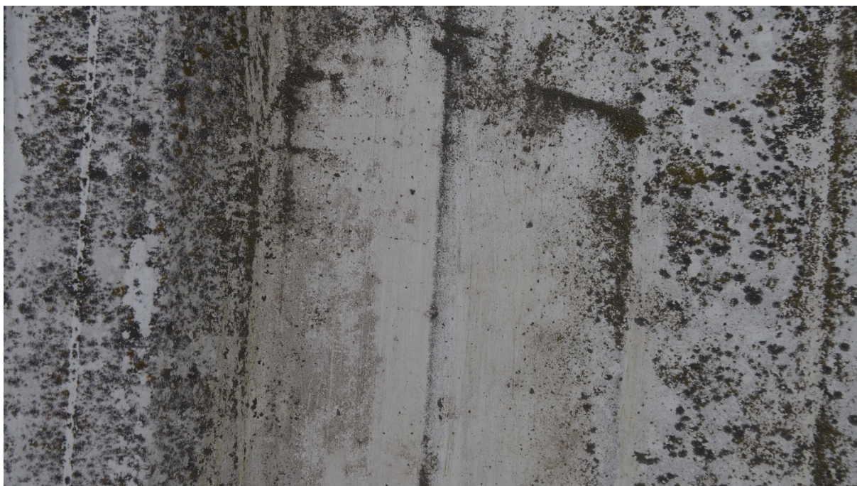
Stara część dachu pokryta licznymi zabrudzeniami, widoczne również rysy – uszkodzenia mechaniczne – do naprawy taśmą dekarską – na dachu nad trybunami na szczęście nieliczne.
