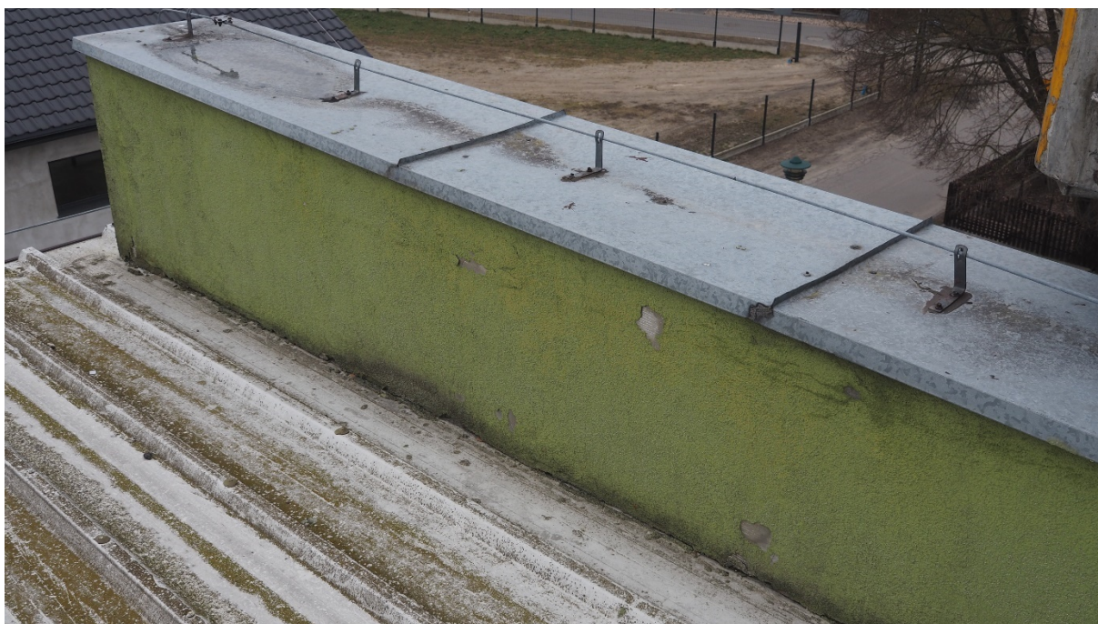
Ściana attyki niepoprawnie połączona z połacią dachu, brak blachy kątovej przyściennej zagraża zaciekaniem wody.
