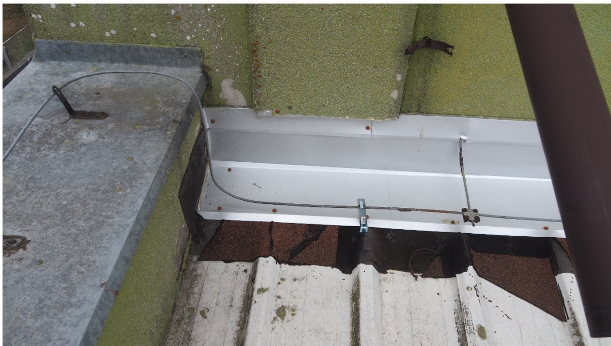
Stara obróbka blacharska attyki budynku oraz nowa obróbka blacharska z nową warstwą papy klejonej do blaszanego pokrycia dachu przy ścianie nad trybunami. Widać także instalację odgromową budynku z wyraźnie korodującymi uchwytami.
