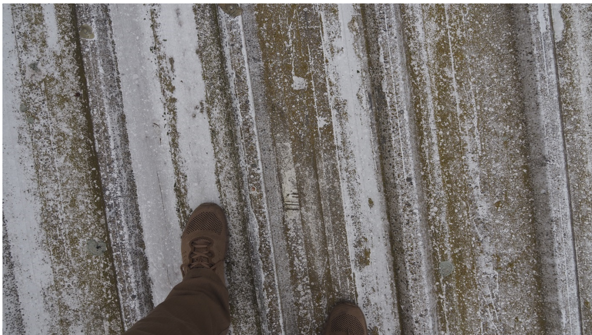
Zabrudzenia organiczne, pyły i sadze pokrywające w znacznym stopniu dachy na niższym poziomie. Są one potencjalnie łatwe do usunięcia, schodzą po przetarciu palcem powierzchni dachu.
