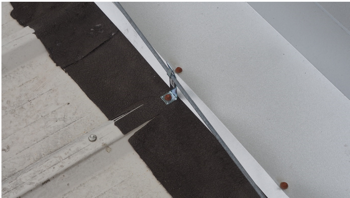
Nowa, poprawnie wykonana obróbka blacharska połączona ze starą połacią dachową.
