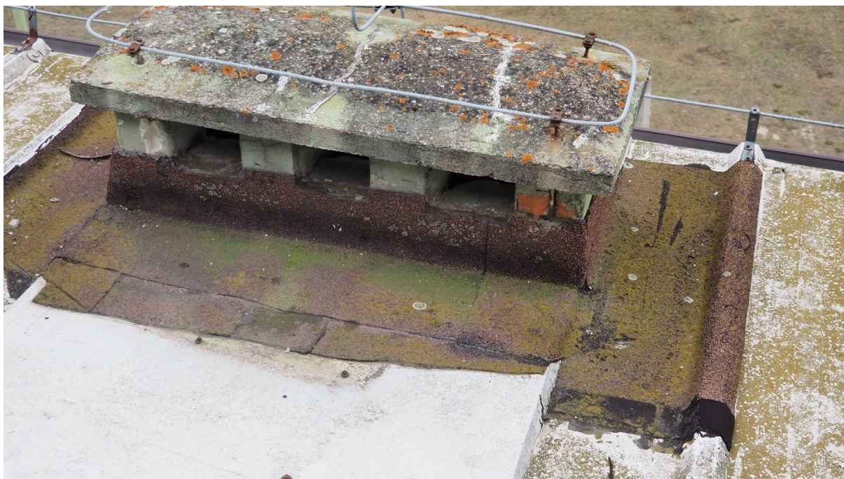
Przeloty komina przez połąć dachową wielokrotnie naprawiane papą dachową, w złym stanie. Pokryte licznymi zabrudzeniami organicznymi.
