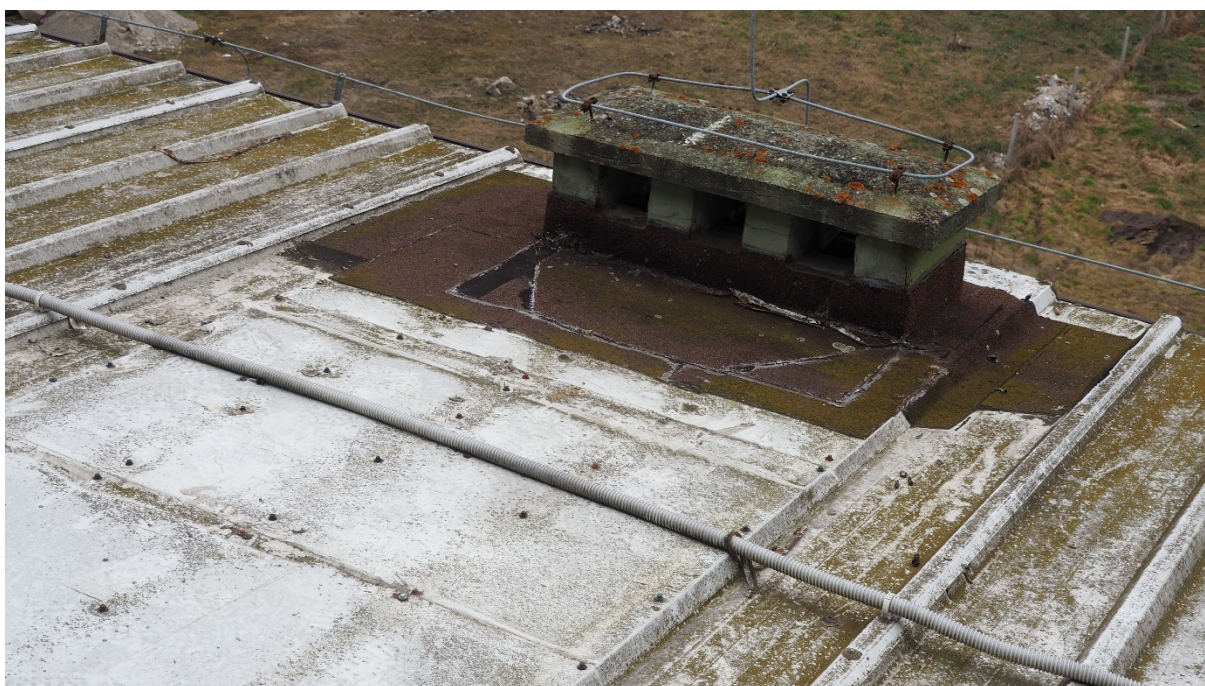
Przeloty komina w złym stanie, po wielokrotnych naprawach papą dachową. Ze względu na zmianę wentylacji z grawitacyjnej na rekuperację proponuje się rozbiórkę kominów powyżej poziomu pokrycia. Zmniejszy to znacznie ubytki ciepła przez niepotrzebne kominy.
