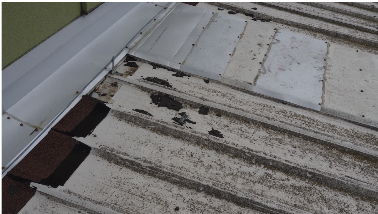
Oblachowanie na dachu częściowo wymienione, częściowo naprawiane, z nową obróbką blacharską przy ścianie na styku dachu z wyższą częścią hali sportowej. Widoczne łączenie nowej obróbki blacharskiej ze starym pokryciem przy użyciu papy.
